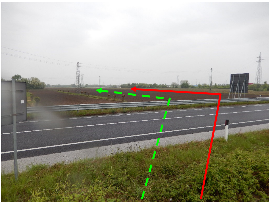
FOTO N.6 - PARALLELISMO CON METANODOTTO DA DISMETTERE (SENSO GAS)
