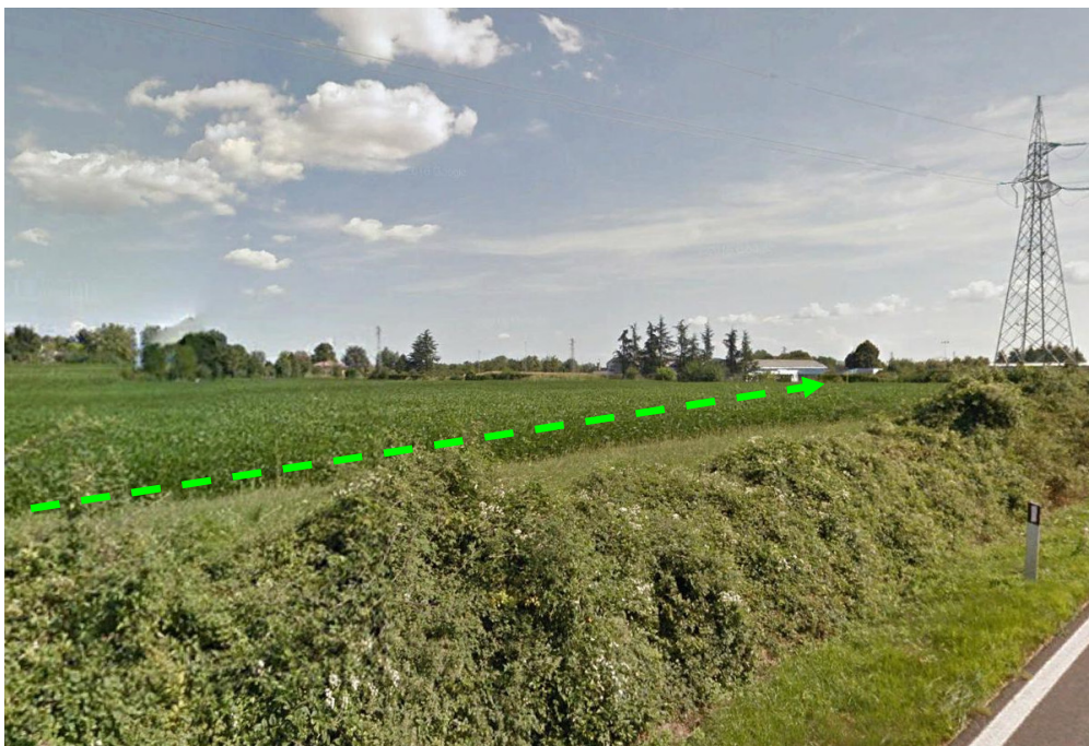
FOTO N.10 - PERCORRENZA METANODOTTO AI MARGINI DI UN TERRENO AGRICOLO
