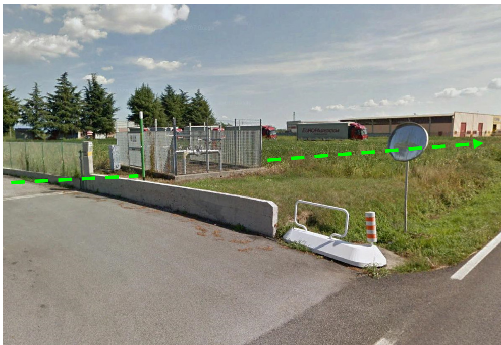
FOTO N.12 - IMPIANTO DA DISMETTERE SU S.R. N.352
