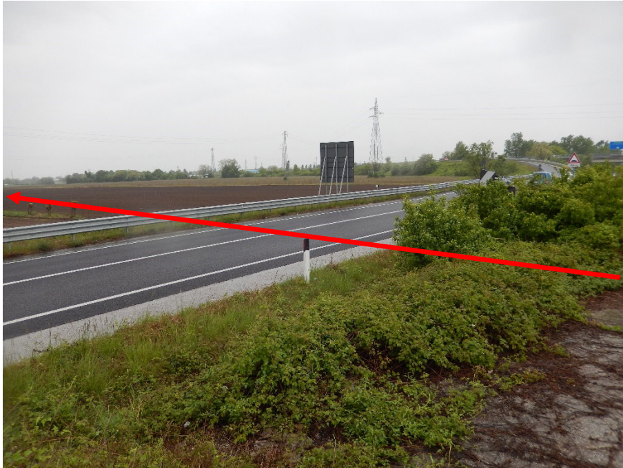
FOTO N.5 - ATTRAVERSAMENTO S.S. N.56
