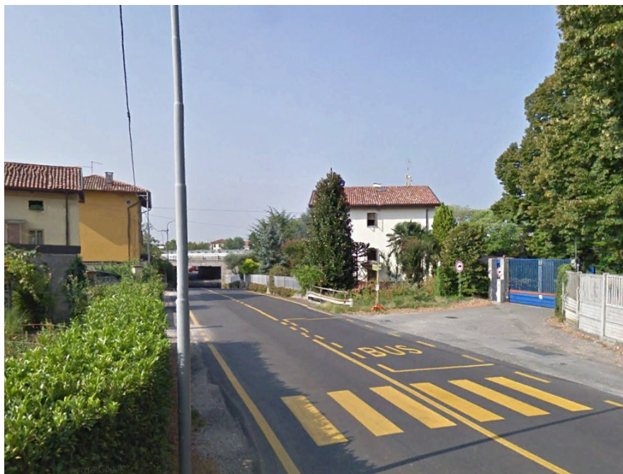
FOTO N.10 – ATTRAVERSAMENTO VIA DELLA ROGGIA
