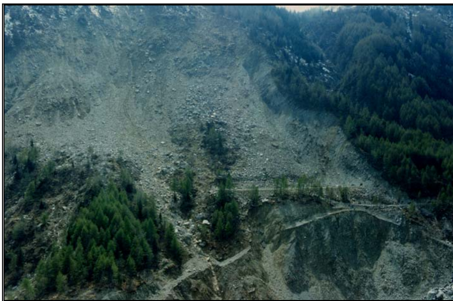
Foto 2.1: pista di cantiere su frana A, oggi non conservata
