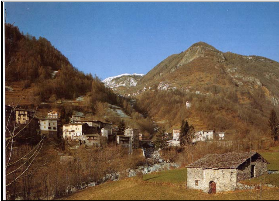
Foto 2.2: tratto terminale Torreggio. Si nota la presenza di bosco ai lati dell'alveo a monte del ponte ad arco distrutto dalla piena
