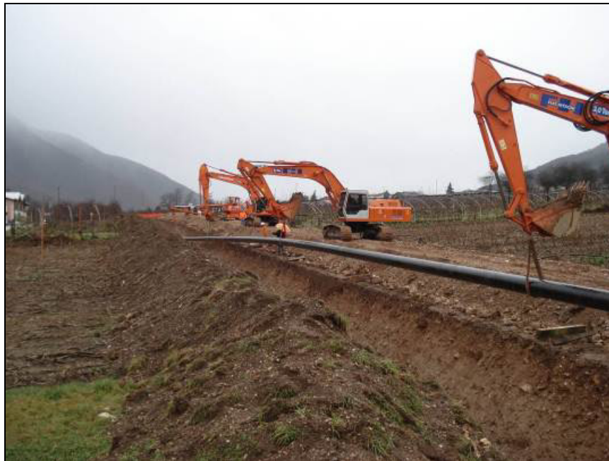
Fig. 8.1.8/A – Posa della condotta
