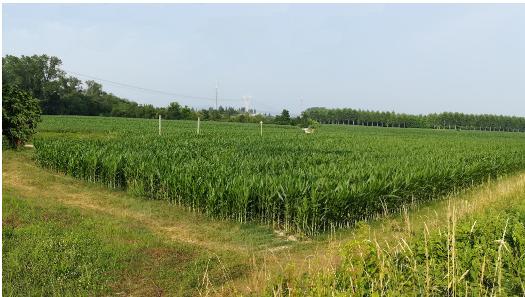
Fig. 3/C: Attraversamento Fiume Torre. Ripristino effettuato anche a seguito della rimozione del ponte aereo esistente
