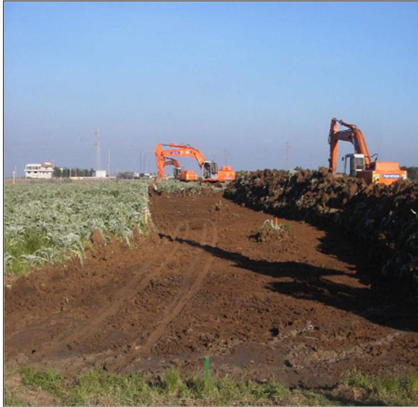
Fig. 8.1.2/A – Foto di apertura della pista di lavoro
