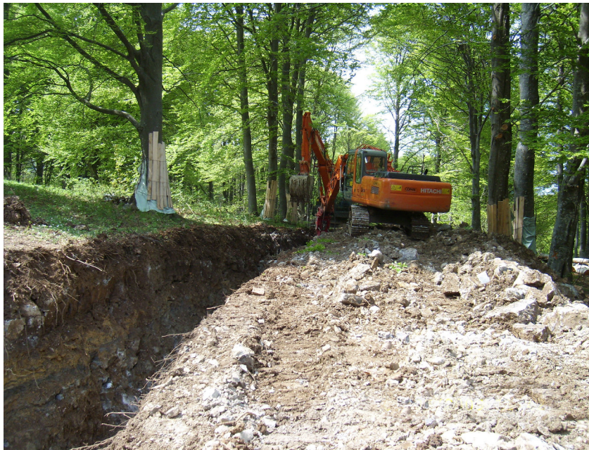
Fig. 8.1.6/A – Foto tipica di scavo della trincea
