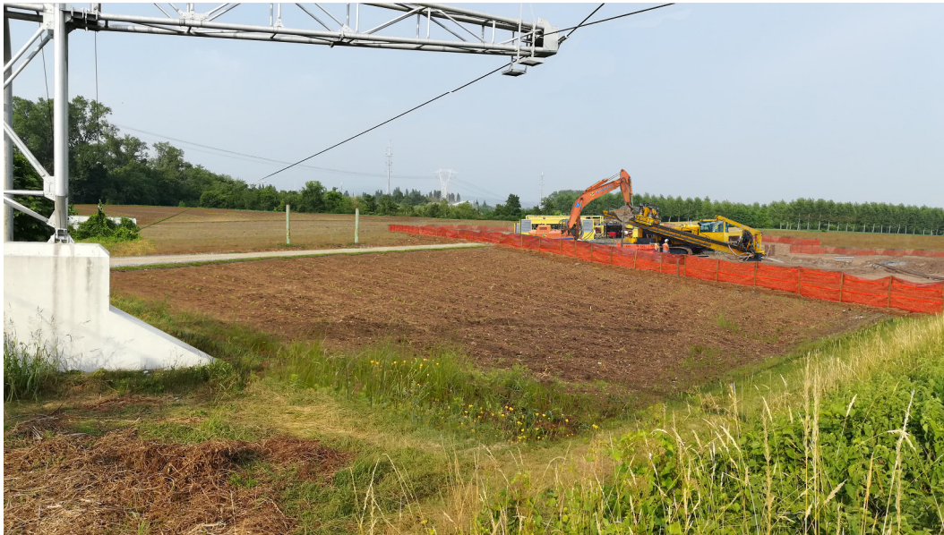
Fig. 3/B: Attraversamento Fiume Torre. Cantiere in corso
