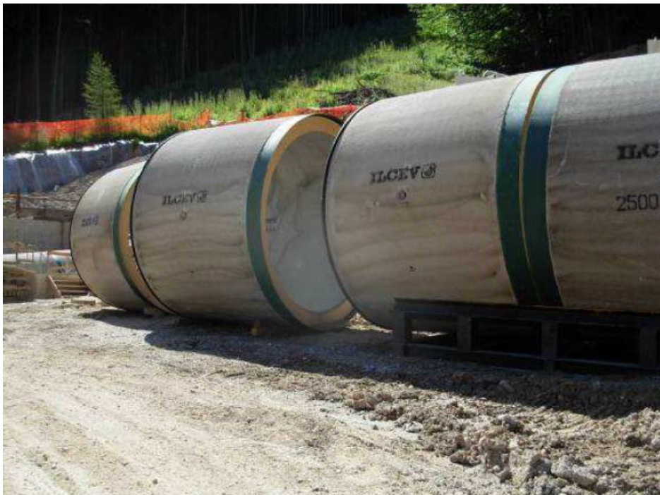
Fig. 8.1.10/H – Stoccaggio tubi in c.a.
