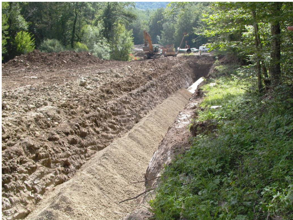
Fig. 8.1.8/B –Rinterro della condotta
