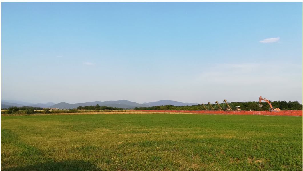
Fig. 3/B: Cantiere in corso
