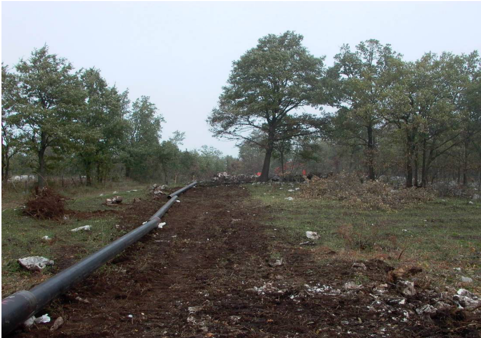
Fig. 8.1.4/A –Sfilamento tubazioni
