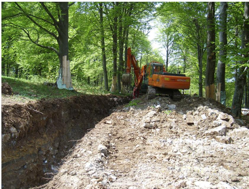
**Fig. 3.1.5/A** – Foto tipica di scavo della trincea
