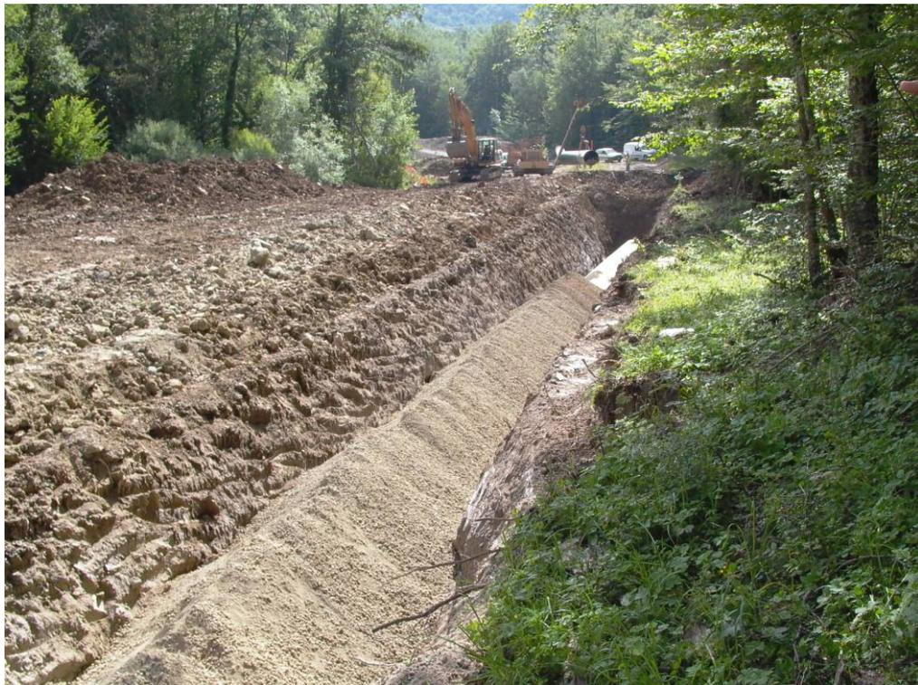
**Fig. 3.1.7/B** –Rinterro della condotta
