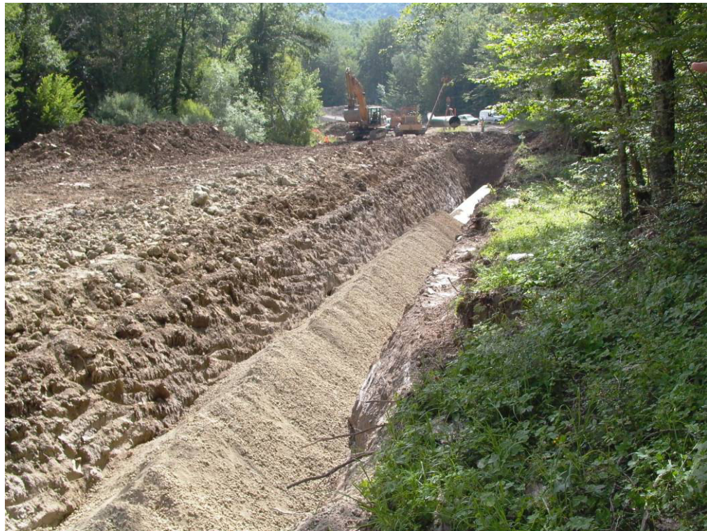
Fig. 2.3.4/B – Rinterro della condotta
