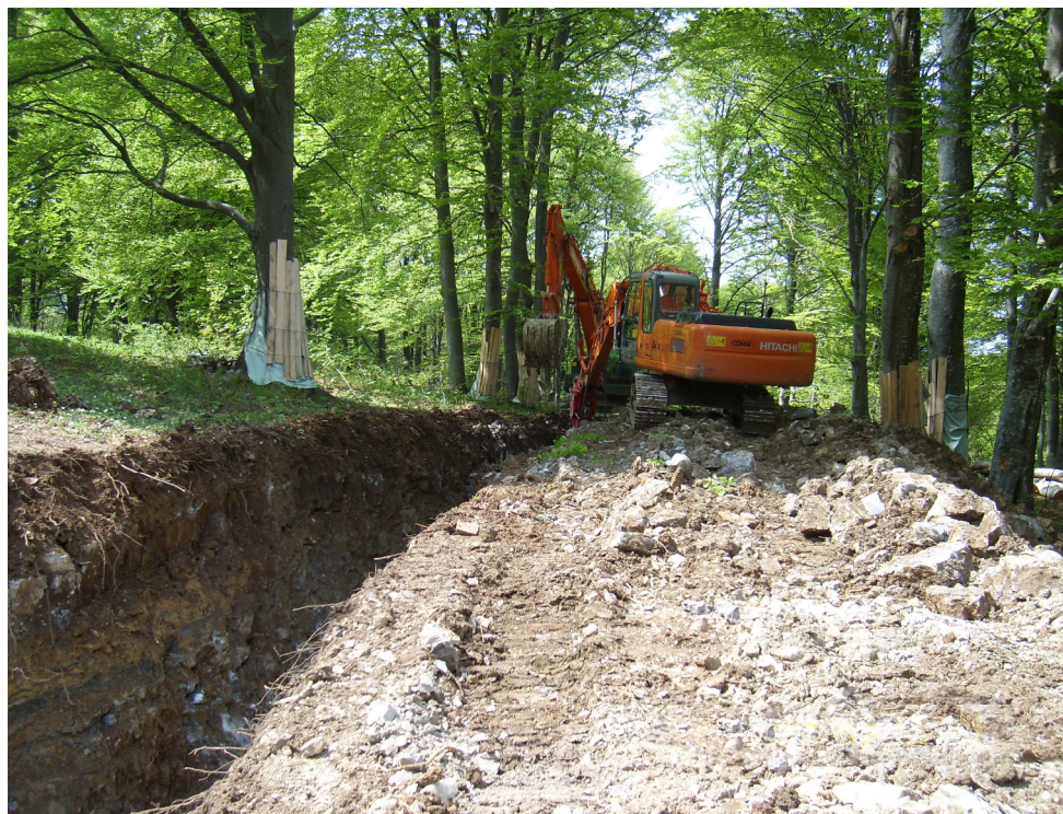
Fig. 2.3.3/A – Foto tipica di scavo della trincea
