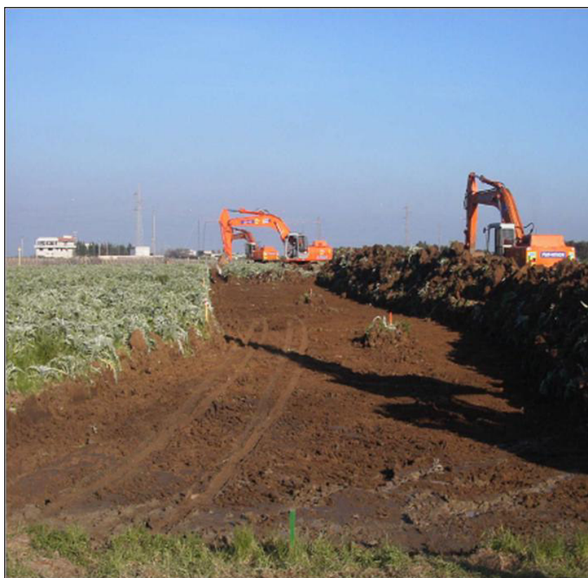
Fig. 2.3.2/A – Foto di apertura dell'area di passaggio
