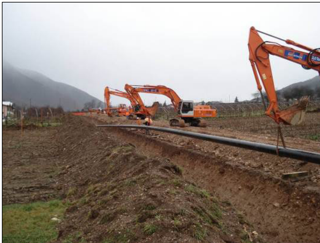
Fig. 2.3.4/A – Posa della condotta
