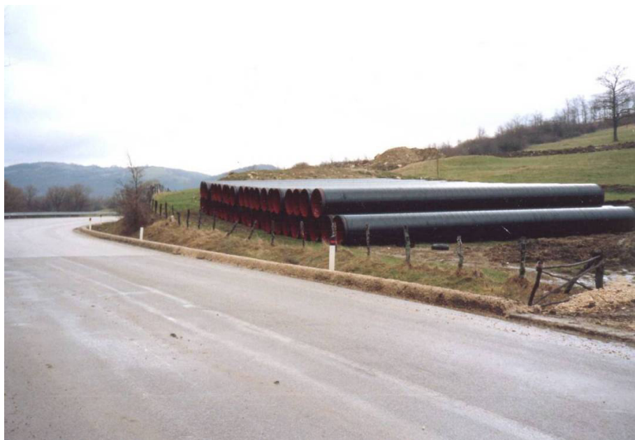
Fig. 2.3.1/A – Foto tipica di una piazzola per accatastamento tubazioni
