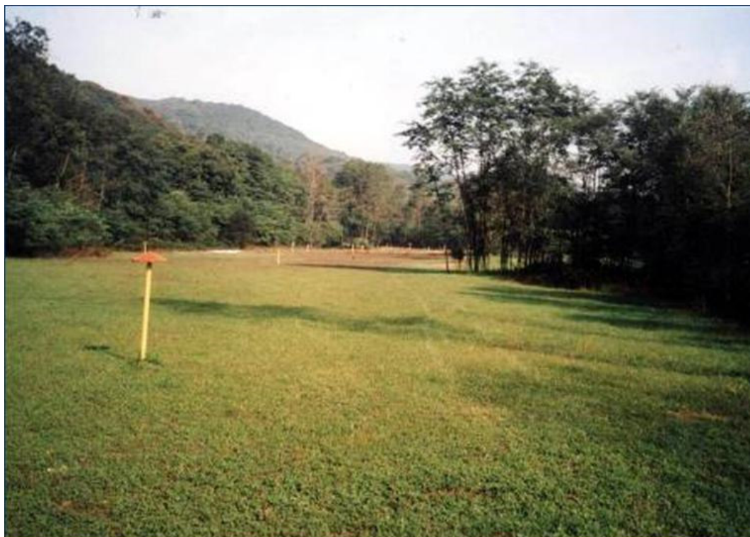
Fig. II 4.6.12/A – Pista lavori a ripristini ultimati su un gasdotto in esercizio
