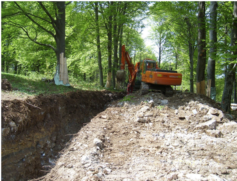
Fig. II 4.6.6/A – Foto tipica di scavo della trincea
