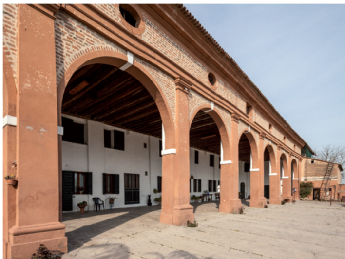
Fig. III 1.6/E - Barchessa con portico
