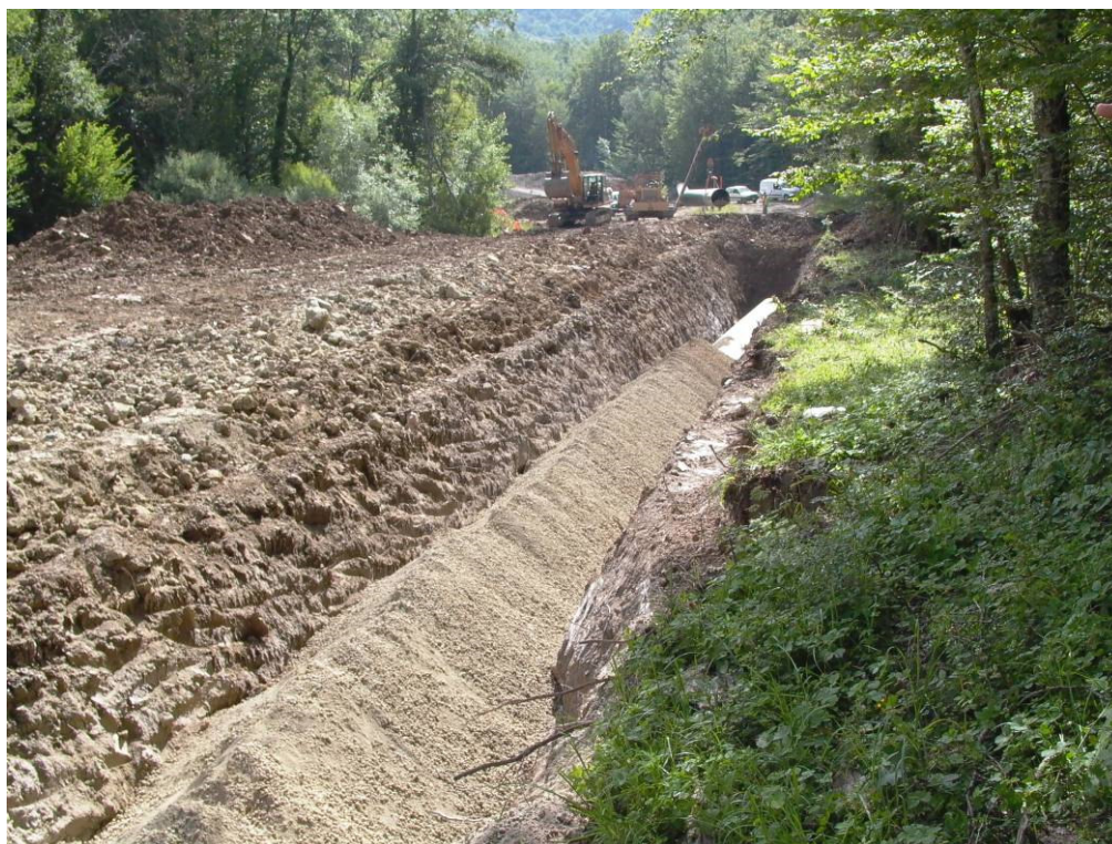
Fig. II 4.6.8/B –Rinterro della condotta
