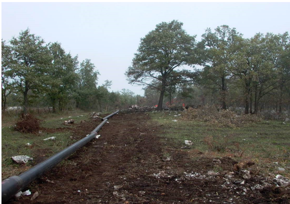
Fig. II 4.6.4/A –Sfilamento tubazioni
