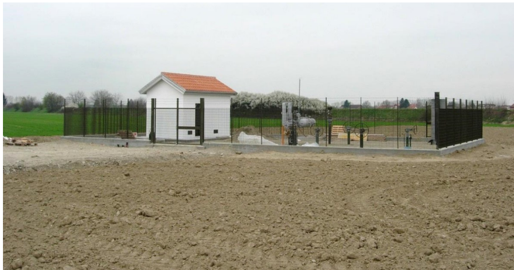
Fig. II 4.6.10/A – Esempio di Punto di Intercettazione di Linea (PIL) telecomandato
