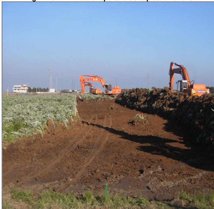
Fig. II 4.6.2/A – Foto di apertura della pista di lavoro
