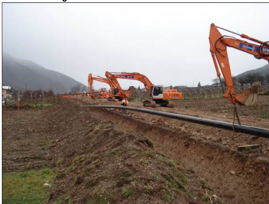
Fig. II 4.6.8 – Posa della condotta
