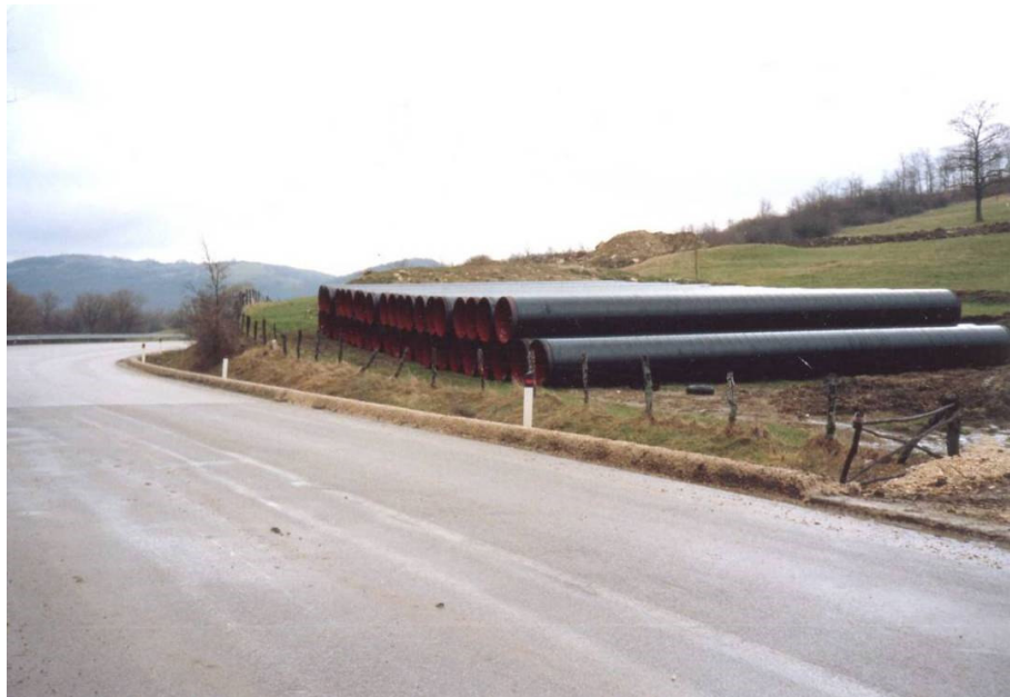
Fig. II 4.6.1/A – Foto tipica di una piazzola per accatastamento tubazioni
