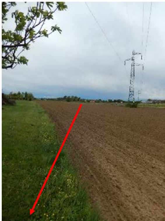
FOTO N.8 - PASSAGGIO METANODOTTO VICINO A LEAT
