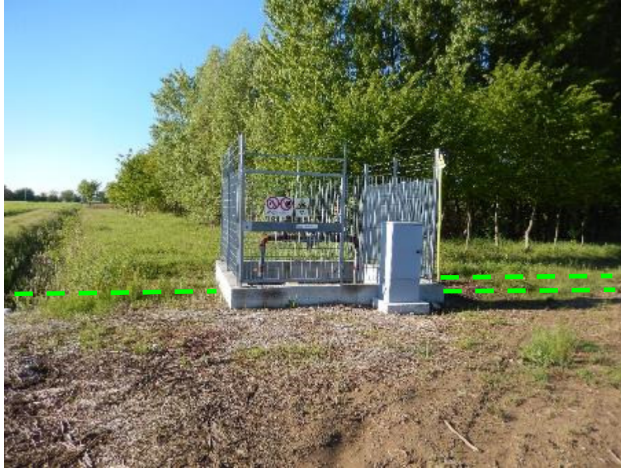
FOTO N.1 - IMPIANTO N. 4100972.1 DA DISMETTERE
