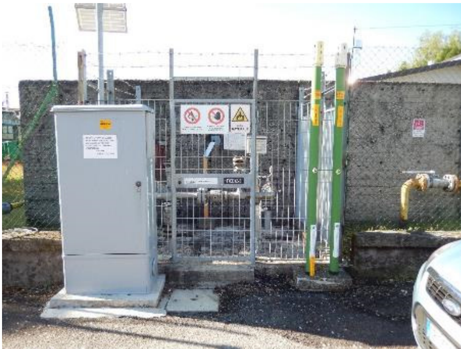
FOTO N.8 - IMPIANTO N.4100972.2 DA DISMETTERE
