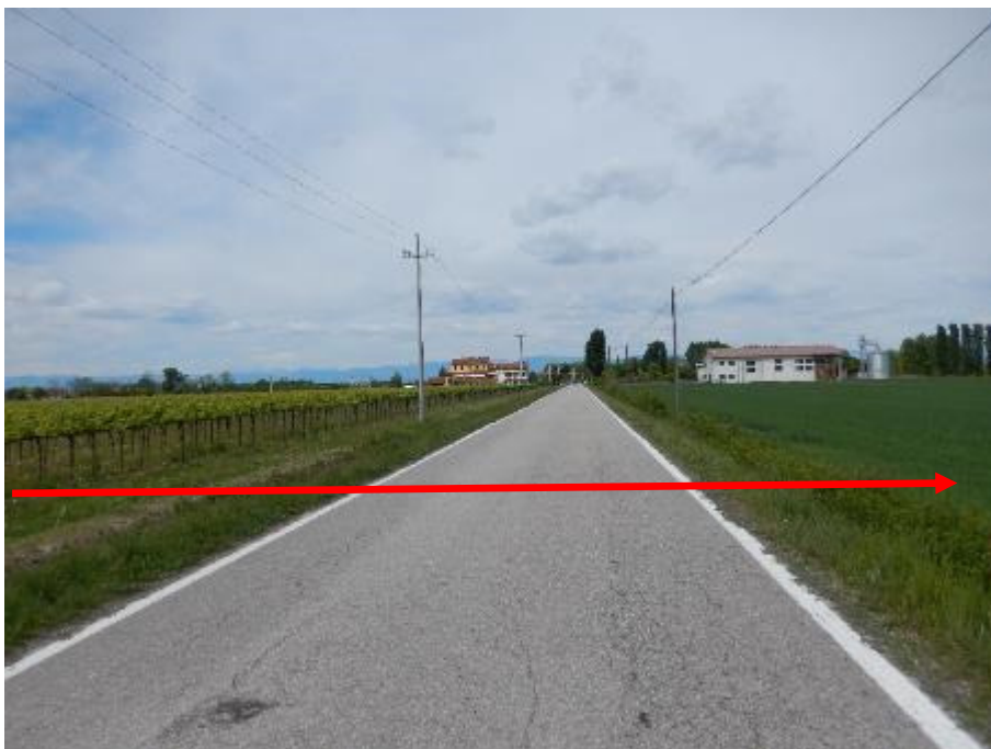
FOTO N.4 - ATTRAVERSAMENTO VIA CONCHE
