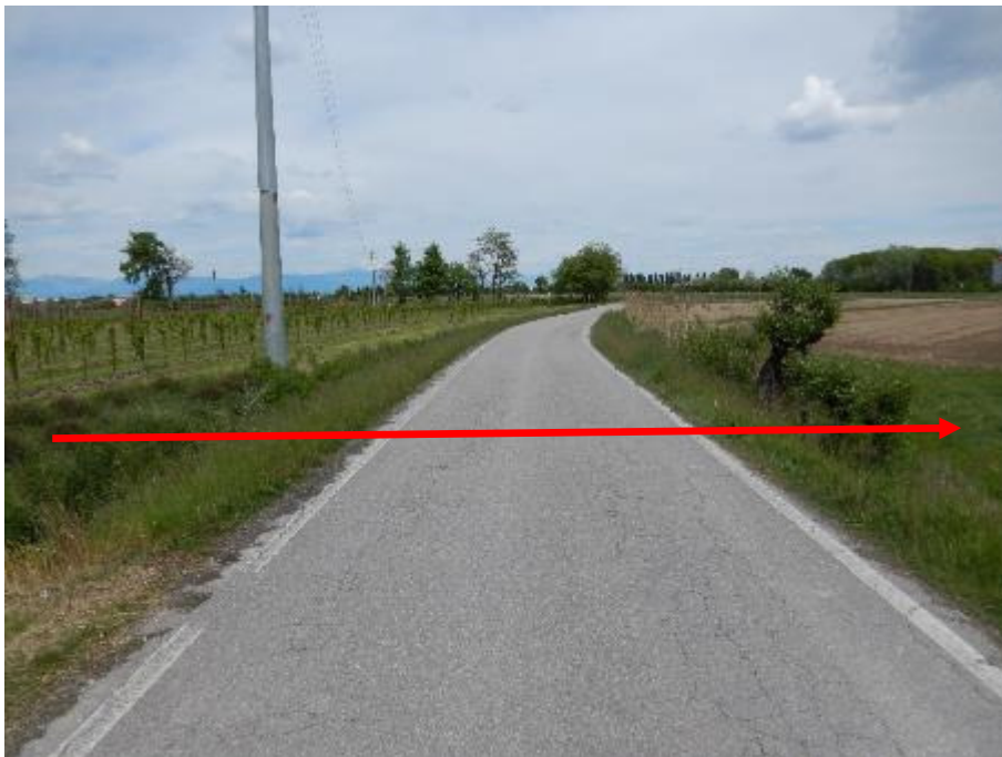
FOTO N.3 - ATTRAVERSAMENTO VIA MONTIRON
