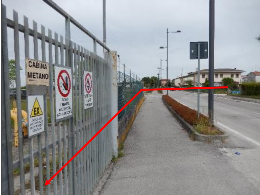
FOTO N.3 - ATTRAVERSAMENTO VIA GUAIANE
