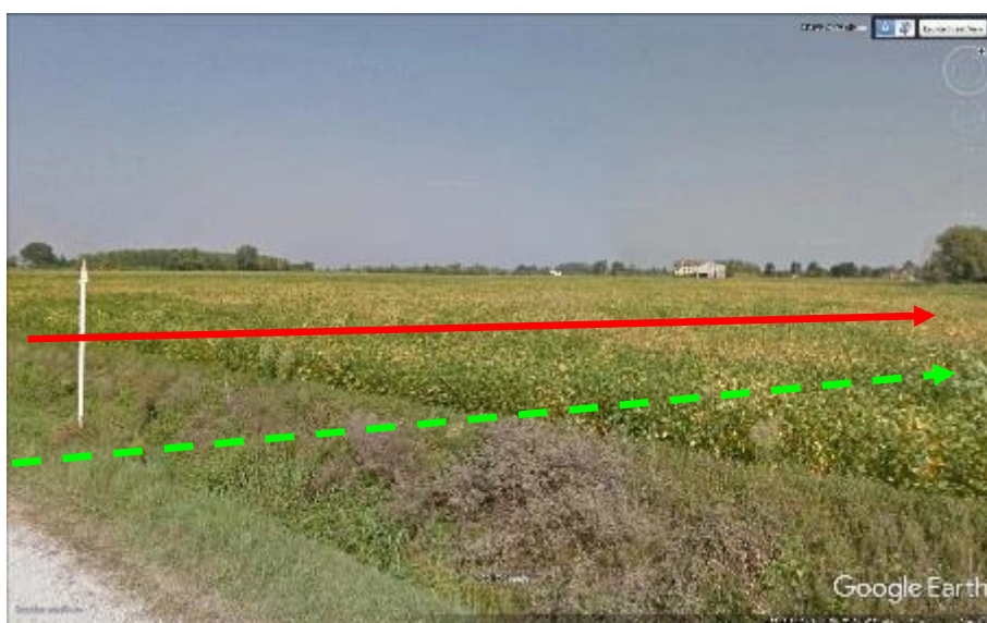
FOTO N.92 - PANORAMICA METANODOTTI IN PARALLELISMO
