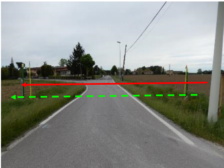
FOTO N.44 - ATTRAVERSAMENTO STRADA COMUNALE
