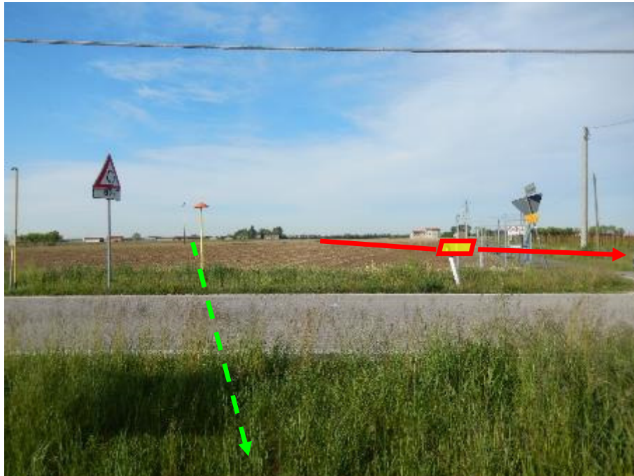
FOTO N.63 - ATTRAVERSAMENTO S.P. N.127
