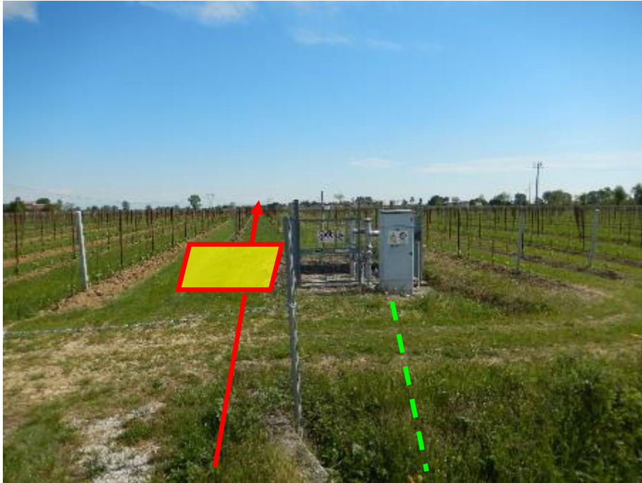
FOTO N.79 - IMPIANTO N.45870.6 DA DISMETTERE E INSTALLAZIONE NUOVO IMPIANTO
