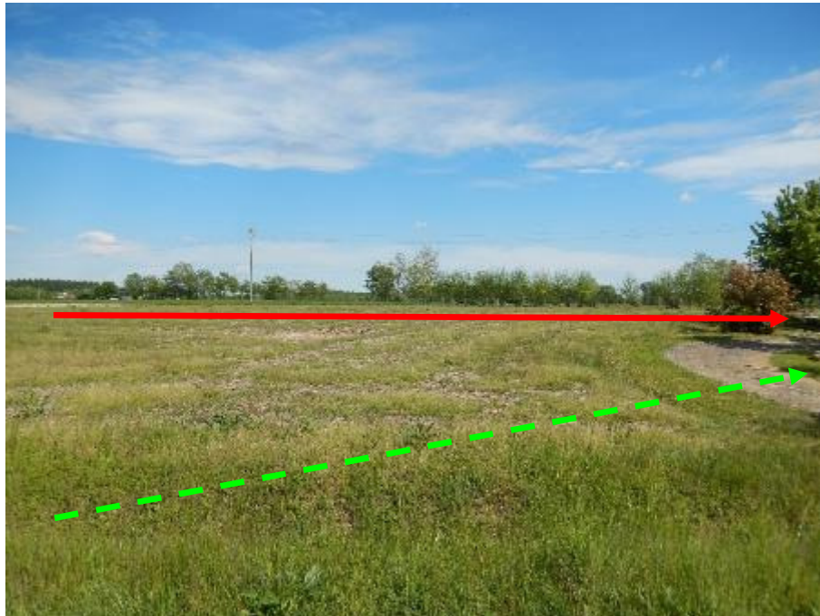
FOTO N.99 - PERCORRENZA METANODOTTO (SENSO GAS)
