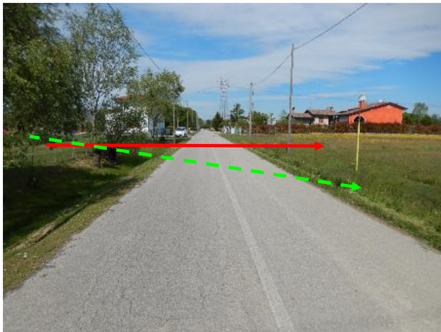
FOTO N.74 - ATTRAVERSAMENTO VIA GIÀ DI PRACURTE
