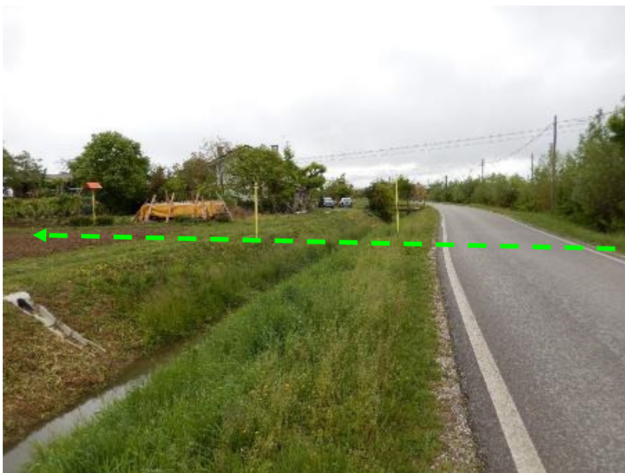
FOTO N.12 - ATTRAVERSAMENTO VIA CARBONCINE
