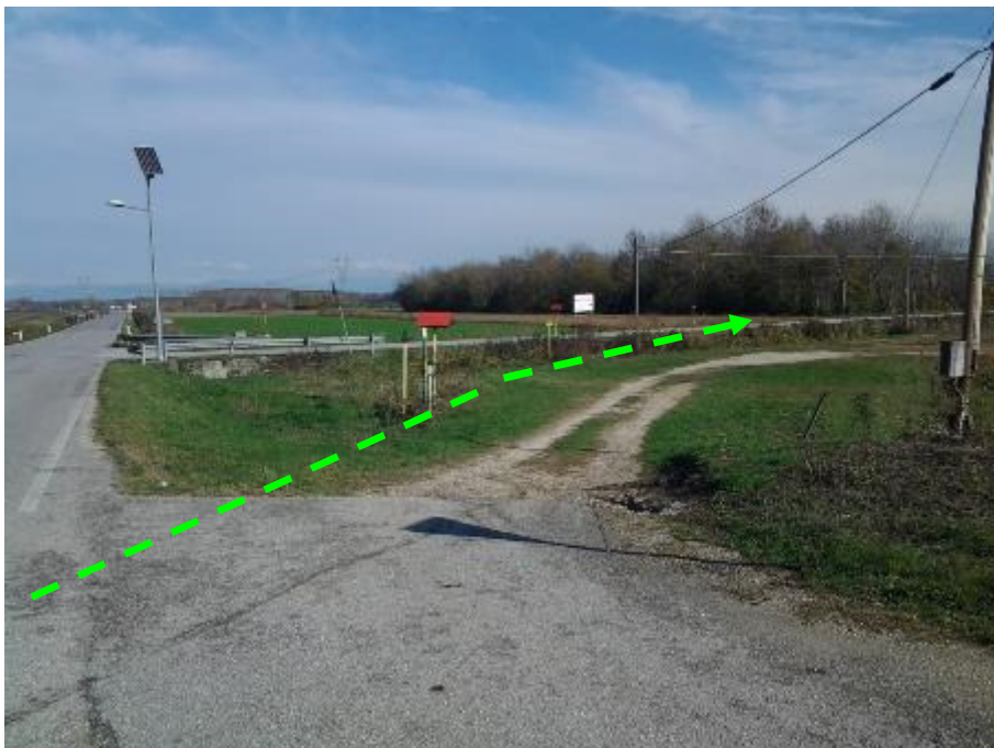
FOTO N.150 - PANORAMICA SENSO GAS MET. DA DISMETTERE
