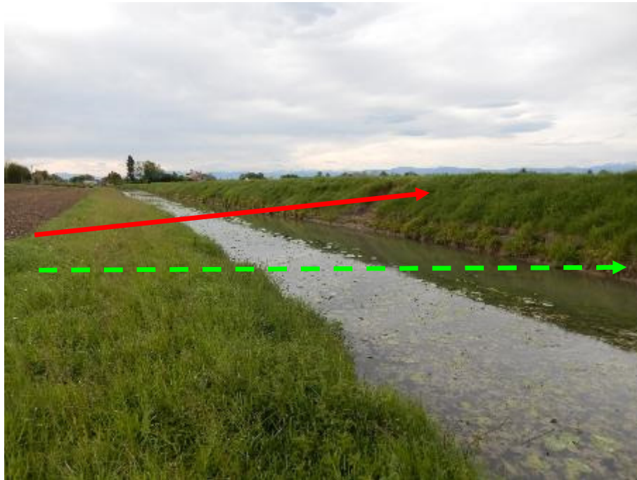
FOTO N.51 - ATTRAVERSAMENTO C.LE PIAVON
