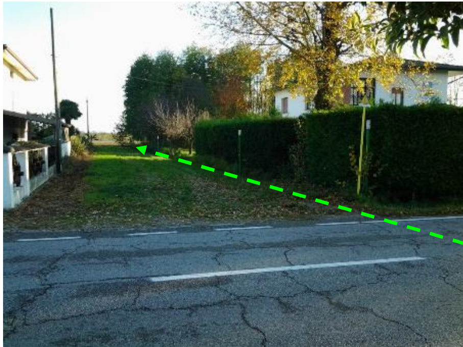
FOTO N.137 - PANORAMICA SENSO GAS MET. DA DISMETTERE
