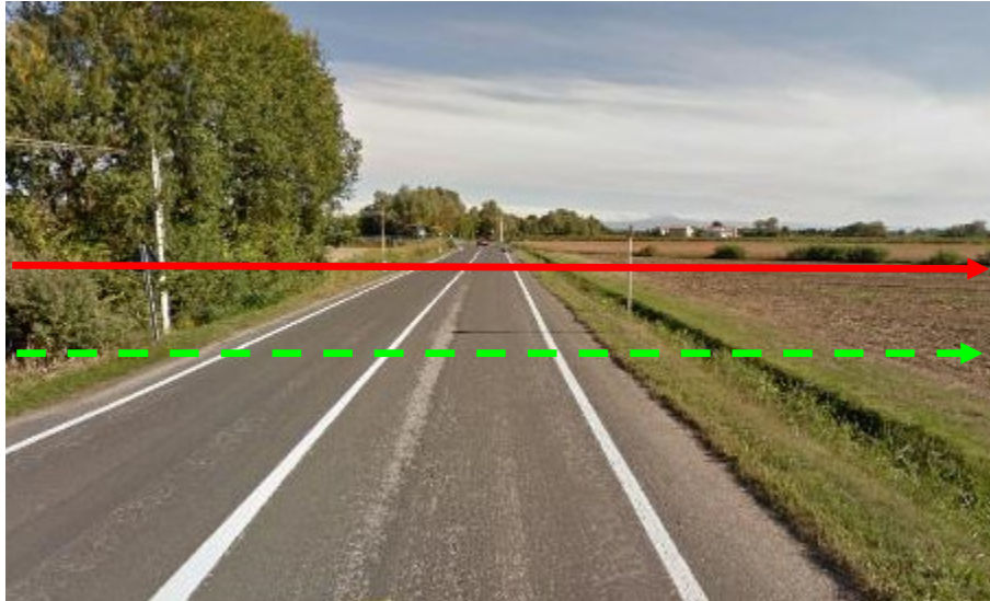
FOTO N.129 - ATTRAVERSAMENTO S.P. N.39
