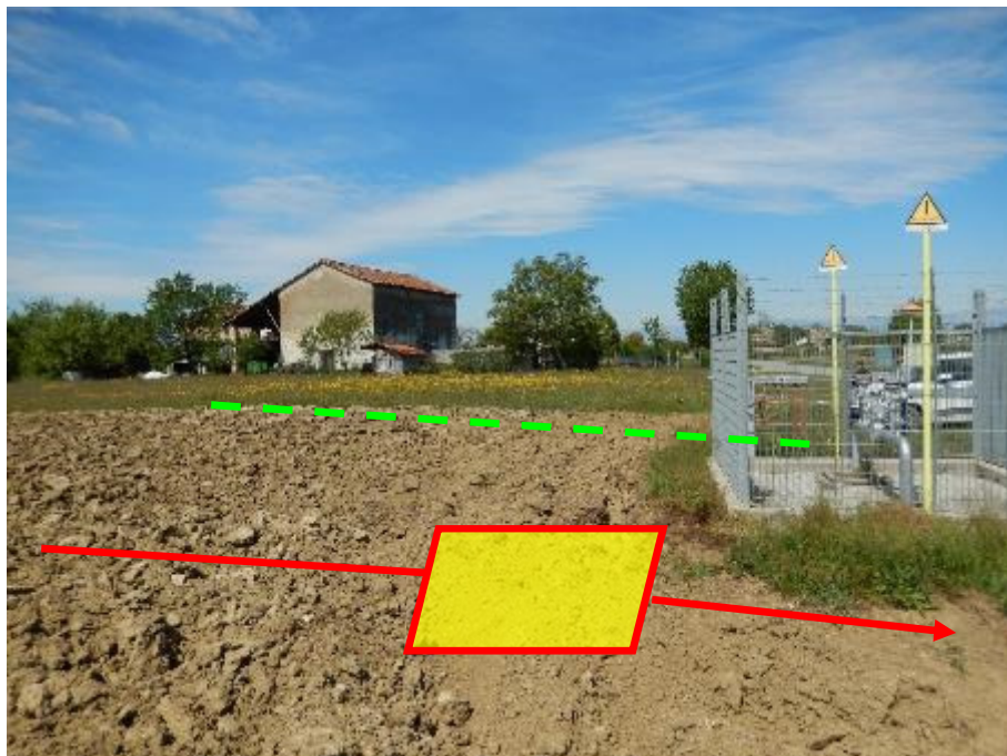
FOTO N.88 - INSTALLAZIONE PIDS 7A
