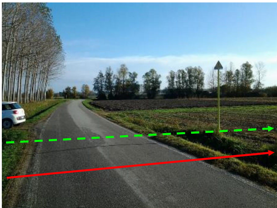
FOTO N.138 - ATTRAVERSAMENTO STRADA COMUNALE
