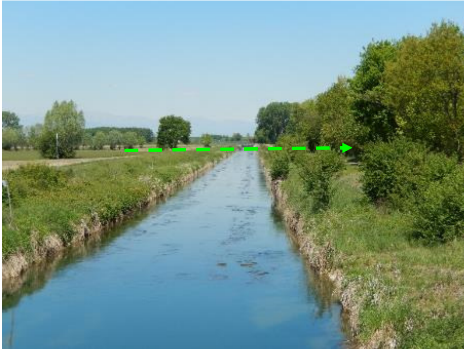
FOTO N.93 - ATTRAVERSAMENTO IN TRENCHLESS C. LE NUOVO REGHENA
