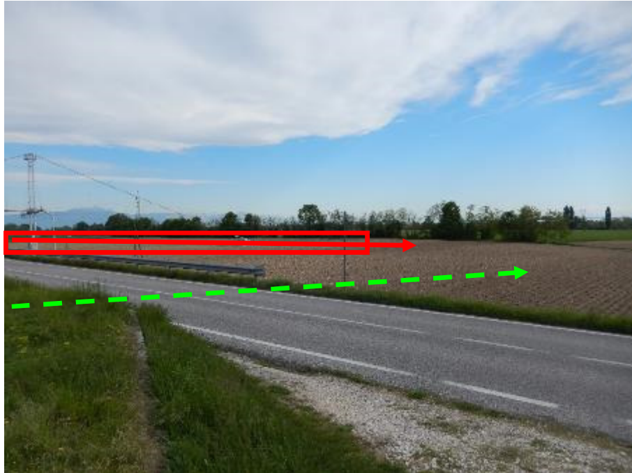
FOTO N.67 - ATTRAVERSAMENTO AEREO DA DISMETTERE
