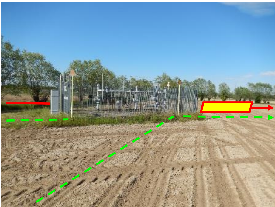
FOTO N.106 - IMPIANTO N.45870.2 DA DISMETTERE E NUOVO IMPIANTO IN PROGETTO
