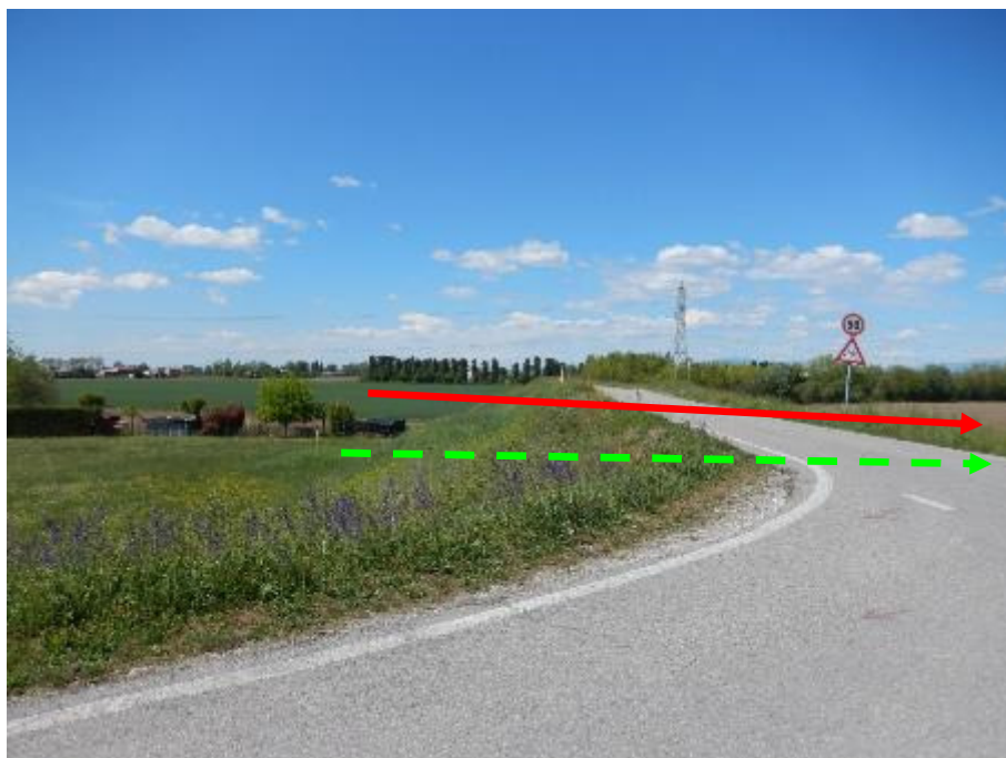
FOTO N.32 - ATTRAVERSAMENTO VIA DELL'ANSA
