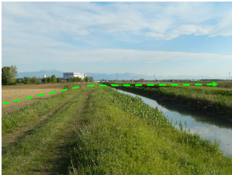
FOTO N.60 - ATTRAVERSAMENTO C. LE BRIAN
