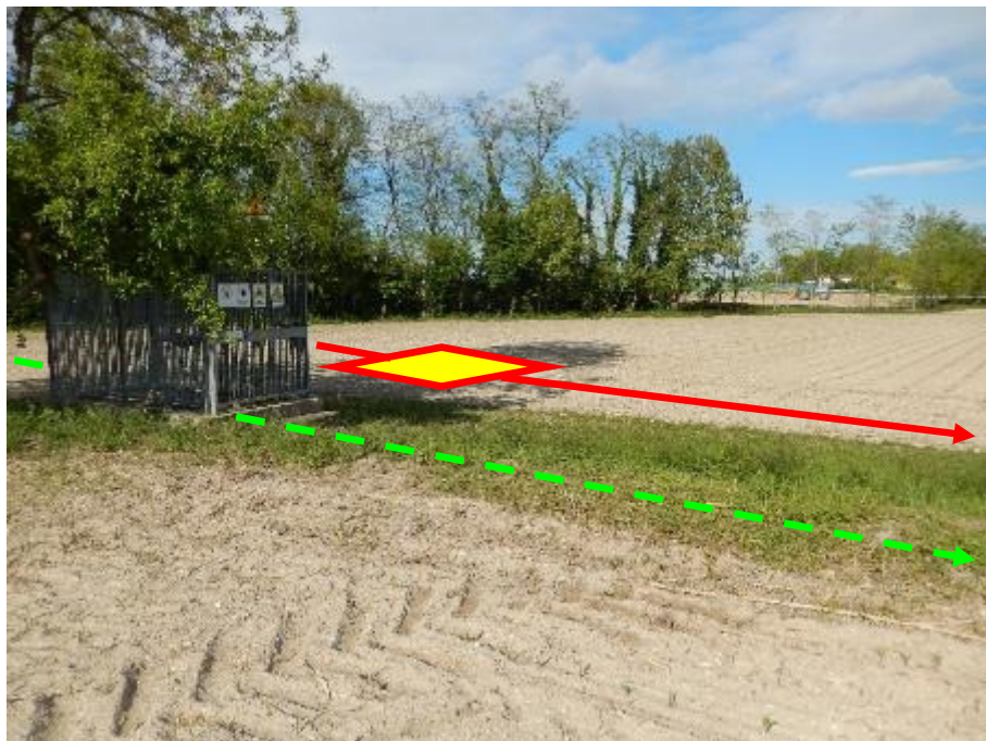
FOTO N.120 - IMPIANTO N.4140124.1 DA DISMETTERE
