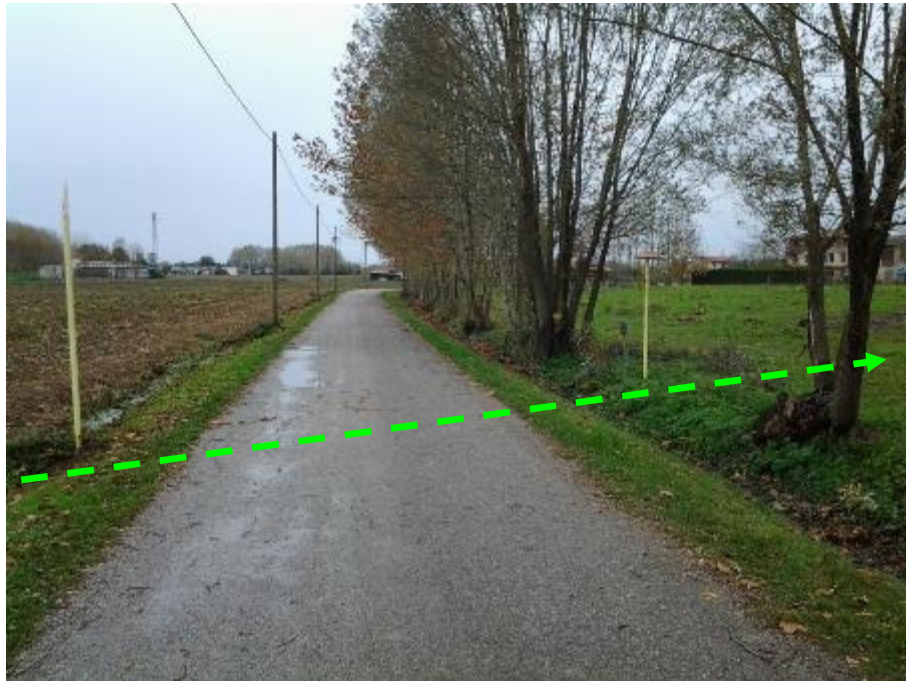
FOTO N.115 - ATTRAVERSAMENTO VIA VENCHIAREDO
