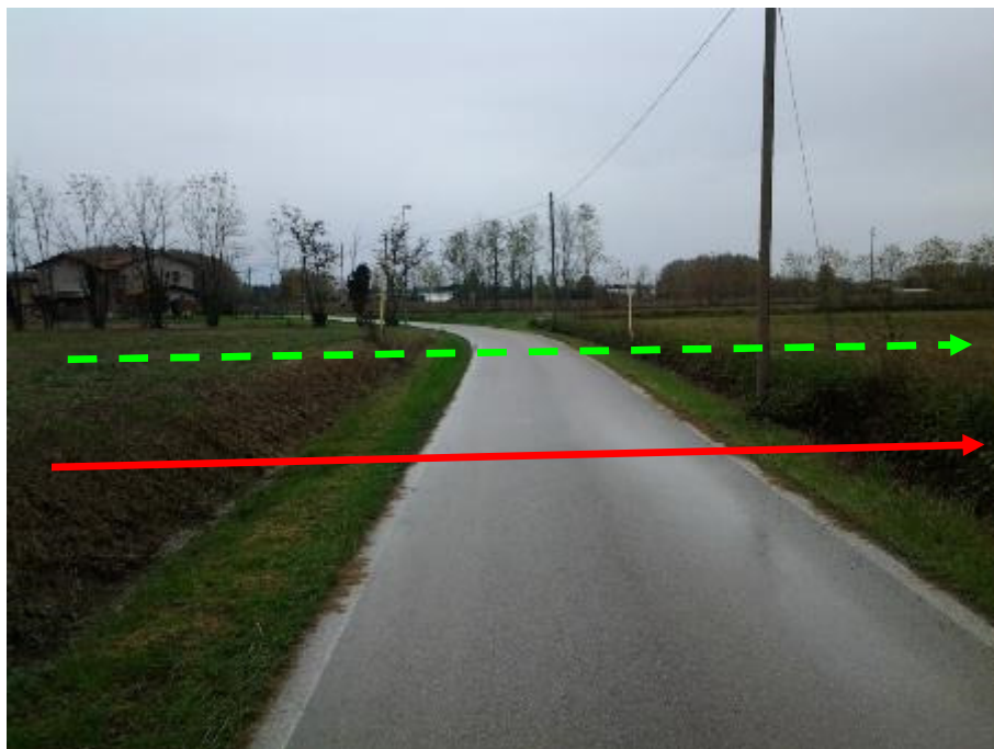
FOTO N.116 - ATTRAVERSAMENTO VIA ONEIDI
