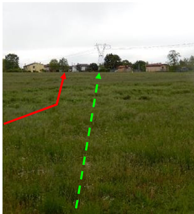
FOTO N.6 - PANORAMICA SENSO GAS MET. DA DISMETTERE
