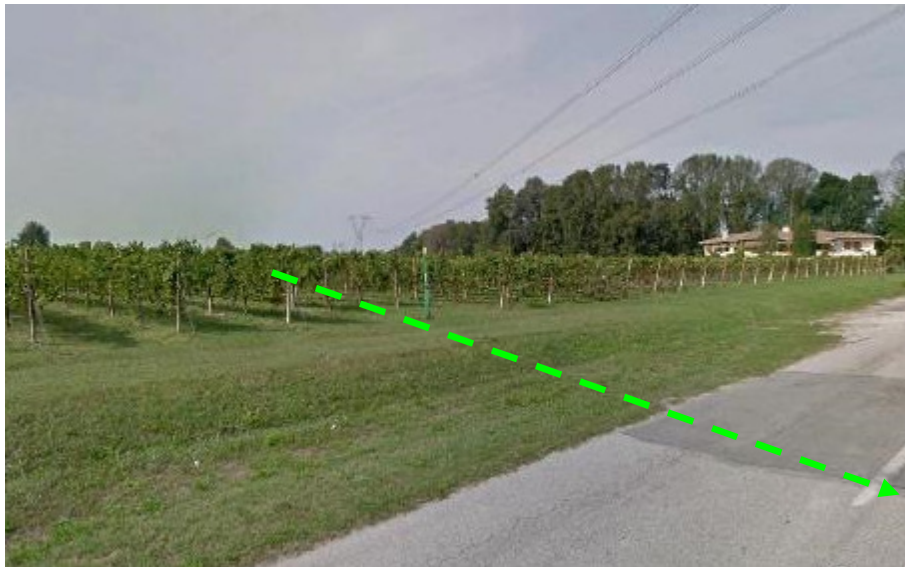
FOTO N.82 - MET. DA DISMETTERE ALL'INTERNO DI UN VIGNETO
