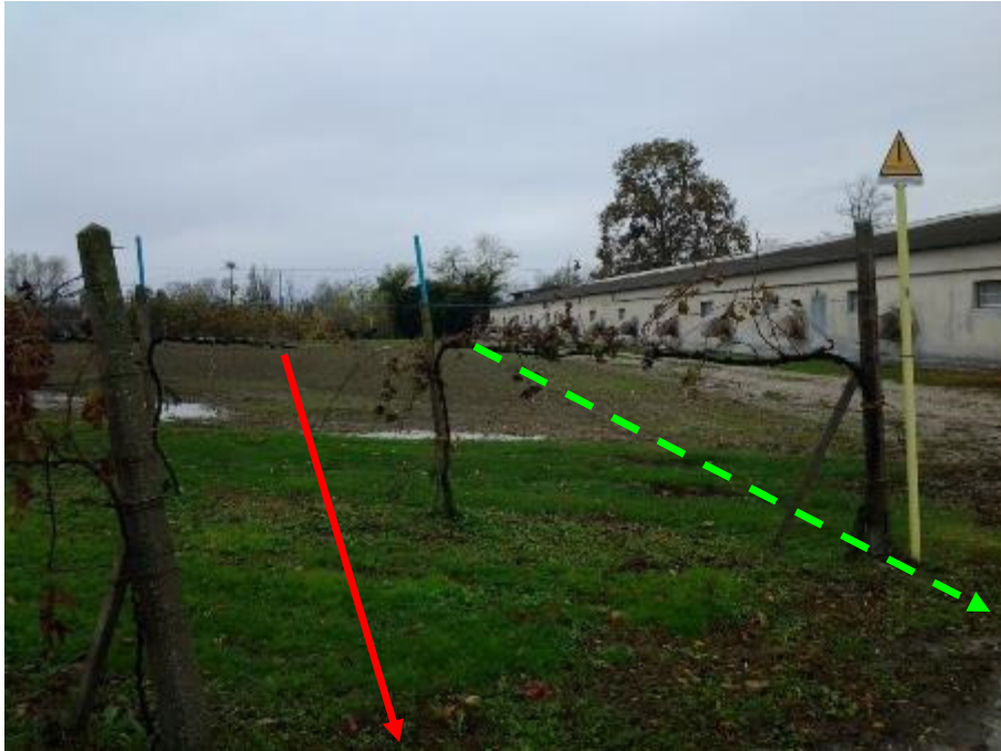
FOTO N.109 - PANORAMICA CONTRO SENSO GAS MET. DA DISMETTERE
