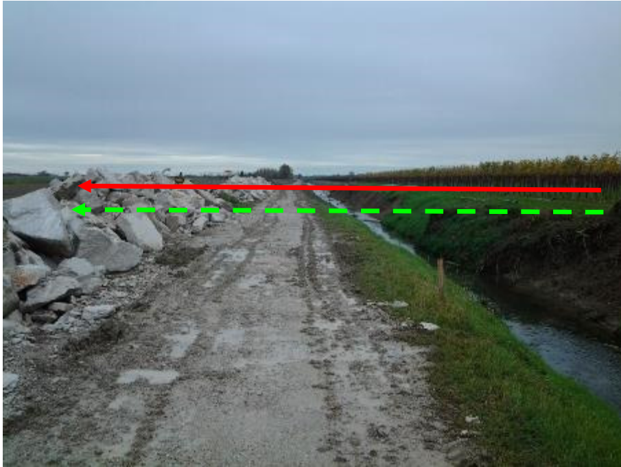
FOTO N.111 - ATTRAVERSAMENTO ROGGIA BELVEDERE DA DISMETTERE
