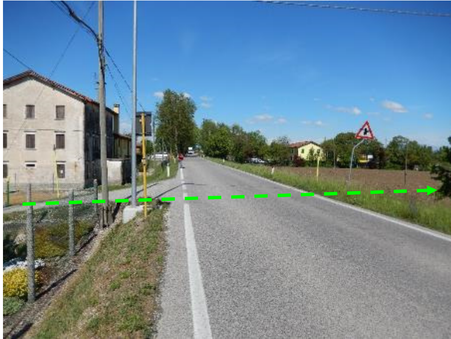
FOTO N.29 - MET. DA DISMETTERE SU S.P. N.57
