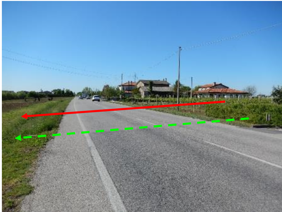
FOTO N.23 - ATTRAVERSAMENTO S.P. N. 64
