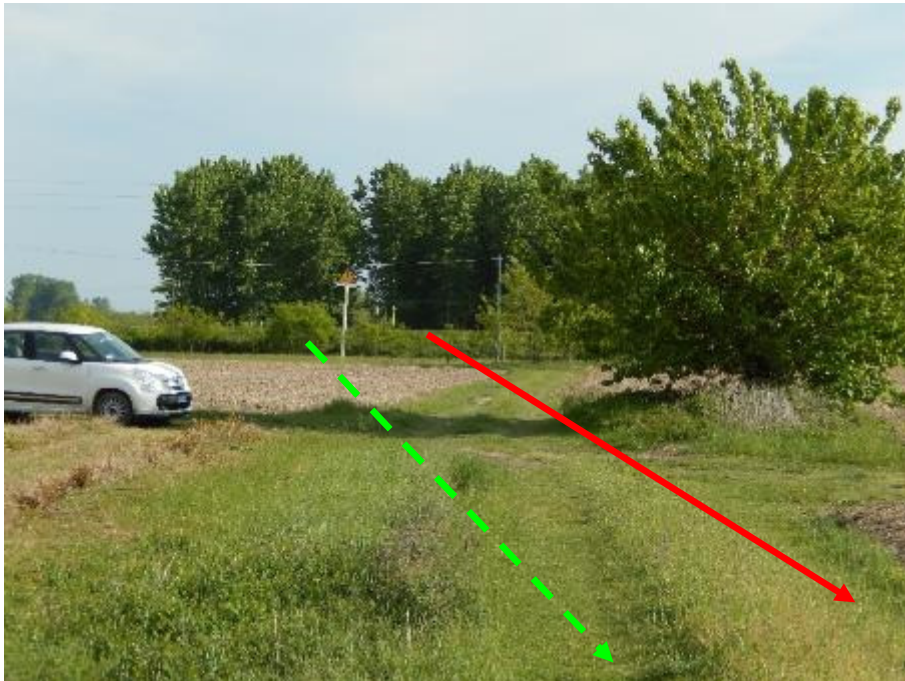
FOTO N.121 - PANORAMICA CONTRO SENSO GAS METANODOTTI IN PARALLELISMO
