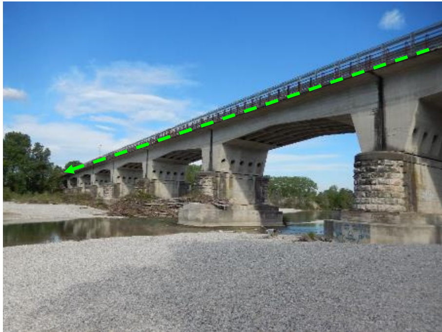
FOTO N.125 - ATTRAVERSAMENTO FIUME TAGLIAMENTO
