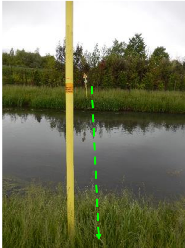
FOTO N.5 - CONDOTTA DA DISMETTERE SU FIUME MUSESTRE
