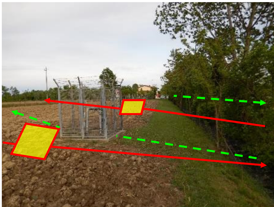
FOTO N.54 - IMPIANTO N.4102027 DA DISMETTERE
