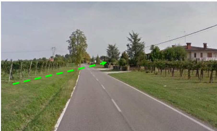
FOTO N.80 - ATTRAVERSAMENTO S.P. N.60
