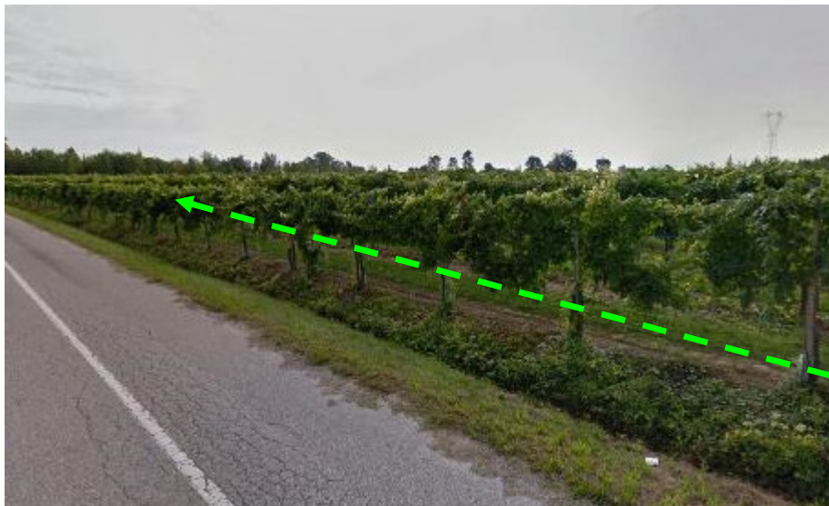
FOTO N.84 - PERCORRENZA MET. DA DISMETTERE IN UN VIGNETO
