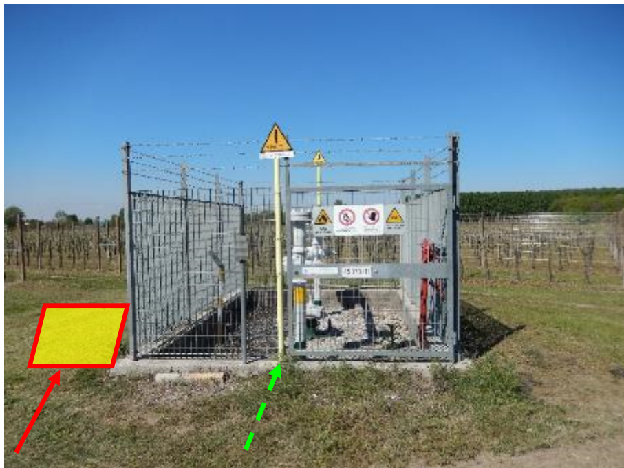
FOTO N.146 - IMPIANTO PIL N.13 IN PROGETTO
