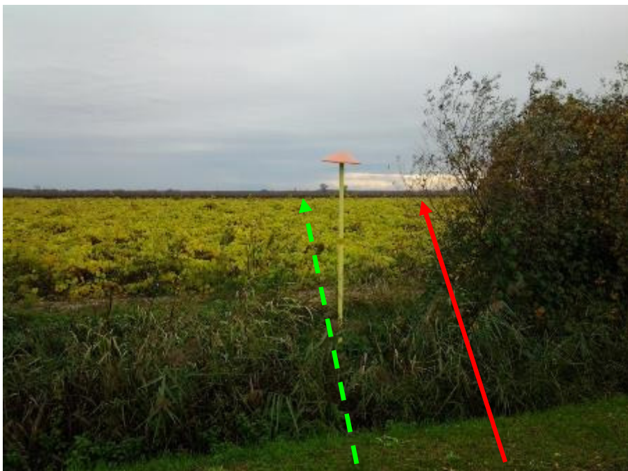
FOTO N.110 - PERCORRENZA SENSO GAS IN PARALLELO AL MET. IN PROGETTO
