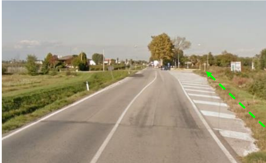
FOTO N.57 - MET. DA DISMETTERE LUNGO VIA PALÙ
