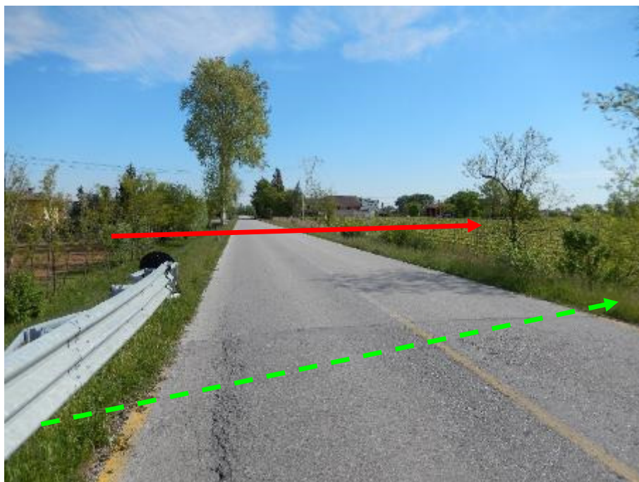
FOTO N.72 - ATTRAVERSAMENTO S.P. N.61
