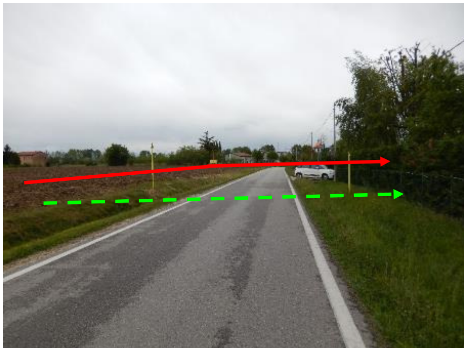
FOTO N.4 - ATTRAVERSAMENTO S.P. N.89
