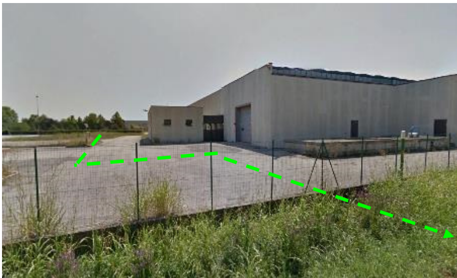
FOTO N.2 -PERCORRENZA IN AREA INDUSTRIALE VISTA CONTRO SENSO GAS
