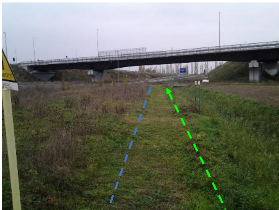
FOTO N.18 - PANORAMICA SENSO GAS SOTTO CAVALCAVIA
