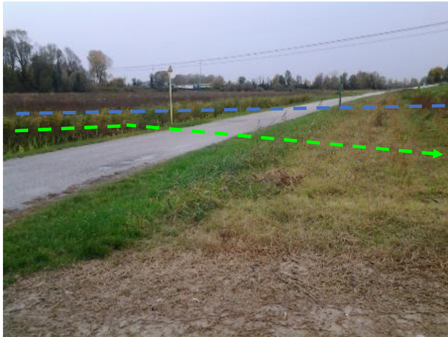
FOTO N.11 - ATTRAVERSAMENTO VIA DE AMICIS
