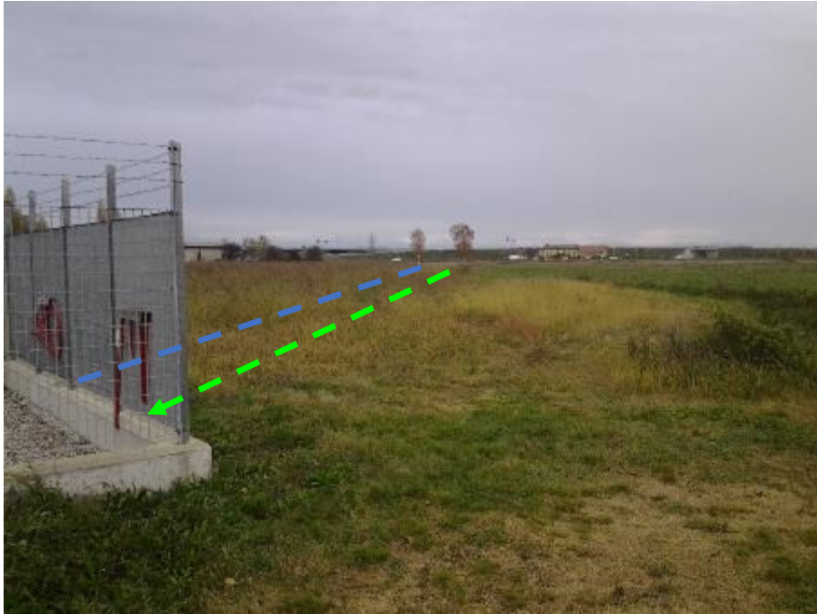
FOTO N.21 - IMPIANTO DA DISMETTERE E NUOVO IMPIANTO PIDA IN PROGETTO
