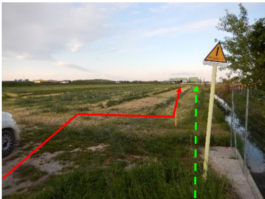
FOTO N.24 -PANORAMICA SENSO GAS
