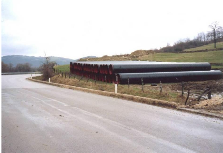
Fig. 8.1.1/A – Foto tipica di una piazzola per accatastamento tubazioni
