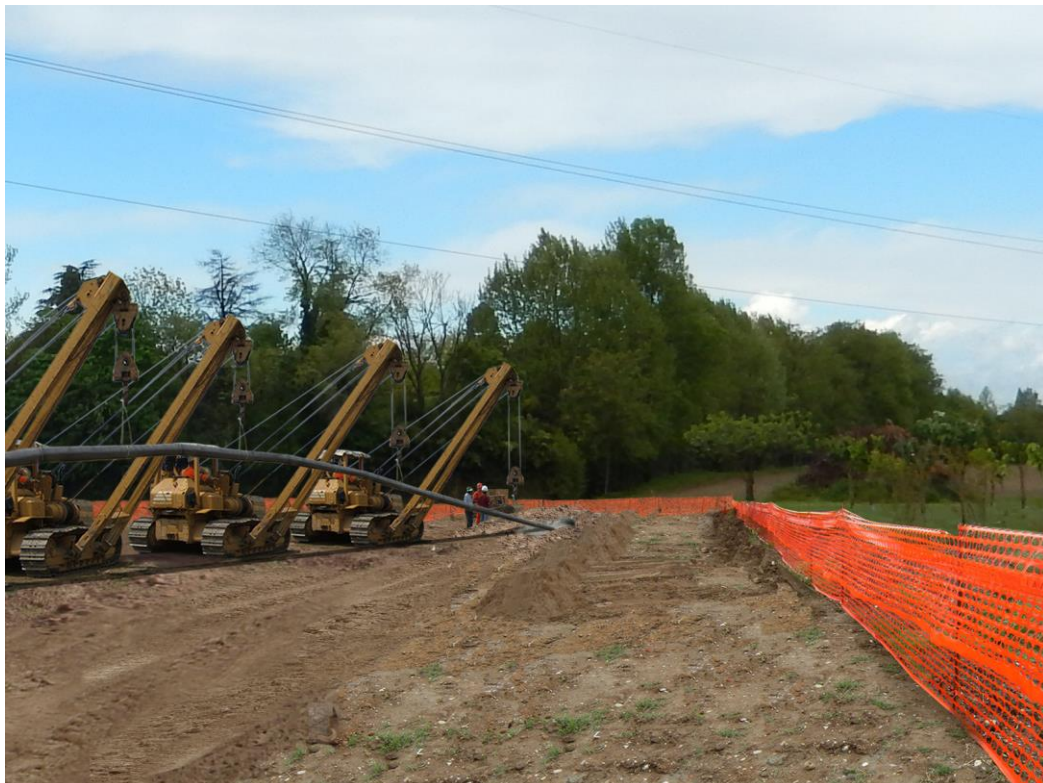
Fig. 3/E: Cantiere T.O.C. in areale a seminativo. Cantiere in corso
