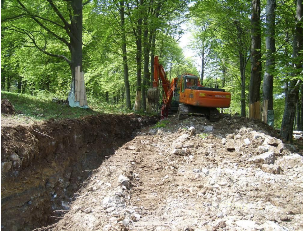
Fig. 8.1.6/A – Foto tipica di scavo della trincea
