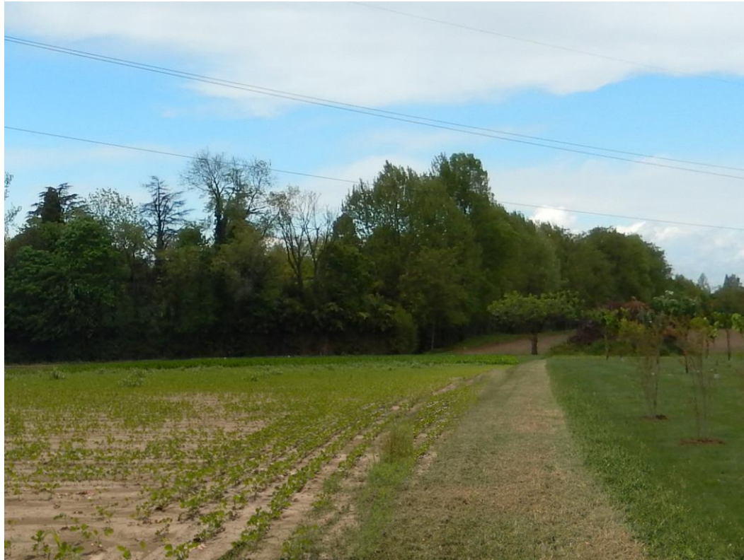
Fig. 3/F: Cantiere T.O.C. in areale a seminativo. Ripristino effettuato
