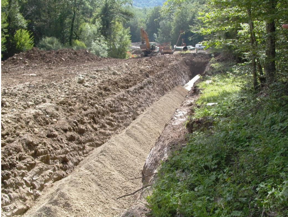
Fig. 8.1.8/B –Rinterro della condotta
