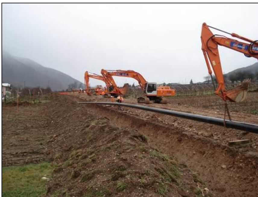
Fig. 8.1.8/A – Posa della condotta
