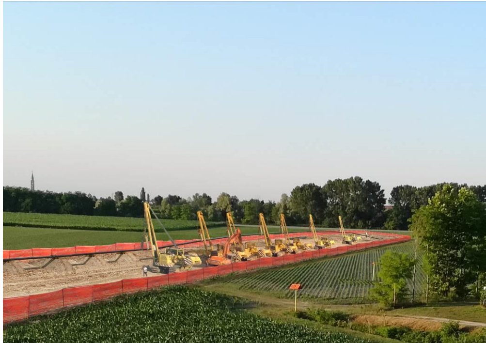
Fig. 3/B: Attraversamento fiume Piave, area di ingresso T.O.C.. Cantiere in corso
