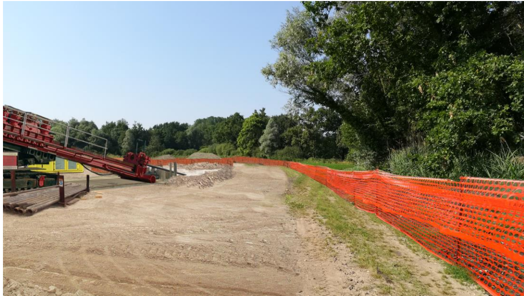
Fig. 3/B: Area cantiere T.O.C. – Paludi di Gonars. Cantiere in corso
