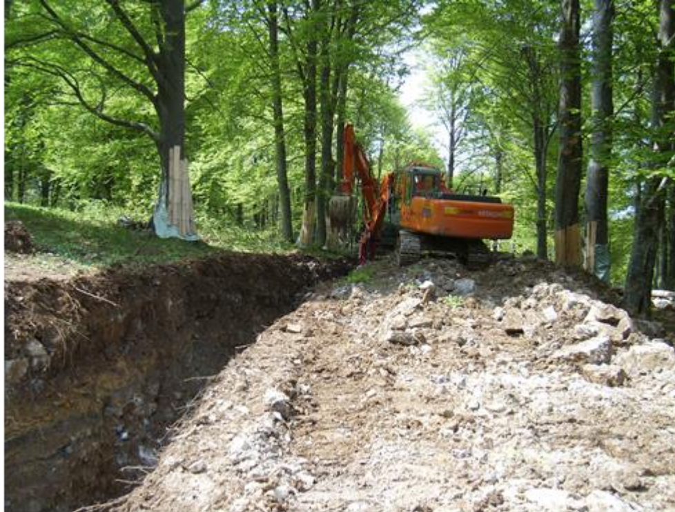
Fig. 8.1.6/A – Foto tipica di scavo della trincea
