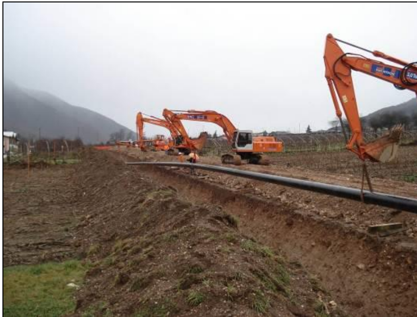
Fig. 8.1.8/A – Posa della condotta
