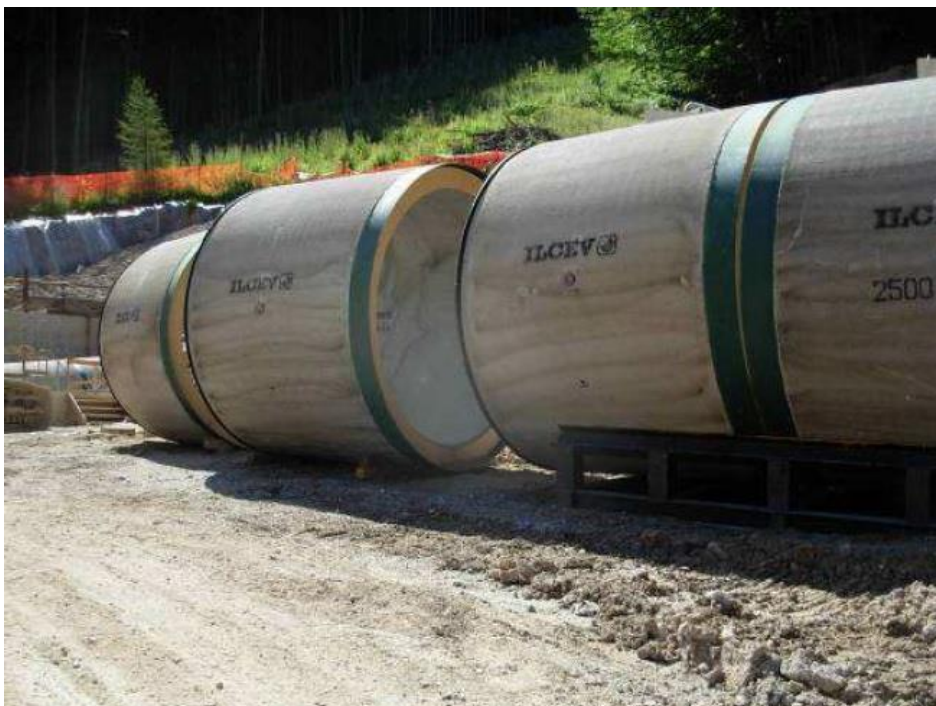
Fig. 8.1.10/H – Stoccaggio tubi in c.a.
