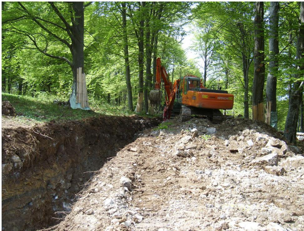
**Fig. 2.2.5/F – Foto tipica di scavo della trincea**
