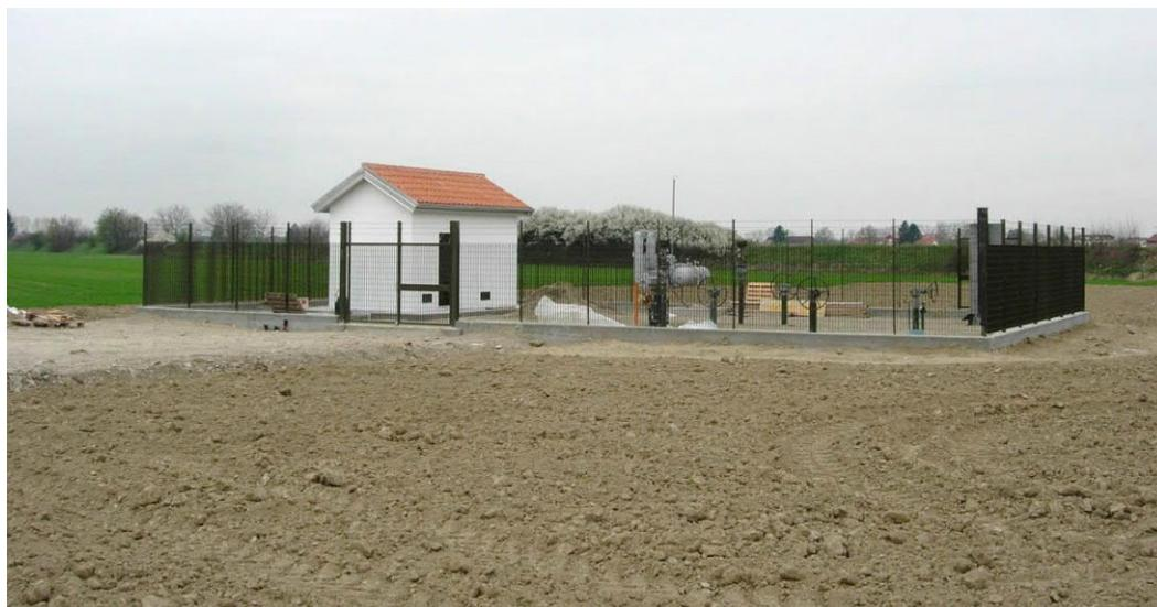
**Fig. 2.2.5/U – Esempio di Punto di Intercettazione di Linea (PIL) con telecontrollo**
