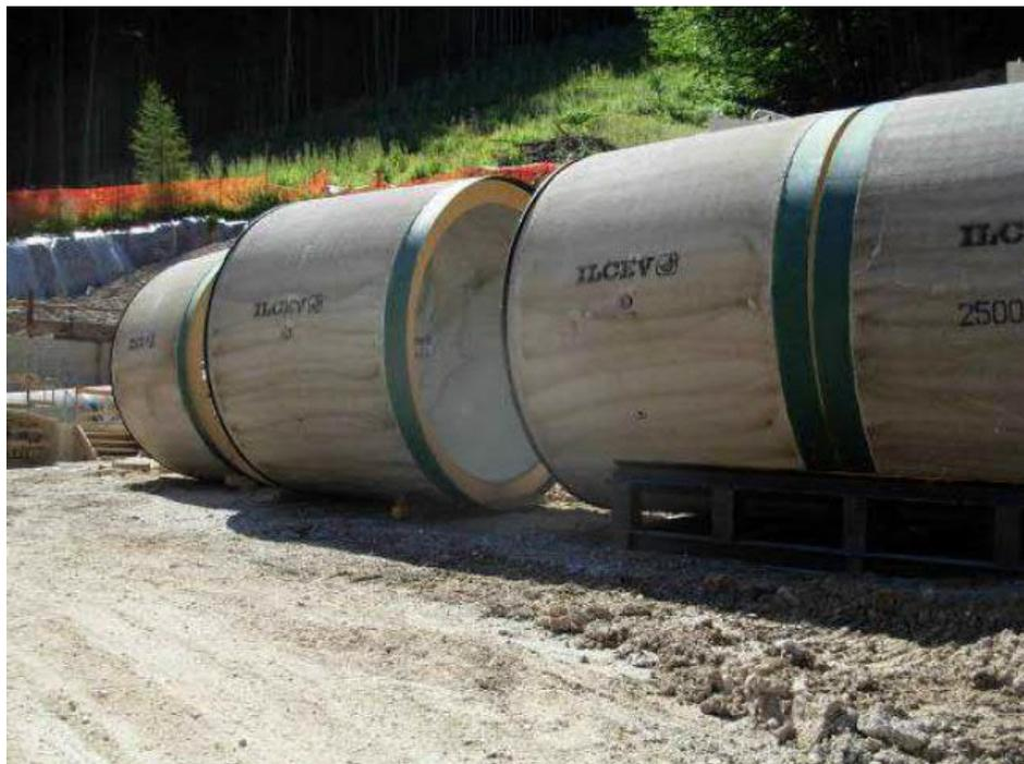
Fig. 2.2.5/T – Stoccaggio tubi in c.a.
