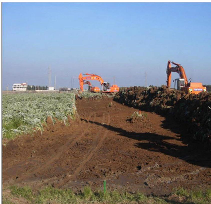
**Fig. 2.2.5/B – Foto di apertura della pista di lavoro**
