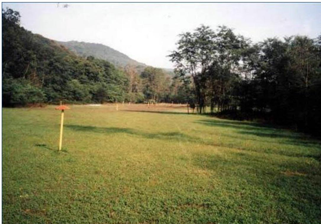
Fig. 2.2.5/V – Pista lavori a ripristini ultimati su un gasdotto in esercizio
