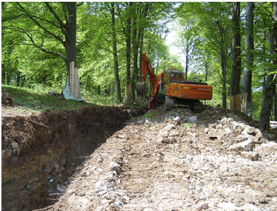
**Fig. 3.1.6/A** – Foto tipica di scavo della trincea
