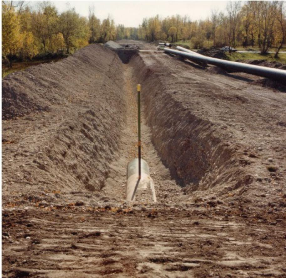
**Fig. 3.1.10/A** – Attraversamento con tubo di protezione, particolare dello sfiato
