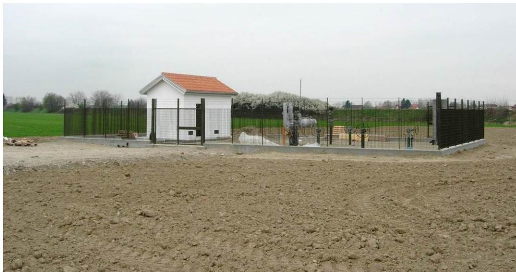
**Fig. 3.1.11/A** – Esempio di Punto di Intercettazione di Linea (PIL)
