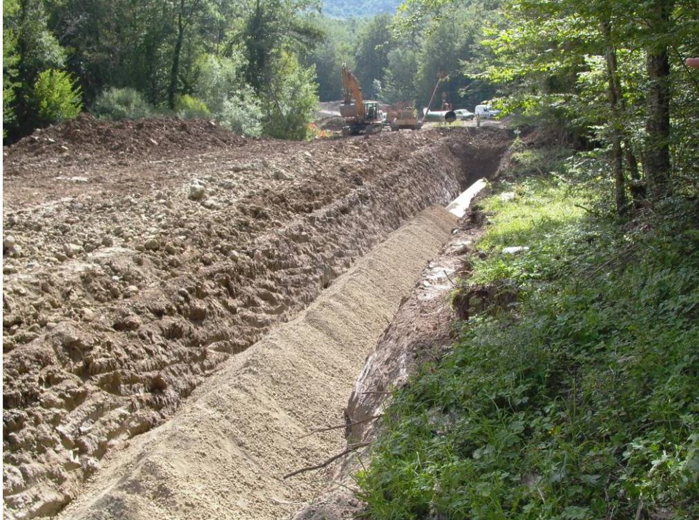
**Fig. 3.1.8/B** –Rinterro della condotta
