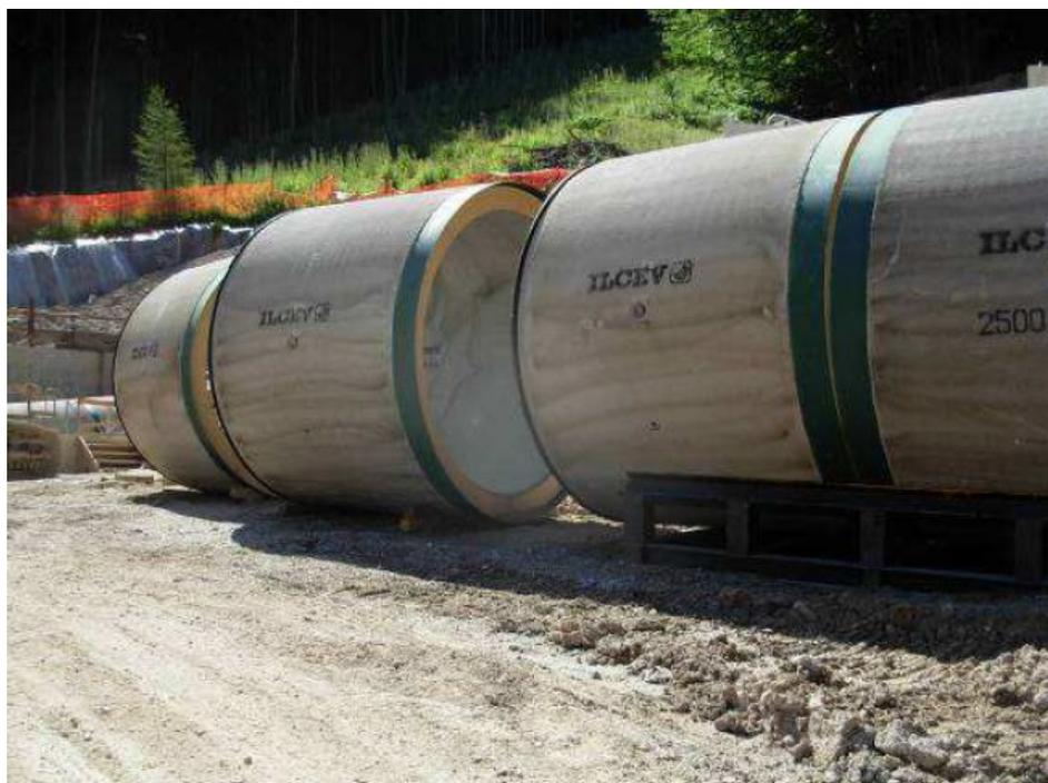
**Fig. 3.1.10/H** – Stoccaggio tubi in c.a.
