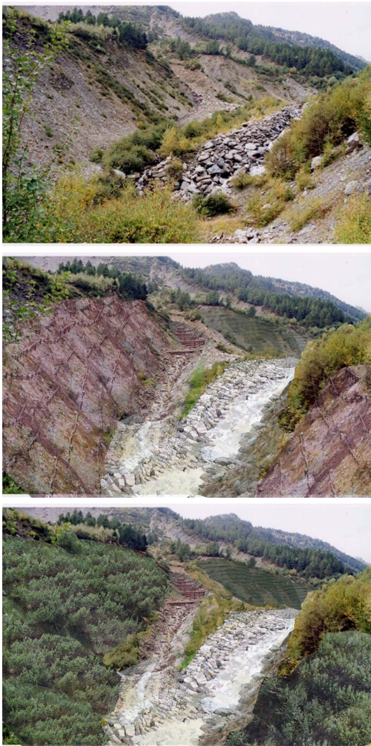
Figura E-6 - Zona frana A. Confronto tra la situazione attuale e quella di progetto (a completamento dei lavori e dopo qualche anno)
