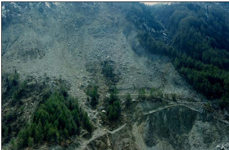
Figura D-6 - Pista di cantiere su frana A, oggi non conservata
