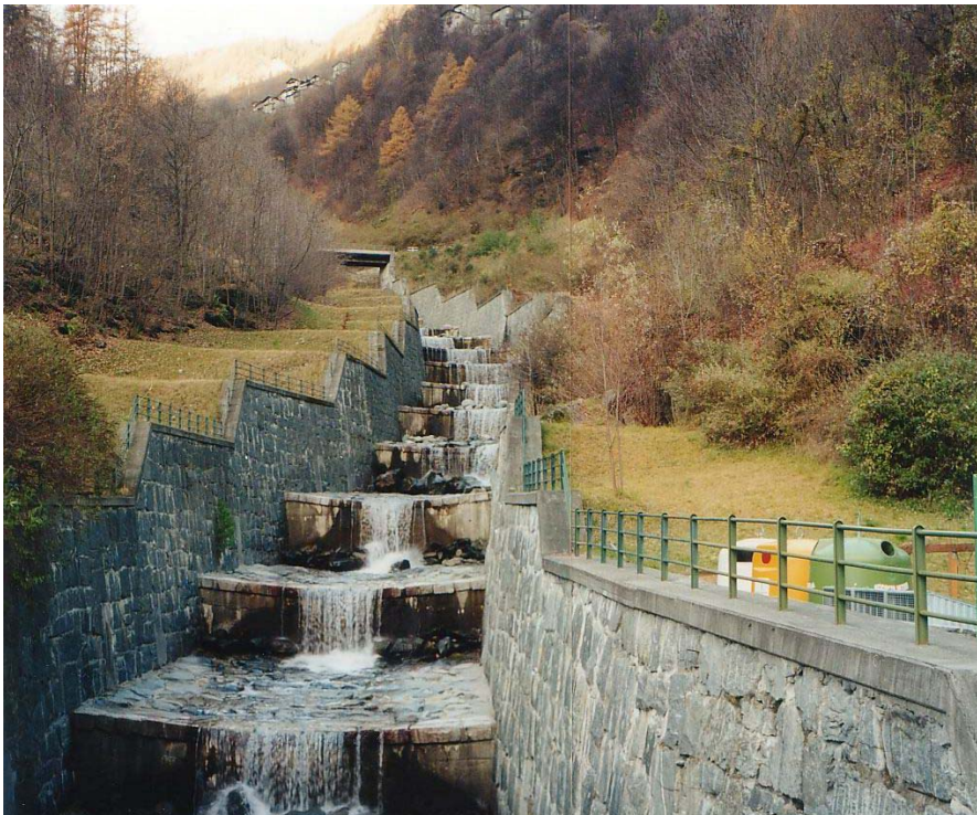
Figura E-2 – Veduta panoramica dell'asta del Torreggio (tra quota 775 m s.m. e quota 845 m s.m.) già sottoposta ad opere di regimazione idraulica e suscettibile di interventi di sistemazione paesistica. Particolare dei terrazzamenti realizzati in fregio all'asta del torrente.
