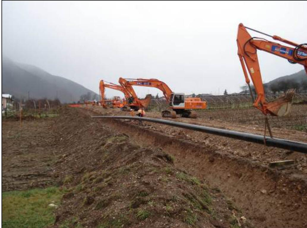
Nel caso in cui il fondo dello scavo presenti asperità tali da poter compromettere l'integrità del rivestimento, sarà realizzato un letto di posa con materiale inerte (sabbia, ecc.).
