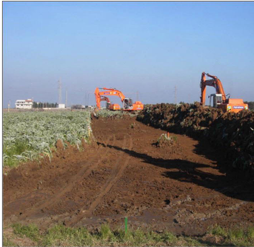
Fig. 5.B – Foto di apertura della pista di lavoro
