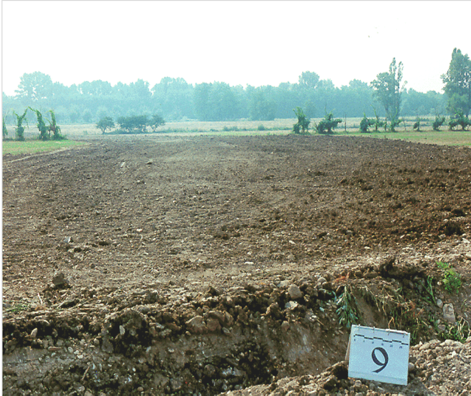
Fig. 5.H – Foto del ripristino del terreno superficiale e suo livellamento
