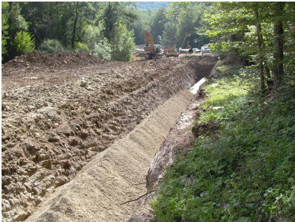
Fig. 5.G – Foto di rinterro della condotta
