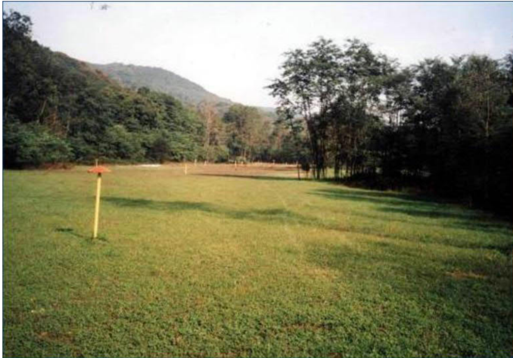
Fig. 5.J – Fascia di lavoro ad opera ultimata su un gasdotto in esercizio
