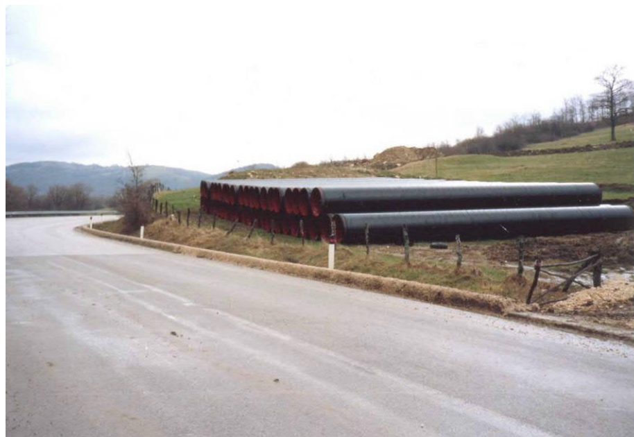
Fig. 5.A – Foto tipica di una piazzola per accatastamento tubazioni
