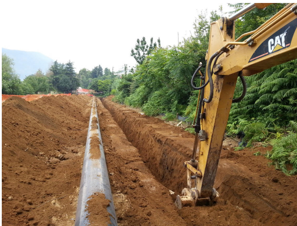
Fig. 5.E – Foto di scavo della trincea
