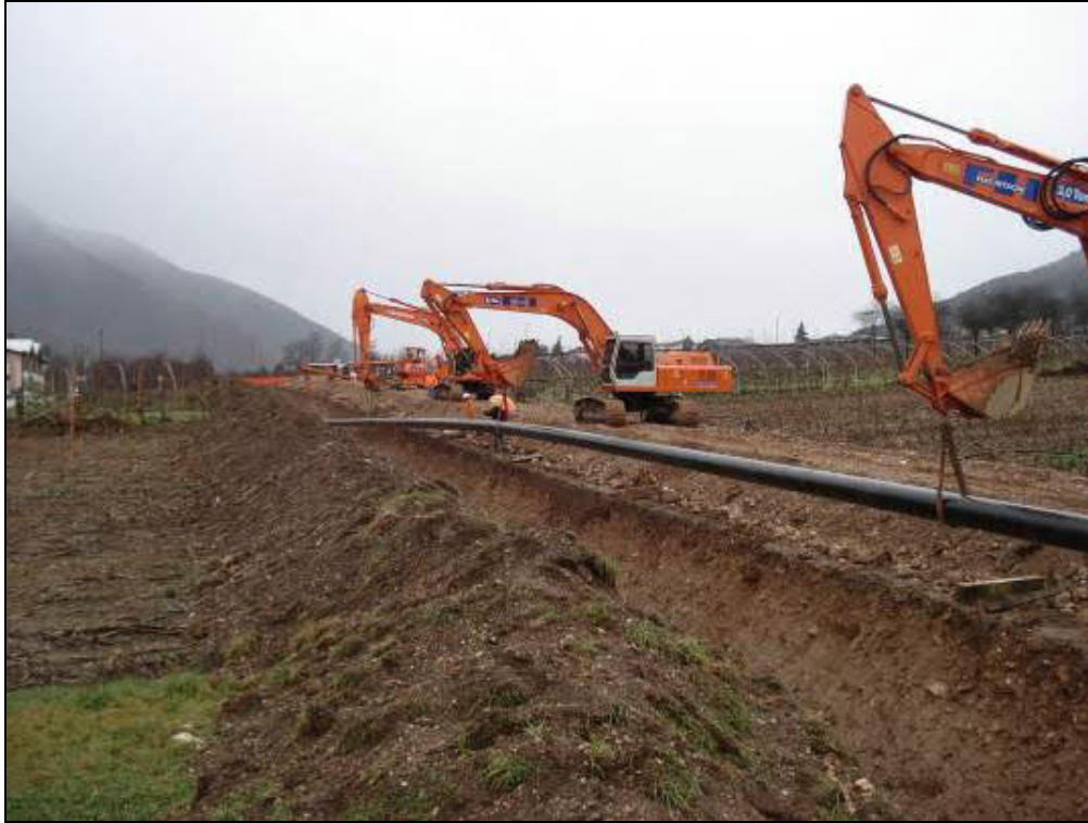
Fig. 5.F – Foto di posa della condotta
