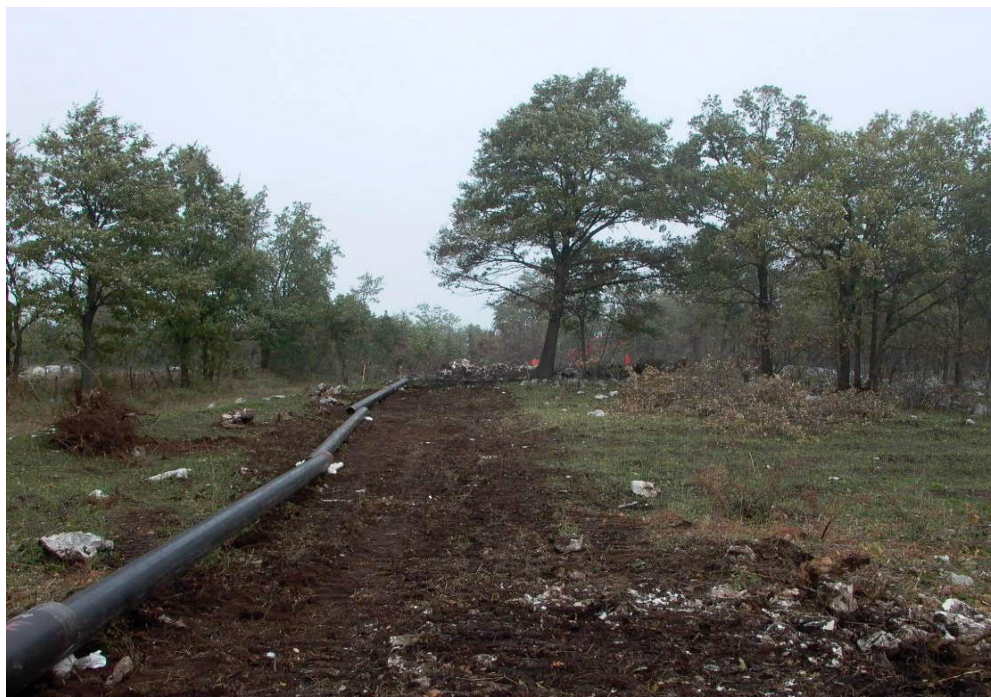
Fig. 5.C – Foto di sfilamento delle tubazioni lungo la pista dei lavori
