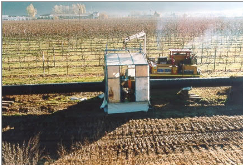
Fig. 5.D – Foto di saldatura delle tubazioni
