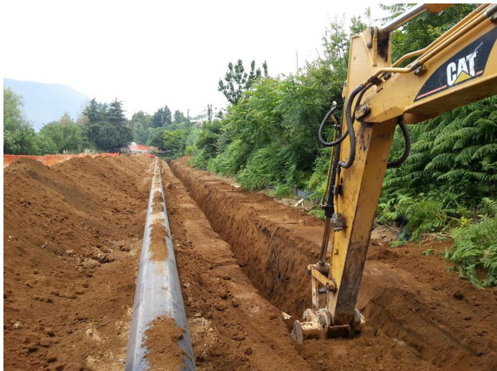
**Fig. 5.E – Foto di scavo della trincea**
