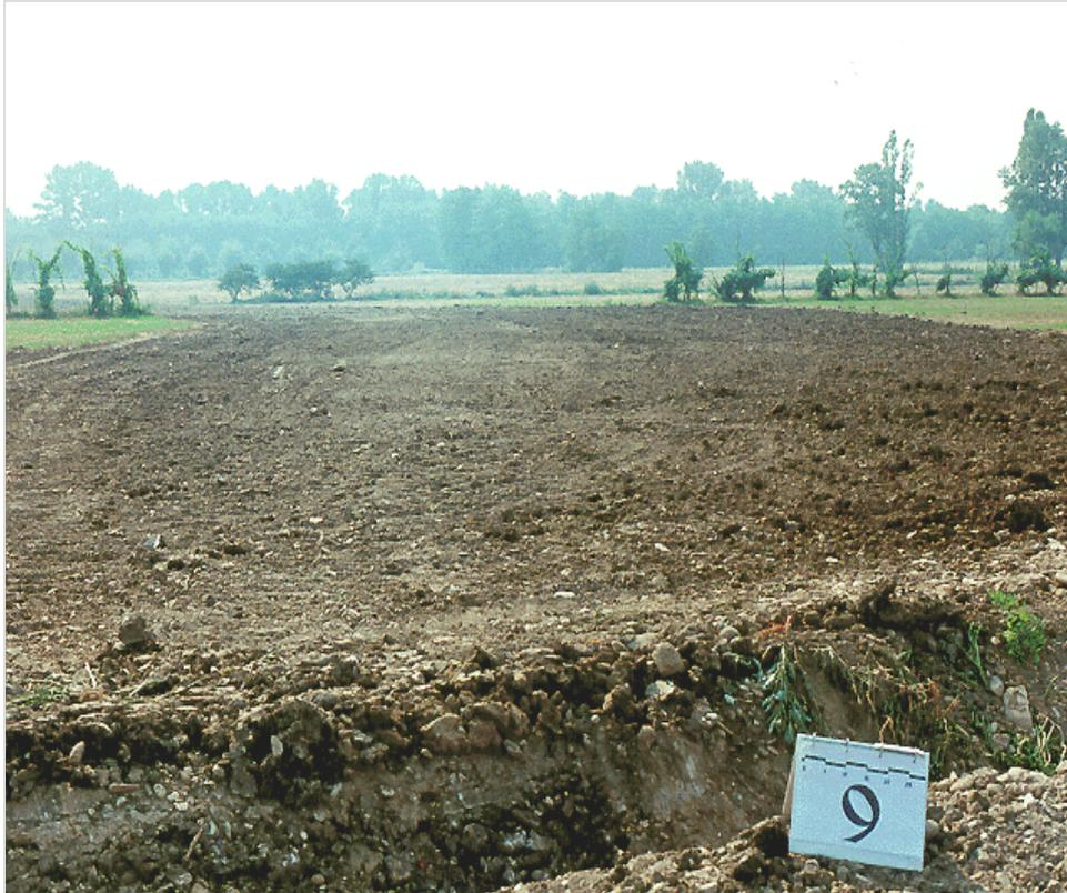
Fig. 5.H – Foto del ripristino del terreno superficiale e suo livellamento
