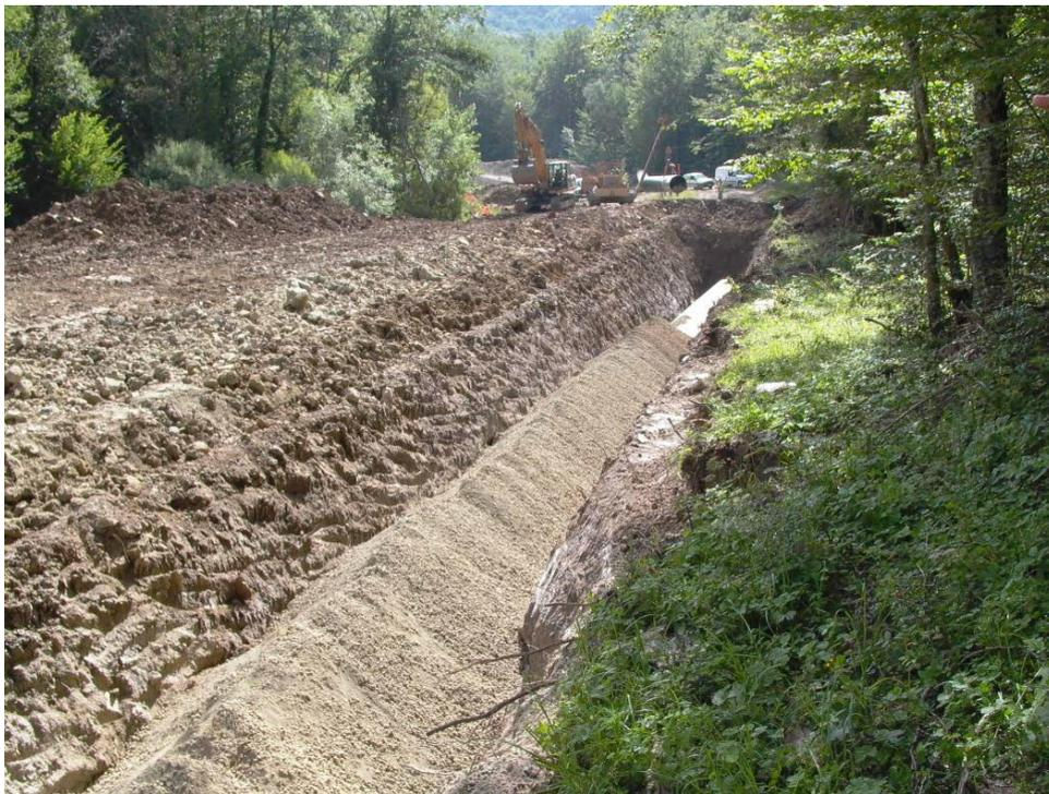
**Fig. 5.G – Foto di rinterro della condotta**
