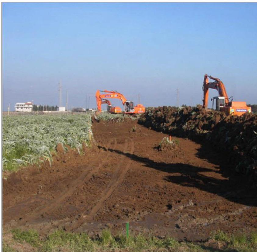
**Fig. 5.B – Foto di apertura della pista di lavoro**
