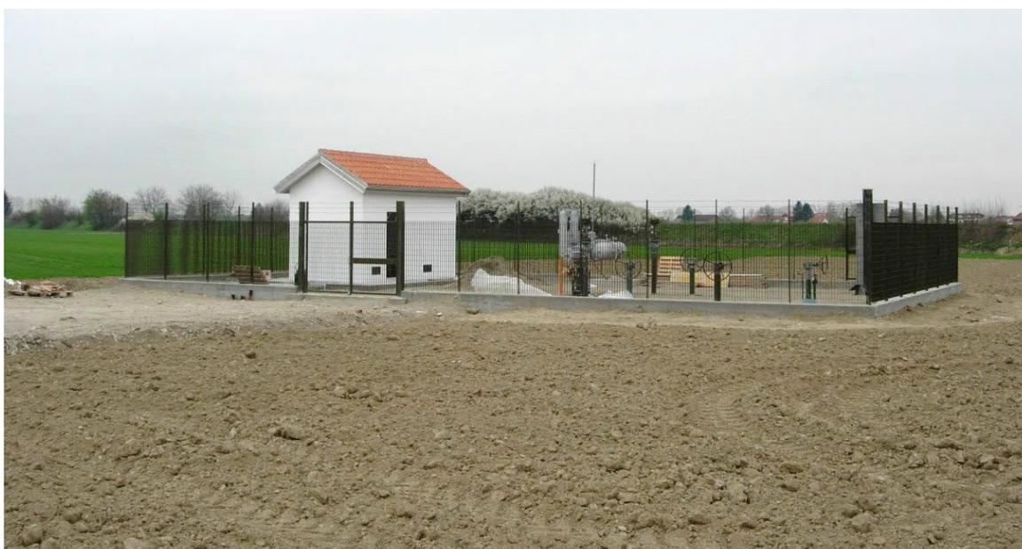
**Fig. 5.K: Esempio di punto di linea (unico elemento fuori terra a lavori ultimati, oltre ai cartelli segnalatori)**
