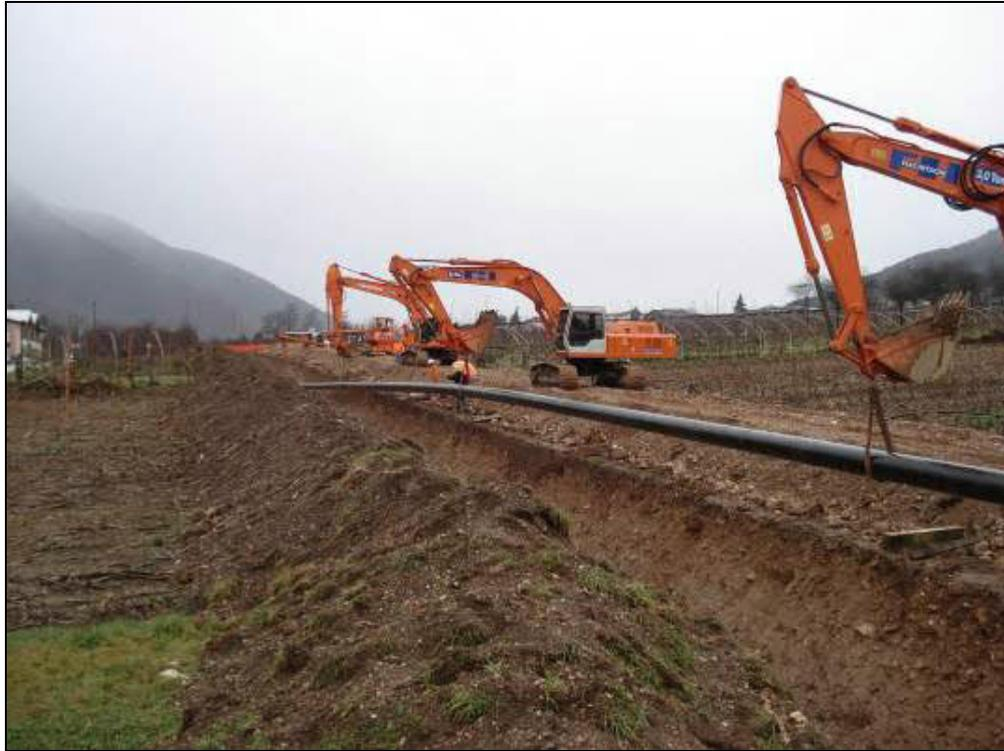
**Fig. 5.F – Foto di posa della condotta**
