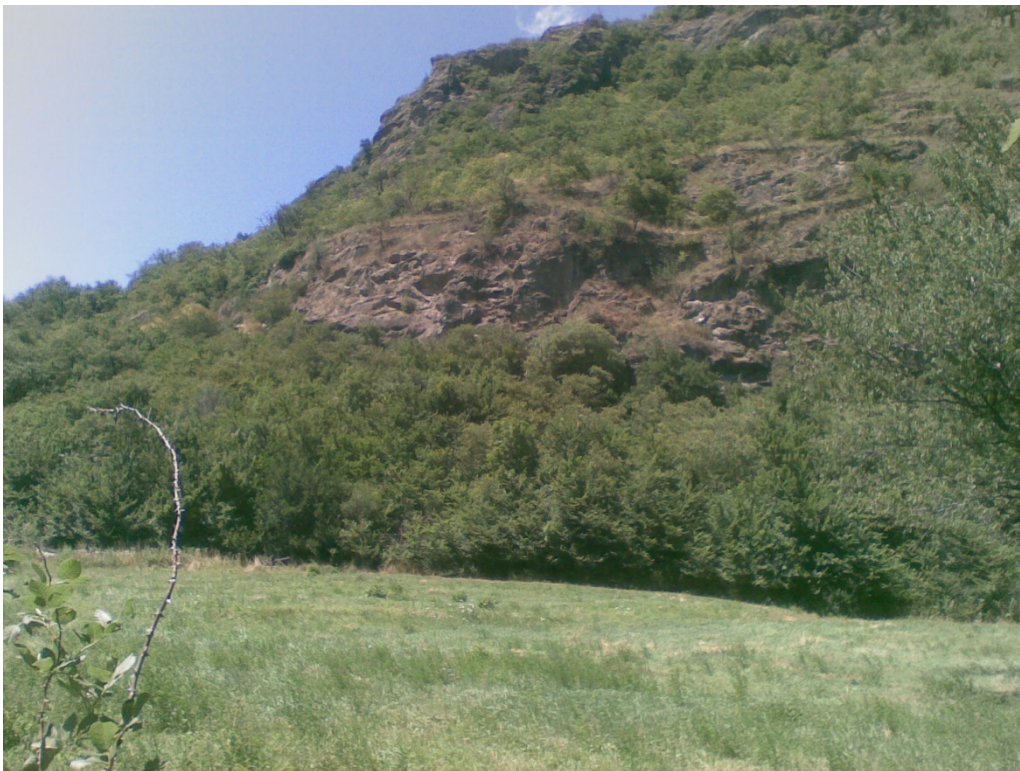
Figura 2 – Fotografia della parete dell'imbocco: al piede dell'affioramento roccioso si osserva il deposito costituito da detrito di falda, coperto da vegetazione arborea ad arbustiva in evoluzione, terrazzato artificialmente.
