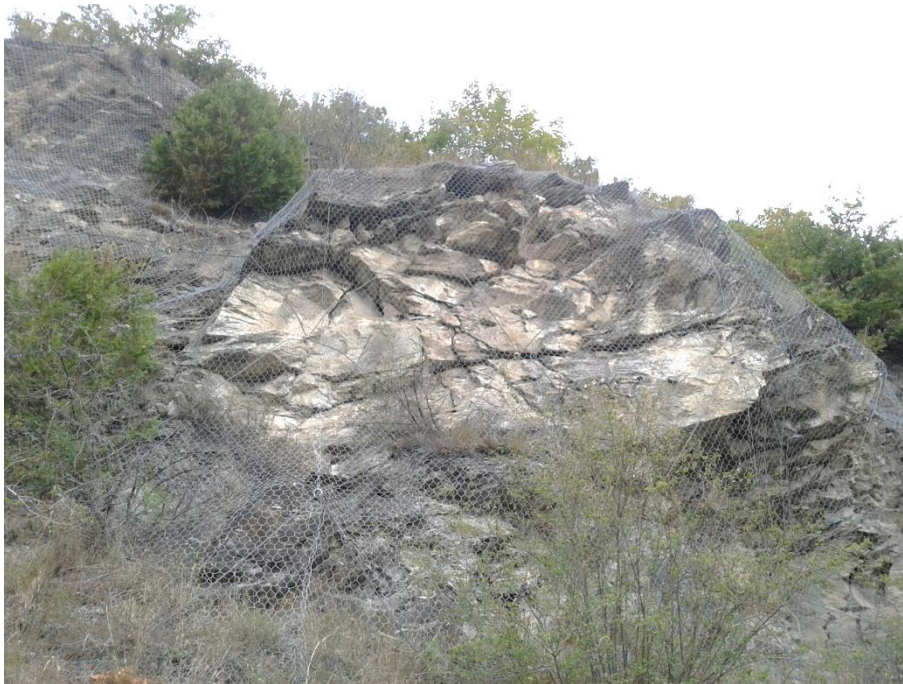
Figura 20 – Reti aderenti sulle pareti rocciose a monte della strada per Seghino (quota 640 m circa)
