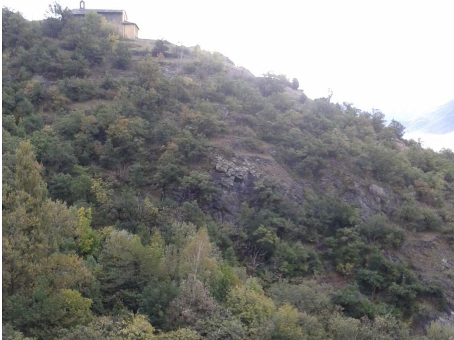
Figura 36 – Massi instabili nel versante esposto a nord ovest sotto al santuario della Madonna dell'Ecova.
