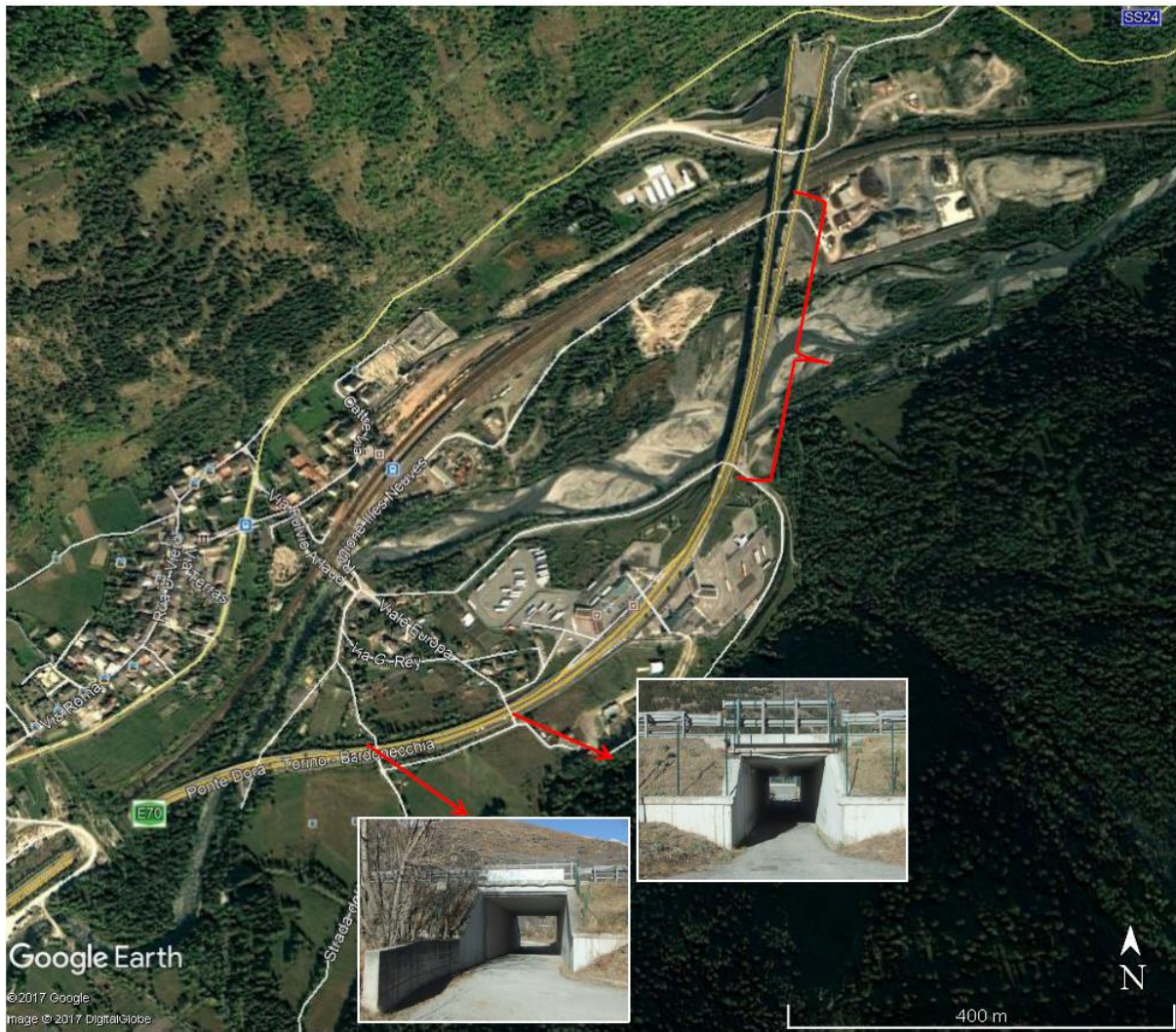
Figura 9 – Passaggi presenti a monte dell'area industriale di Salbertrand (1/2) – fotografie novembre 2017
