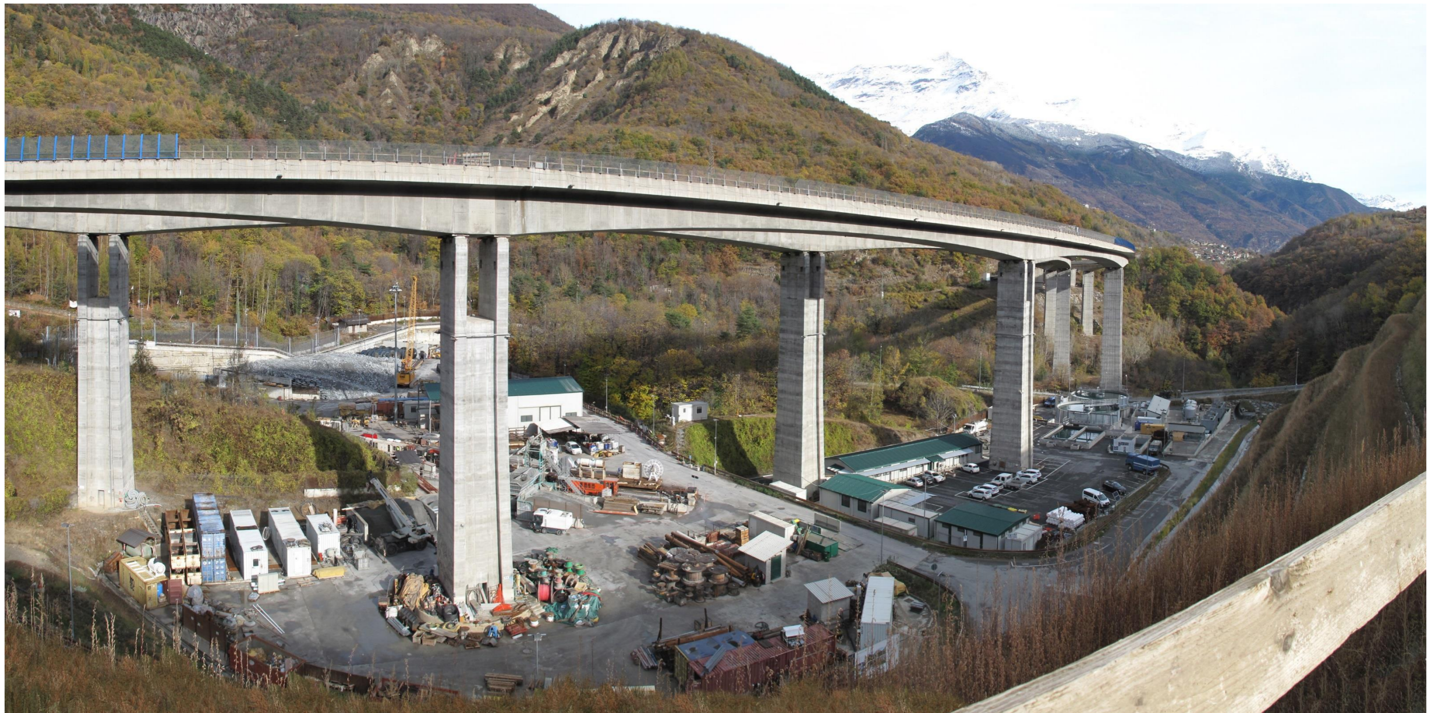
Figura 4 – La Maddalena – cantiere – Stato di fatto
