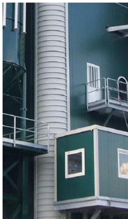
Impianto di betonaggio – Particolare della tipologia di schermatura controrumore e polveri
