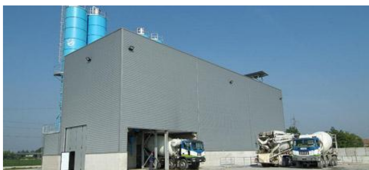
Impianto di betonaggio –
