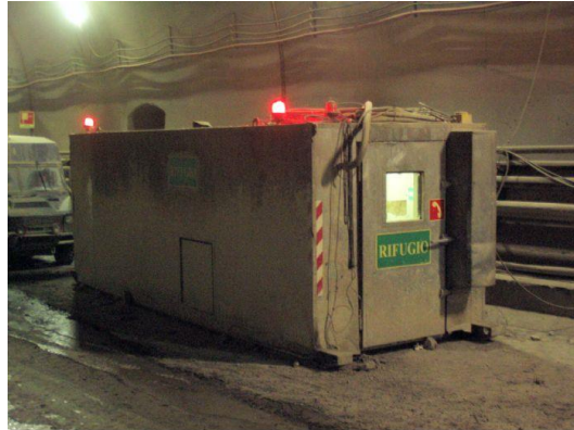
Container di salvataggio interno alla galleria (arca)
