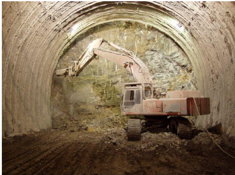
Scavo con martellone idraulico montato su escavatore cingolato
