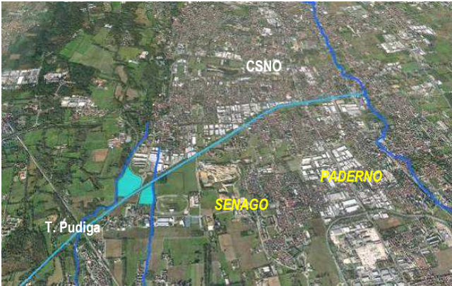
Foto aerea ambito vasca di laminazione del F. Seveso a Senago
