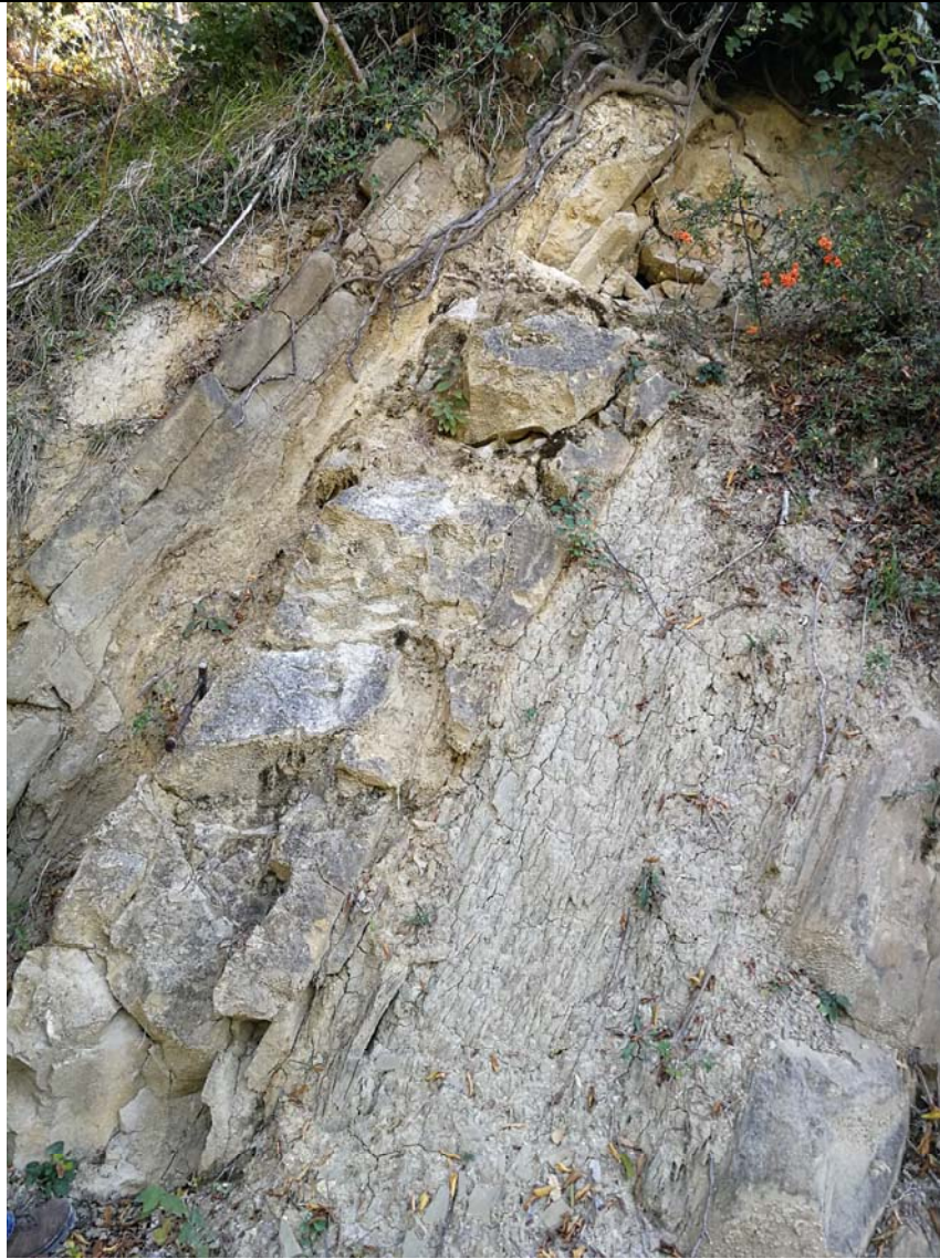
Figura 2 - Stazione ST3 particolare
