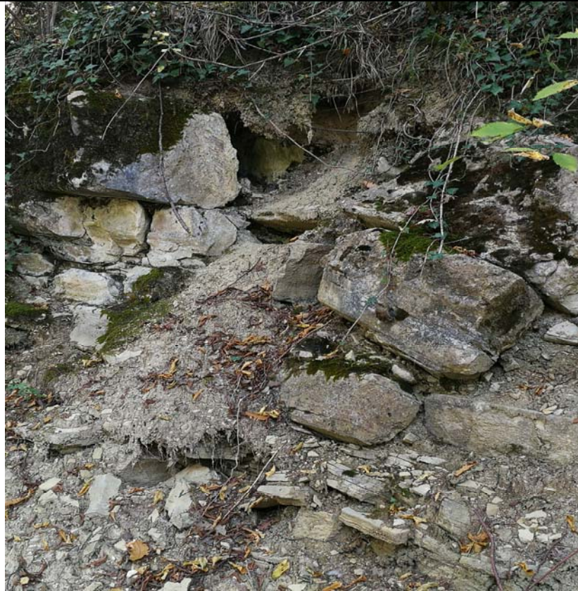
Figura 2 - Stazione ST2 particolare
