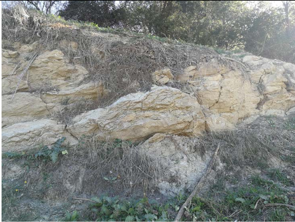
Figura 2 - Stazione ST1 particolare
