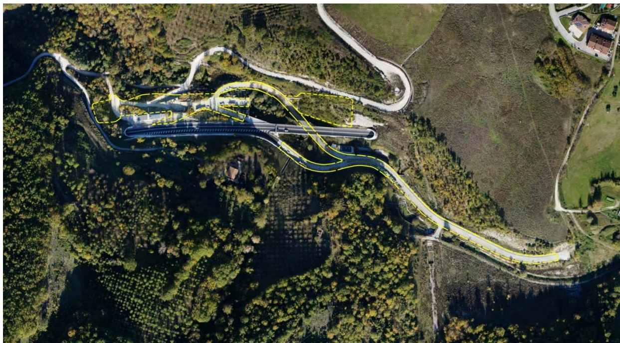
Foto 15- Area Cantiere Operativo n.3 "Calvario"
