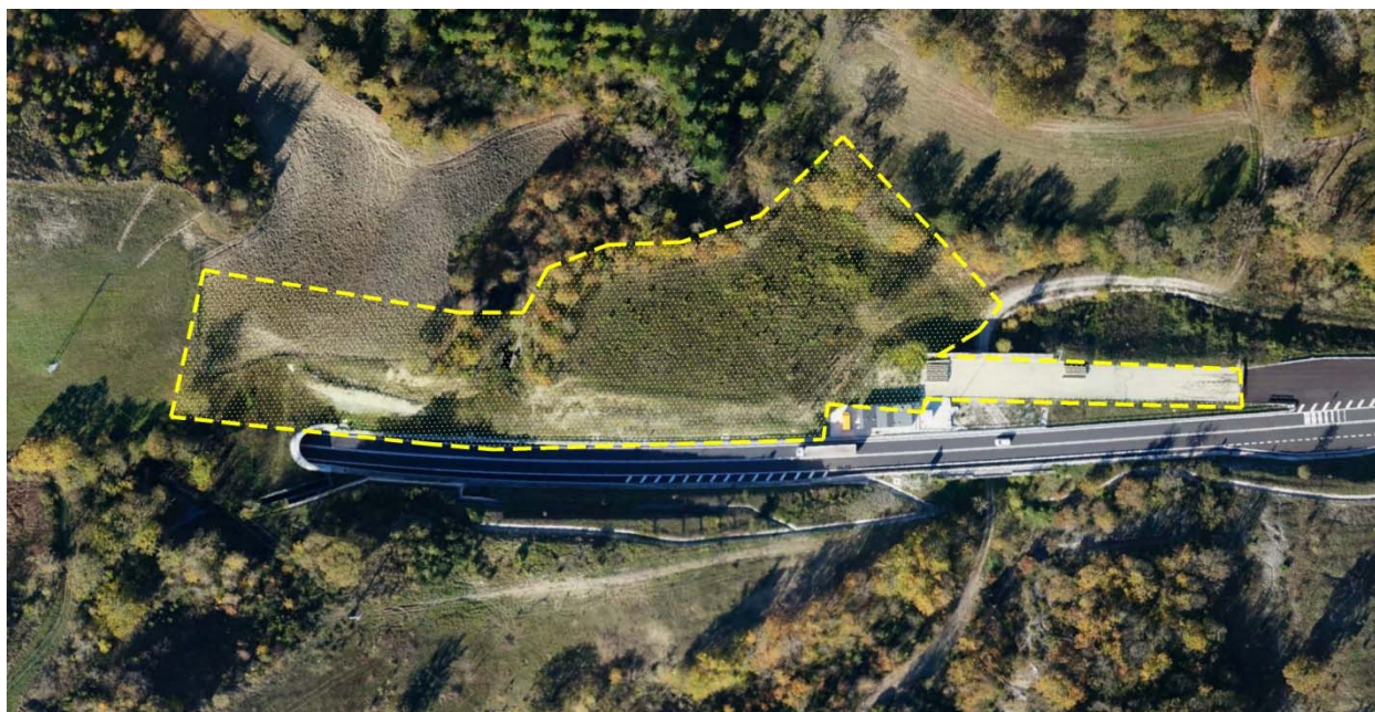
Foto 13 - Area Cantiere Operativo n.1 "Casacastalda"
