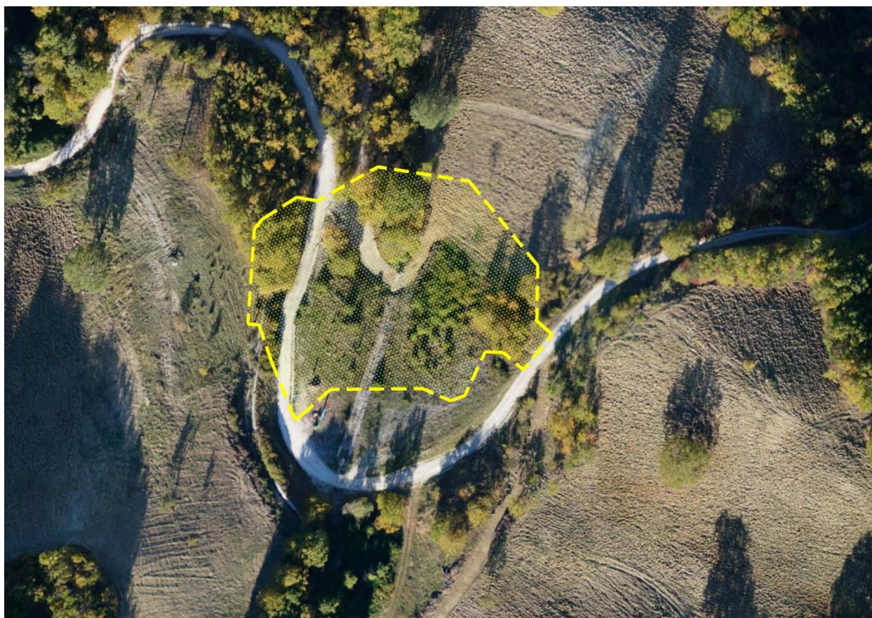
Foto 16 -Area Cantiere Operativo n.4 "Galleria artificiale Picchiarella"
