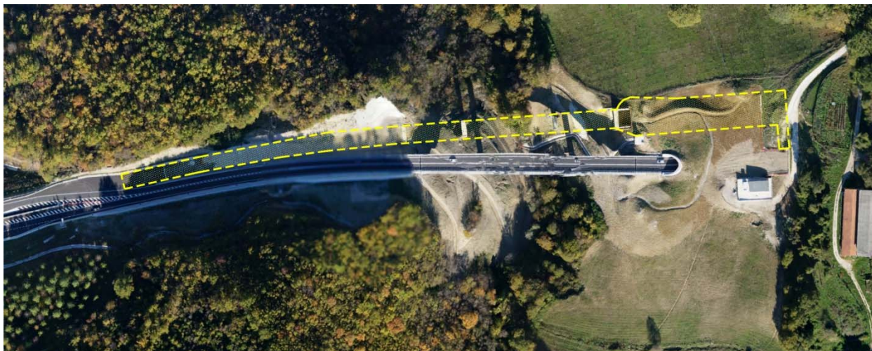
Foto 17 -Area Cantiere Operativo n.5 "Tre Vescovi"
