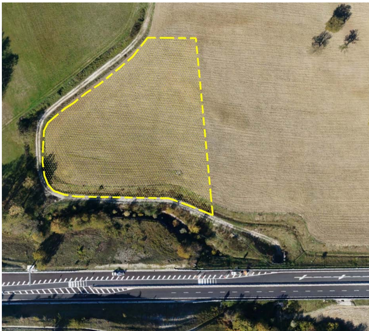
Foto 12 - Area Cantiere Base "Casacastalda"
