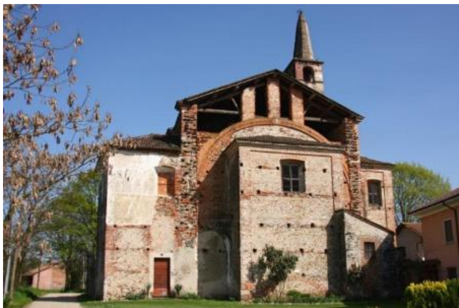
Figura 104: Vista della Pieve di San Genesio (source Alessandro Vecchi)
