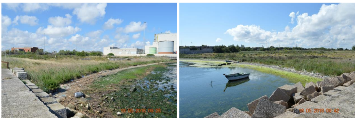
figura 6.15 - Foto relative al tratto di costa prospiciente l'opera da realizzare (estratto: Relazione geologica)
