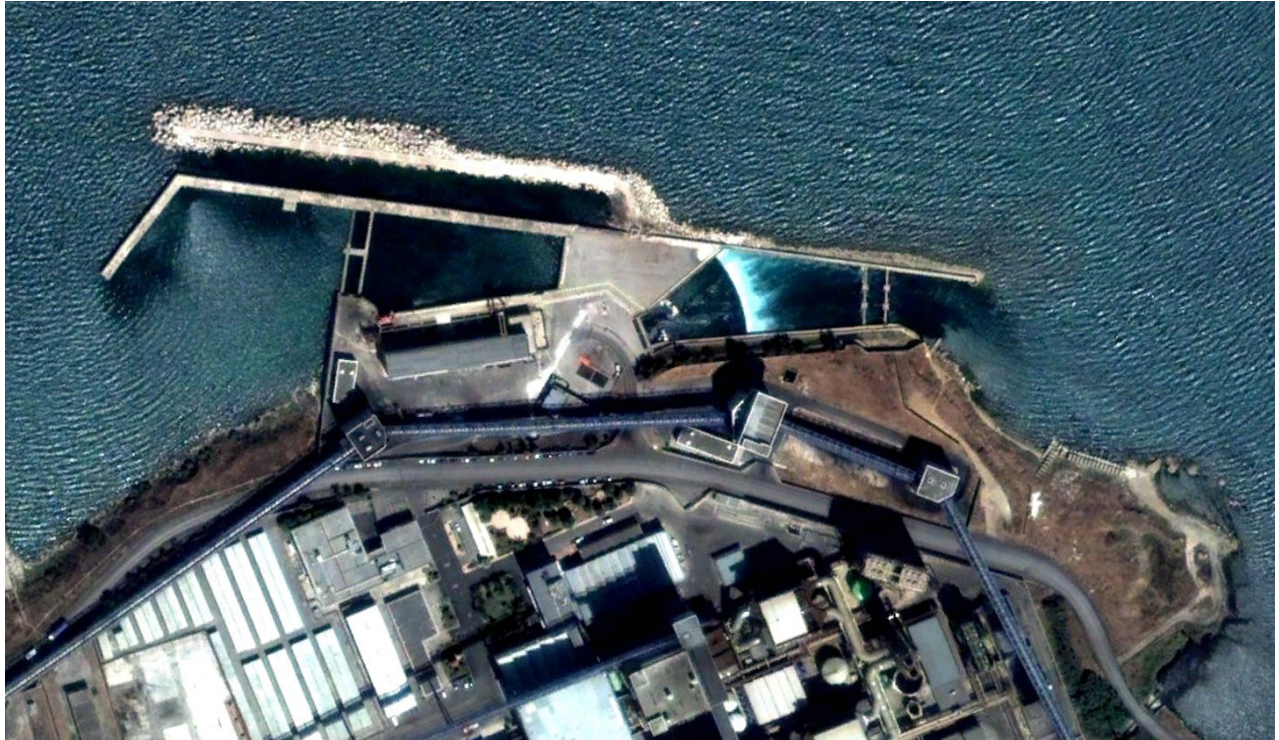
figura 2.5 - Vista aerea dell'opera di presa e scarico della centrale elettrica EdiPower.
