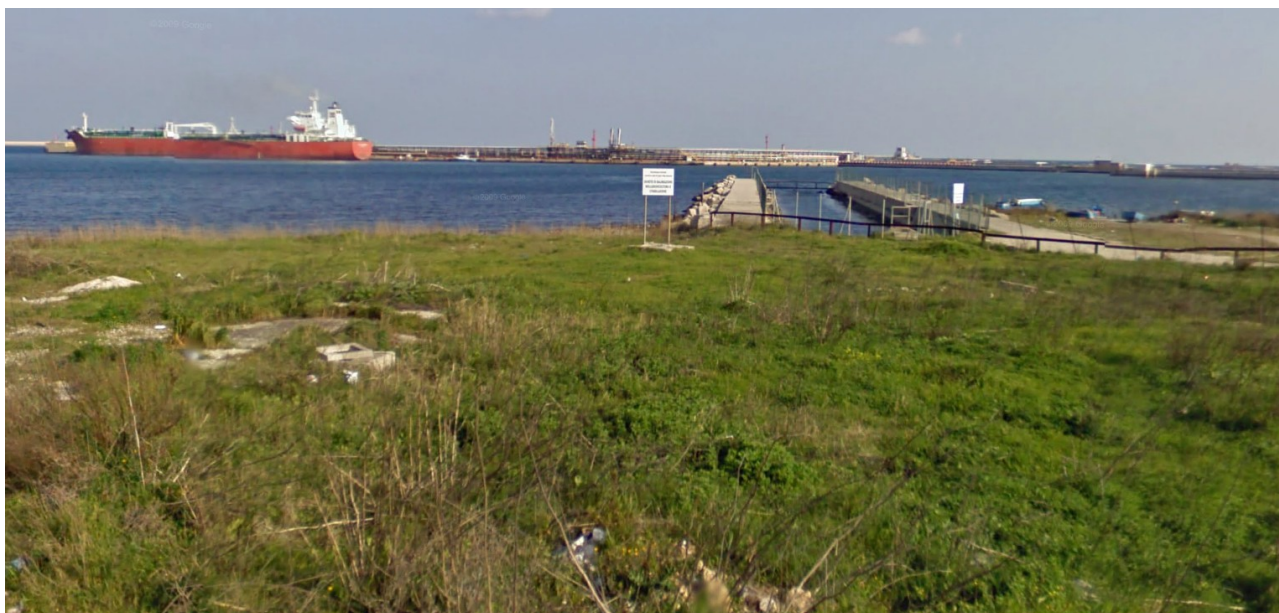
figura 2.6 - Vista dalla radice dello scarico delle acque di raffreddamento della centrale Polimeri Italia
