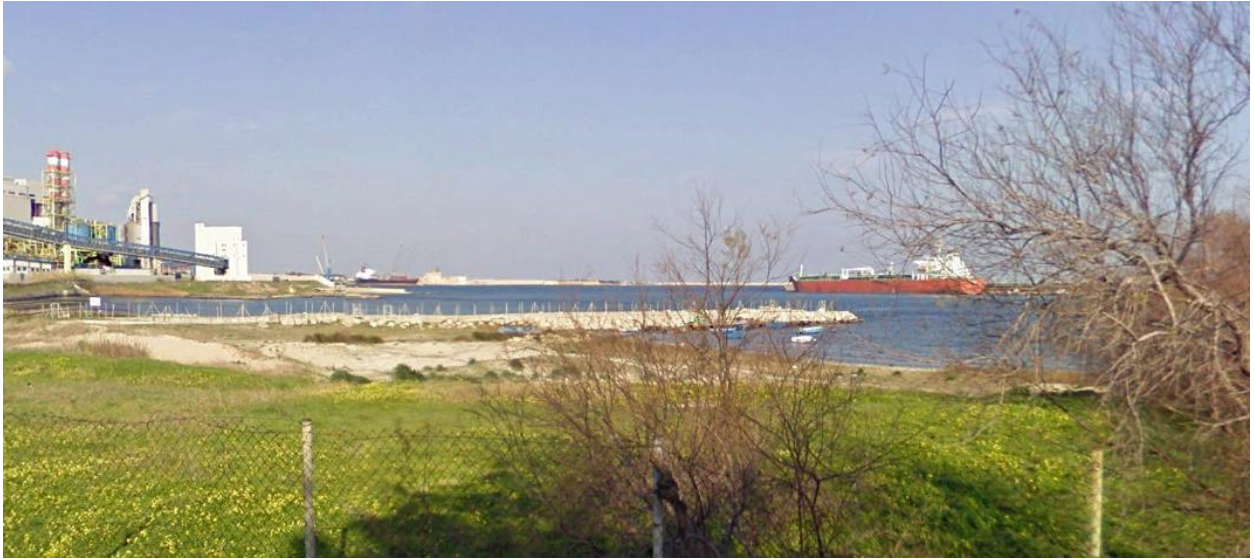
Figura 2-17. Vista dell'area d'intervento da via Albert Einstein
