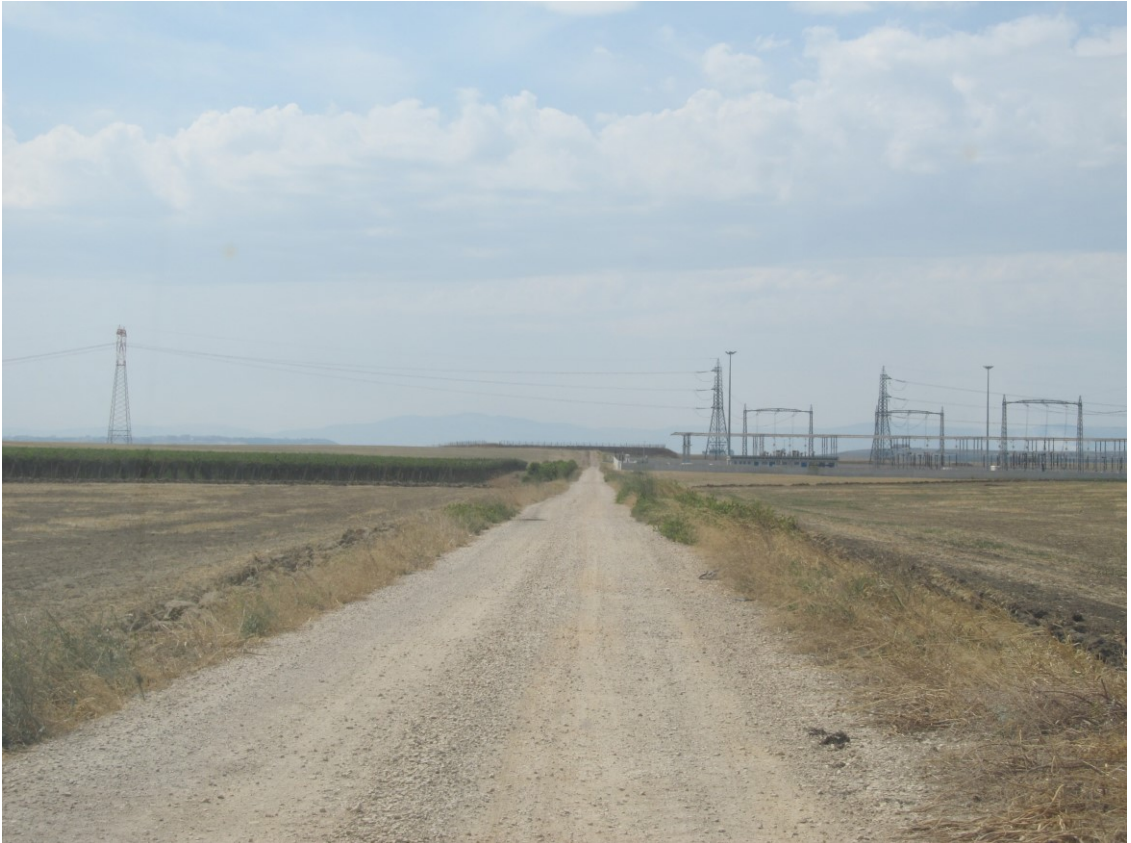
ID08 – STAZIONE ELETTRICA TERNA SAN SEVERO
