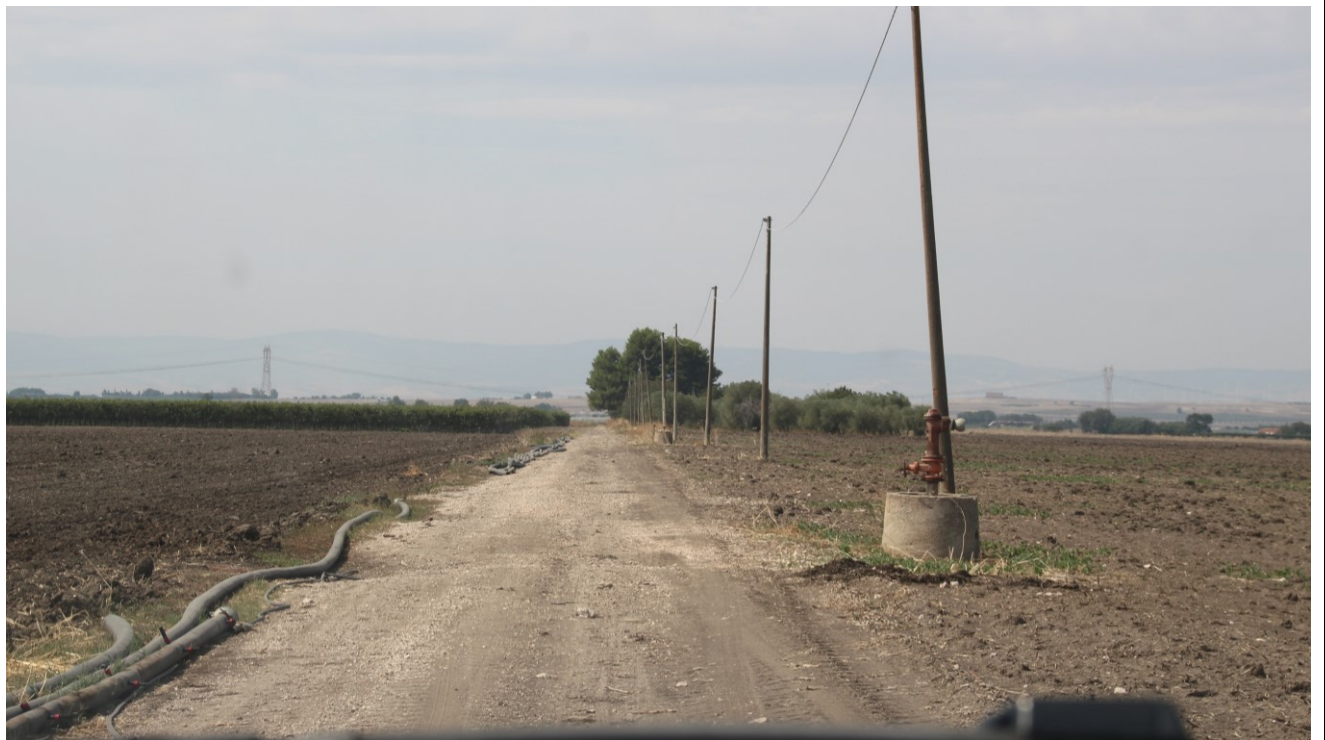
Id 02 - INTERPODERALE ESISTENTE DI ACCESSO ALL'IMPIANTO
