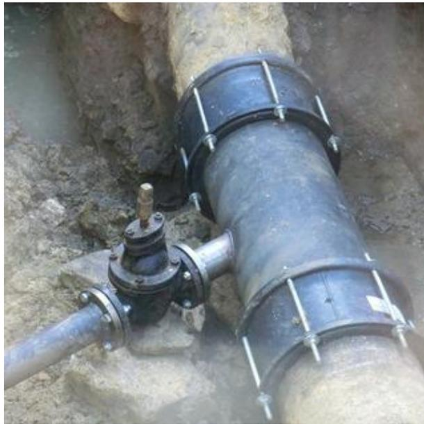
*Esempio di giunto su condotta in cemento-amiante*
