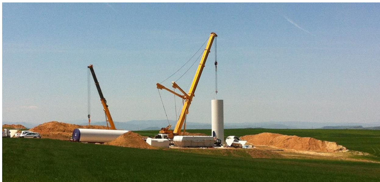
Foto 3.6 - Montaggio 1° segmento aerogeneratore
