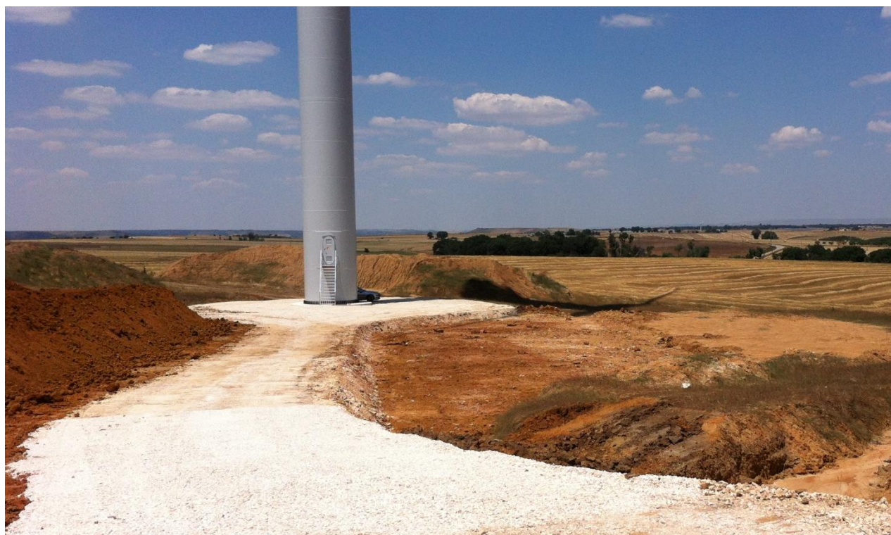
Foto 3.2 – Piazzola Definitiva con Accesso Stradale
