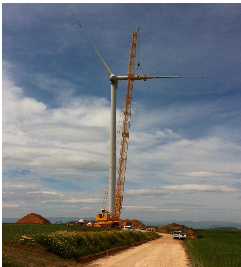
Foto 3.7 - Montaggio aerogeneratore
