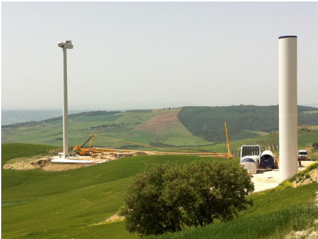
Foto 3.8 - Montaggio aerogeneratore
