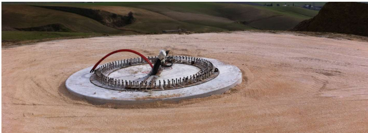
Foto 3.4 - Plinto interrato ed anchor cage
