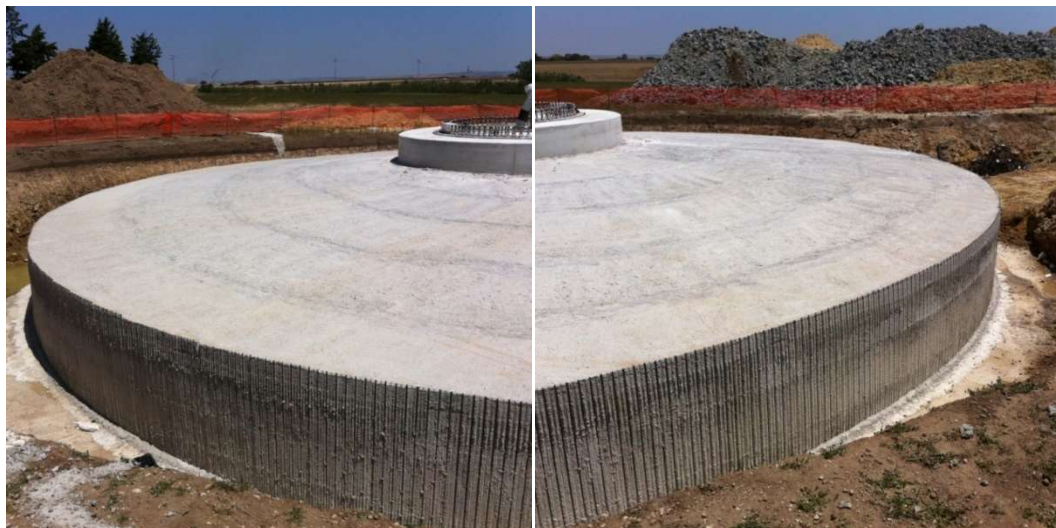
Fig. 1.3 - Tipico fondazione a plinto
