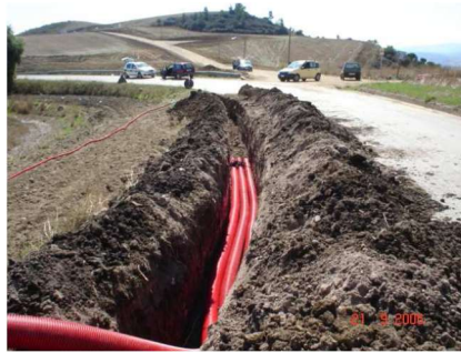
Fig. 1.5 - Foto illustrativa della messa in posa dei cavidotti MT
