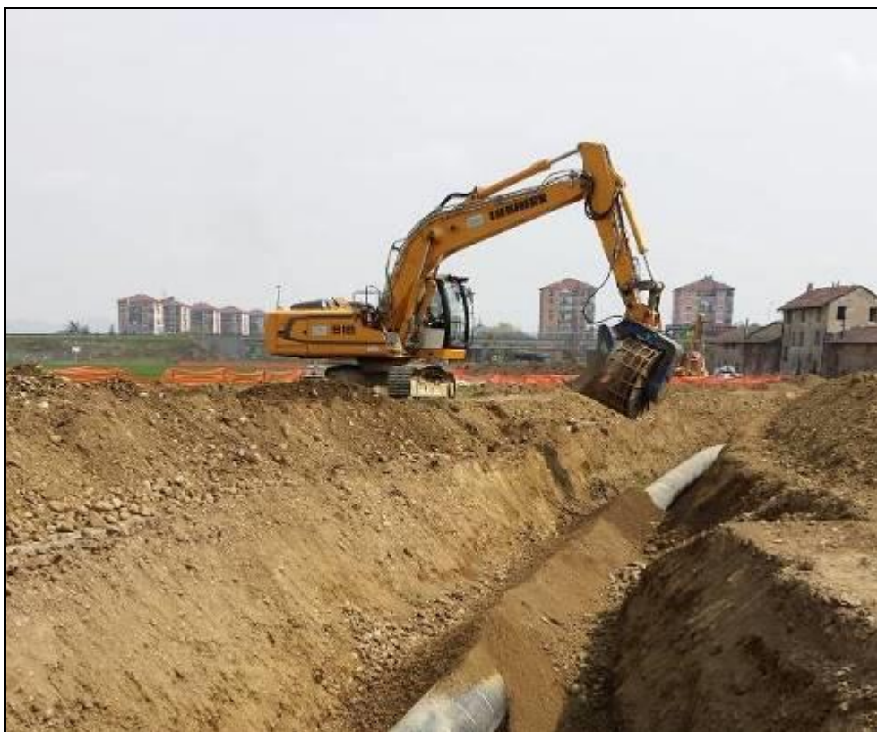
Fig. 5.1/H: Rinterro della condotta
