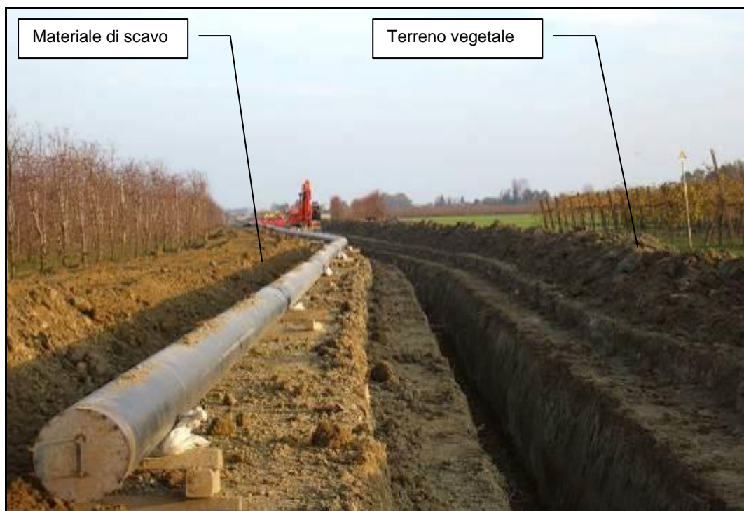
Fig. 5.1/F: Scavo della trincea
