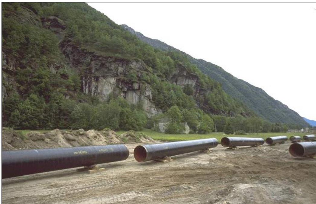
Fig. 5.1/C: Sfilamento tubi
