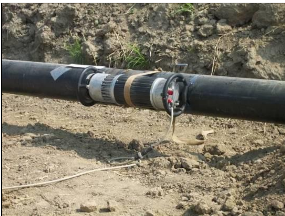
Fig. 5.1/E: Controlli non distruttivi delle saldature
