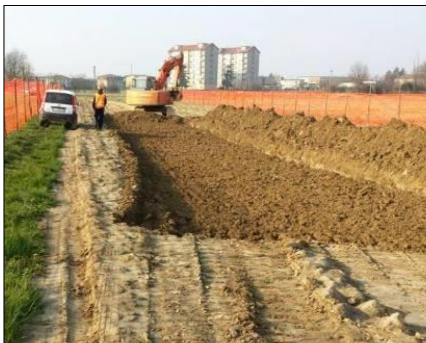
Fig. 5.1/B: Apertura della pista di lavoro
