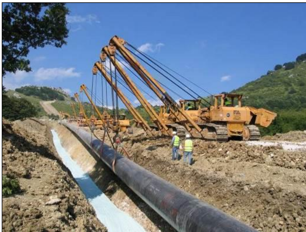
Fig. 5.1/G: Posa della condotta
