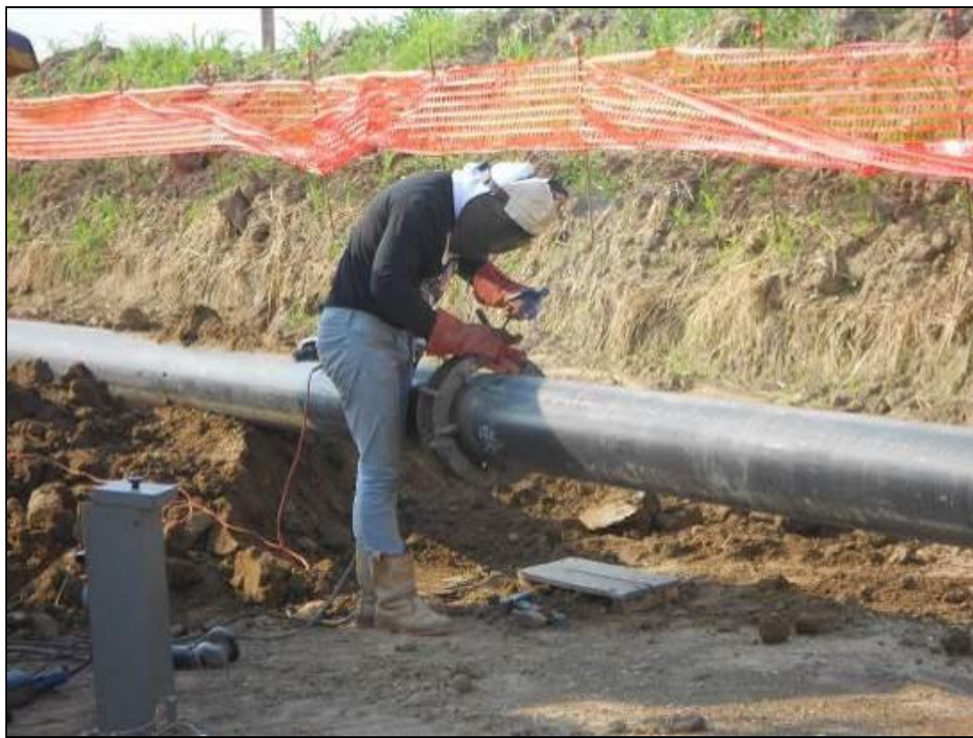
Fig. 5.1/D: Saldatura della tubazione
