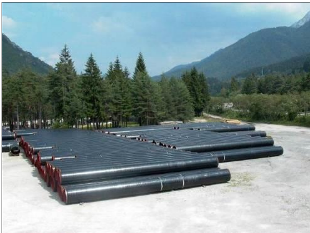
Fig. 5.1/A: Piazzola di accatastamento tubazioni
