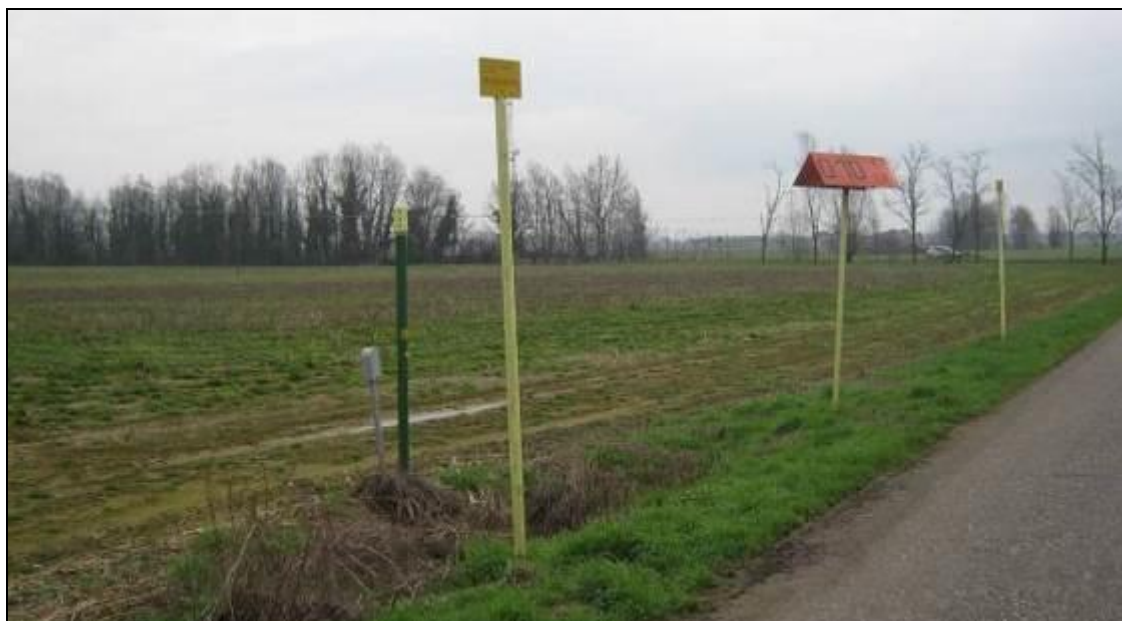
Fig. 11/A: Cartelli segnalatori, cassetta a piantana e tubo di sfiato
