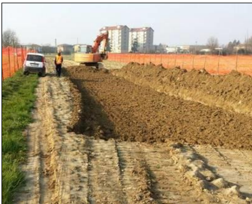
Fig. 9.1/B: Apertura della pista di lavoro
