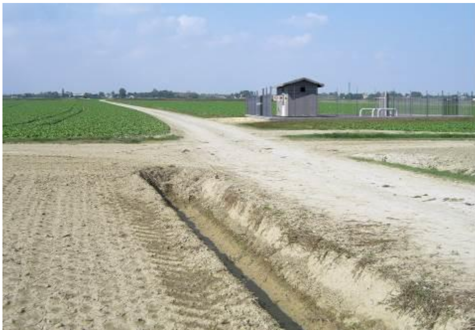
Fig. 4.3/B - Impianto su seminativo, fase di cantiere
