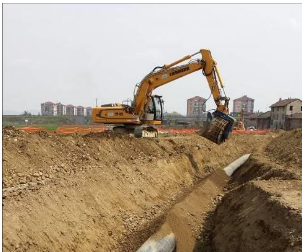
Fig. 9.1/H: Rinterro della condotta
