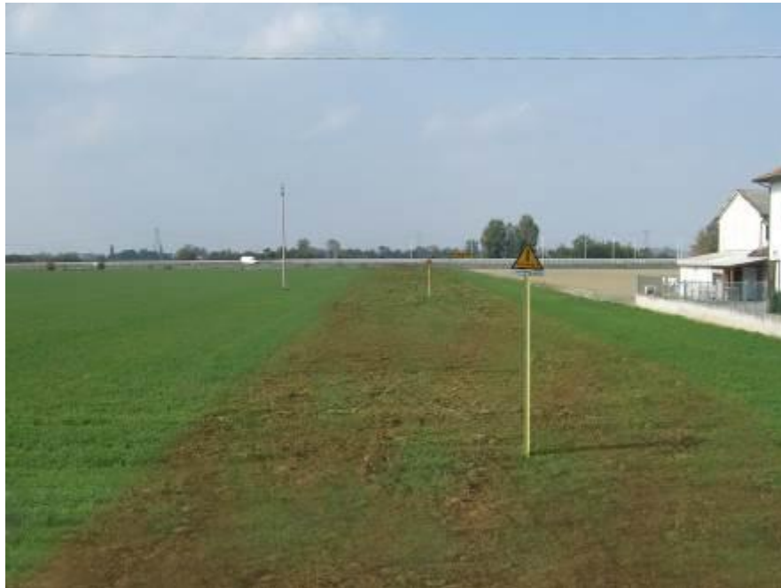
Fig. 4.1/C - Lavori di linea post-operam
