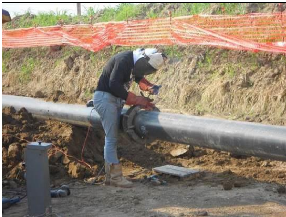
Fig. 9.1/D: Saldatura della tubazione
