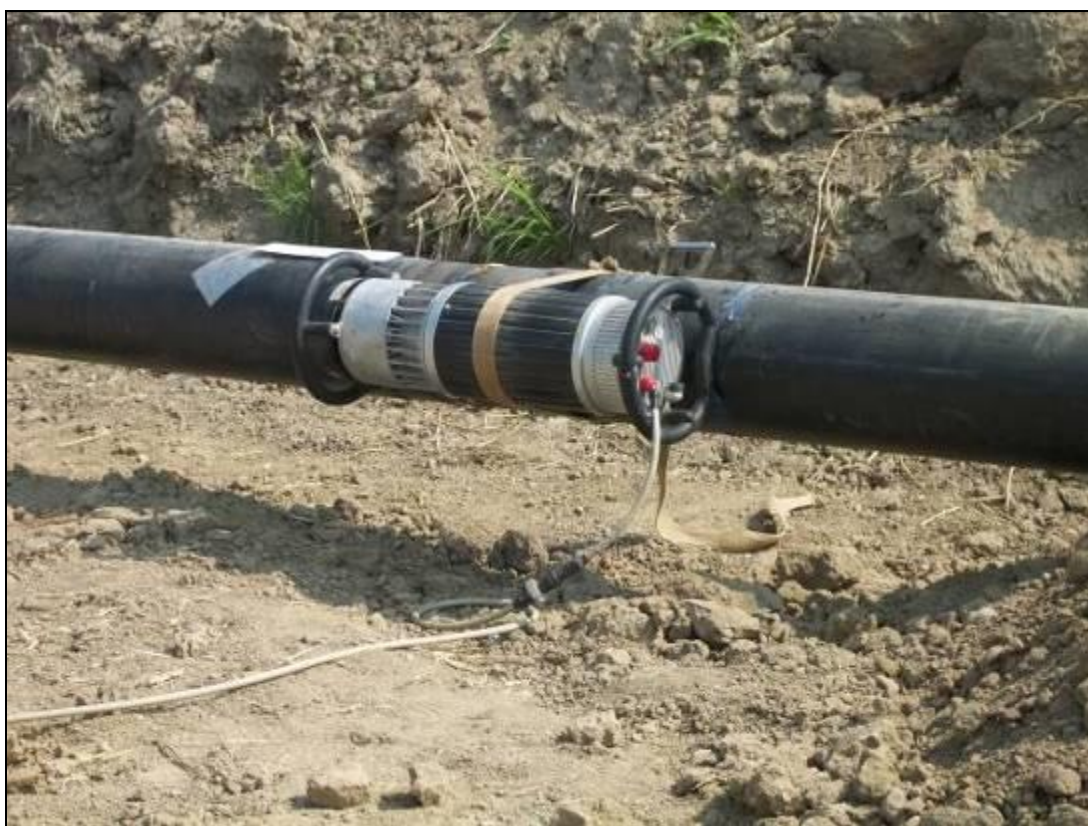
Fig. 9.1/E: Controlli non distruttivi delle saldature
