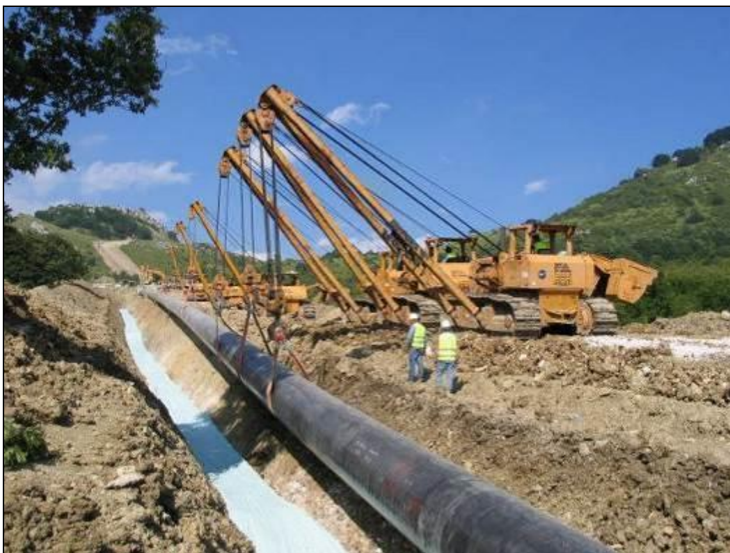
Fig. 9.1/G: Posa della condotta
