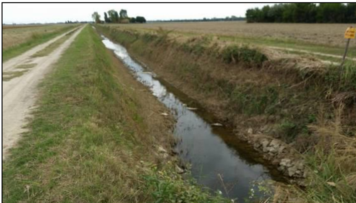
Foto n. 2.2.1/C – Canale secondario (Can. Acque Basse Rasponi)
