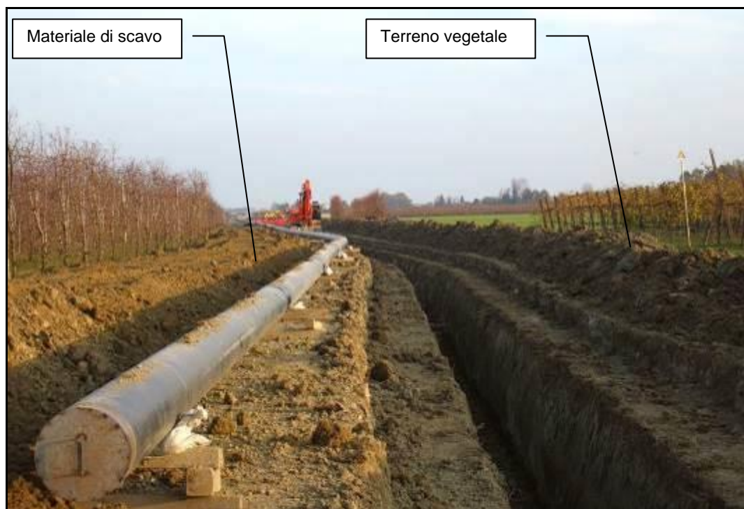
Fig. 9.1/F: Scavo della trincea
