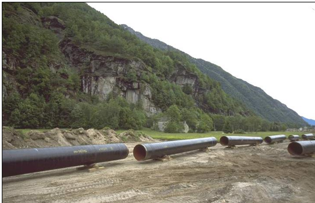
Fig. 9.1/C: Sfilamento tubi
