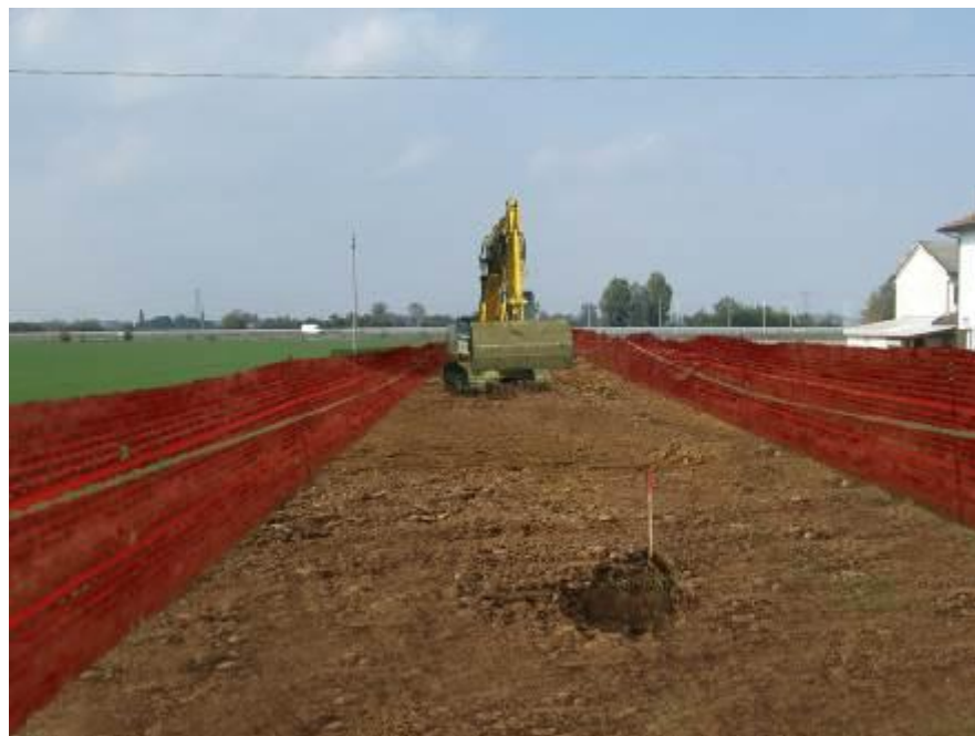
Fig. 4.1/B - Lavori di linea fase di cantiere
