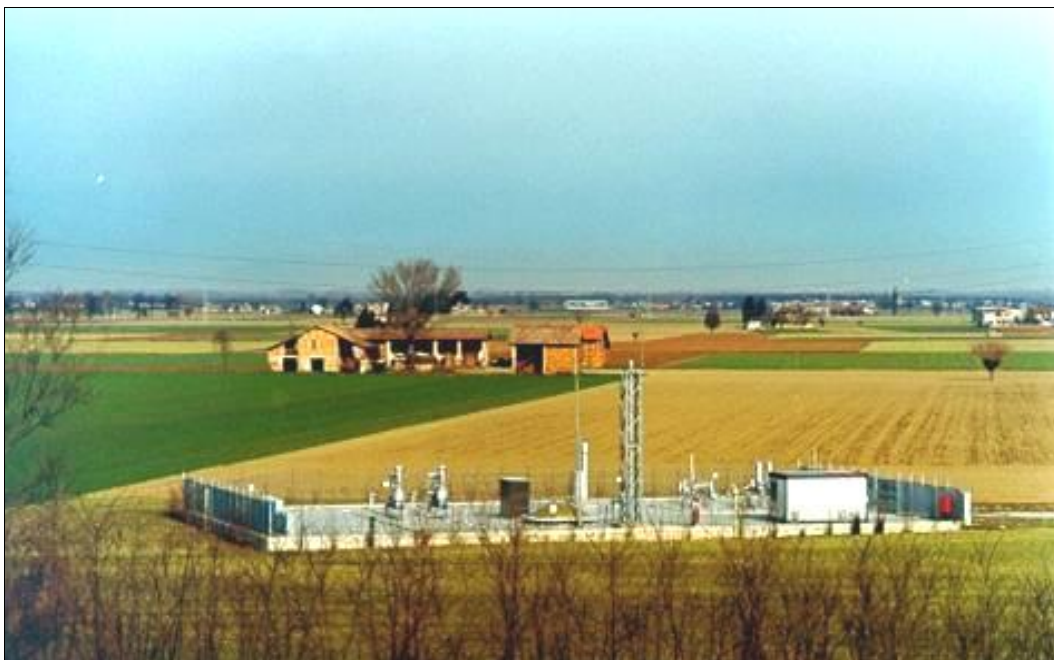
Fig. 9.1/P: Installazione tipo impianto di regolazione/riduzione
