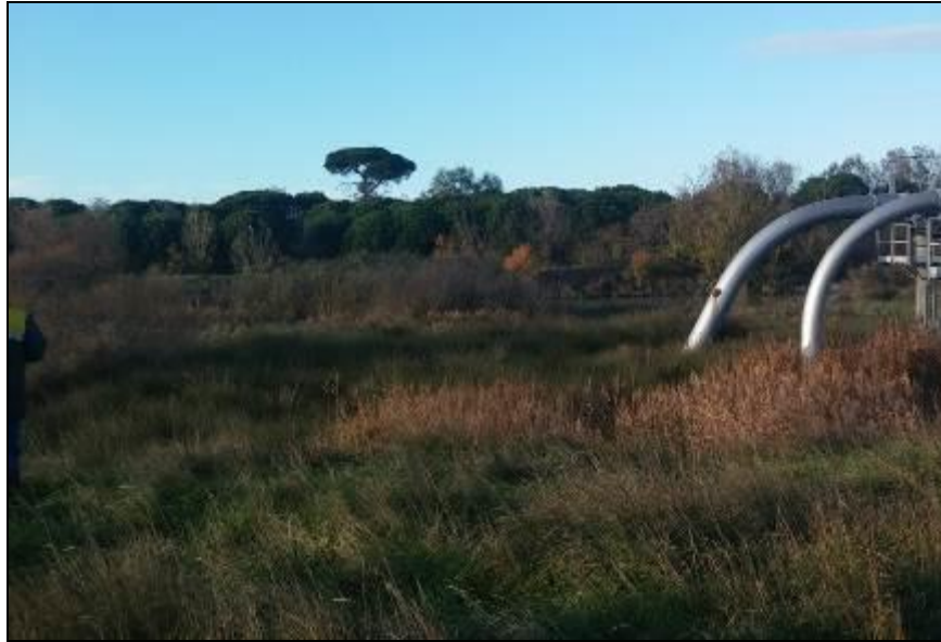
Foto 2.4.4/E - Area SIC-ZPS con condotte da dismettere - km 5,000
