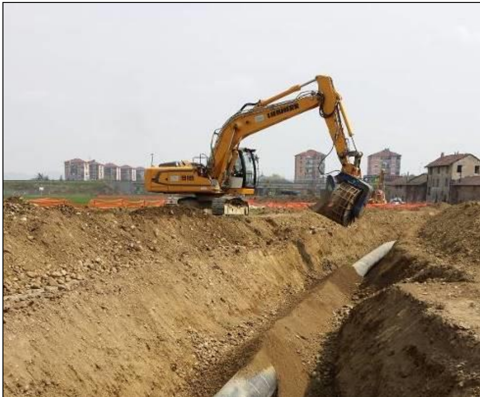
Fig. 5.1/H: Rinterro della condotta
