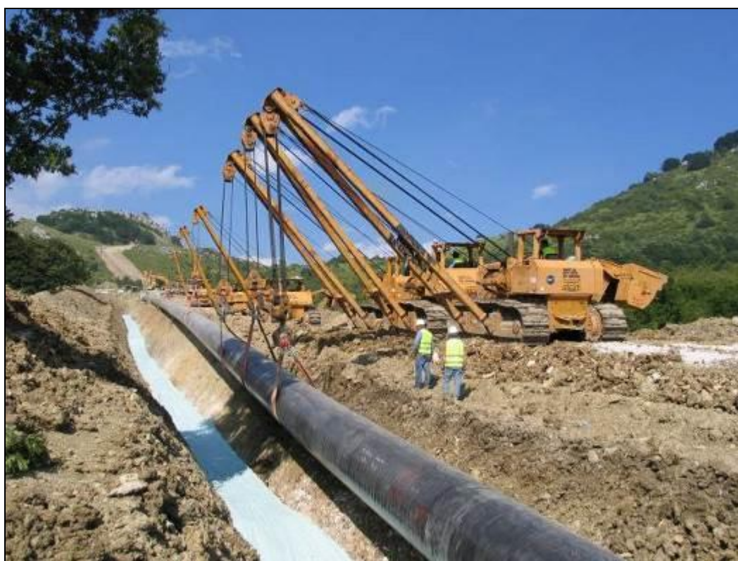
Fig. 5.1/G: Posa della condotta
