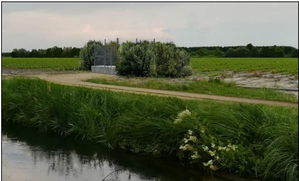
Fig. 9/C: Impianto tipo PIL
