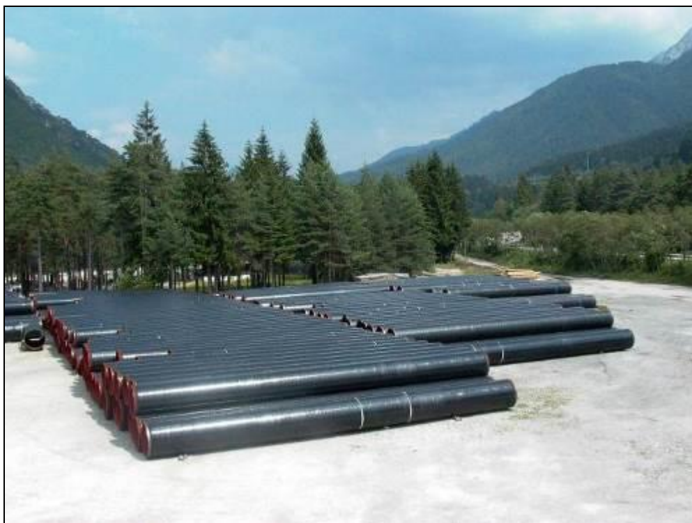
Fig. 5.1/A: Piazzola di accatastamento tubazioni
