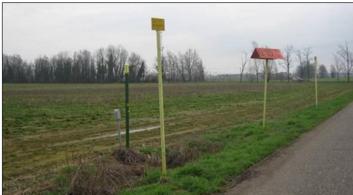
Fig. 9/A: Cartelli segnalatori, cassetta a piantana e tubo di sfiato
