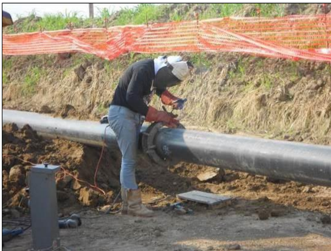
Fig. 5.1/D: Saldatura della tubazione
