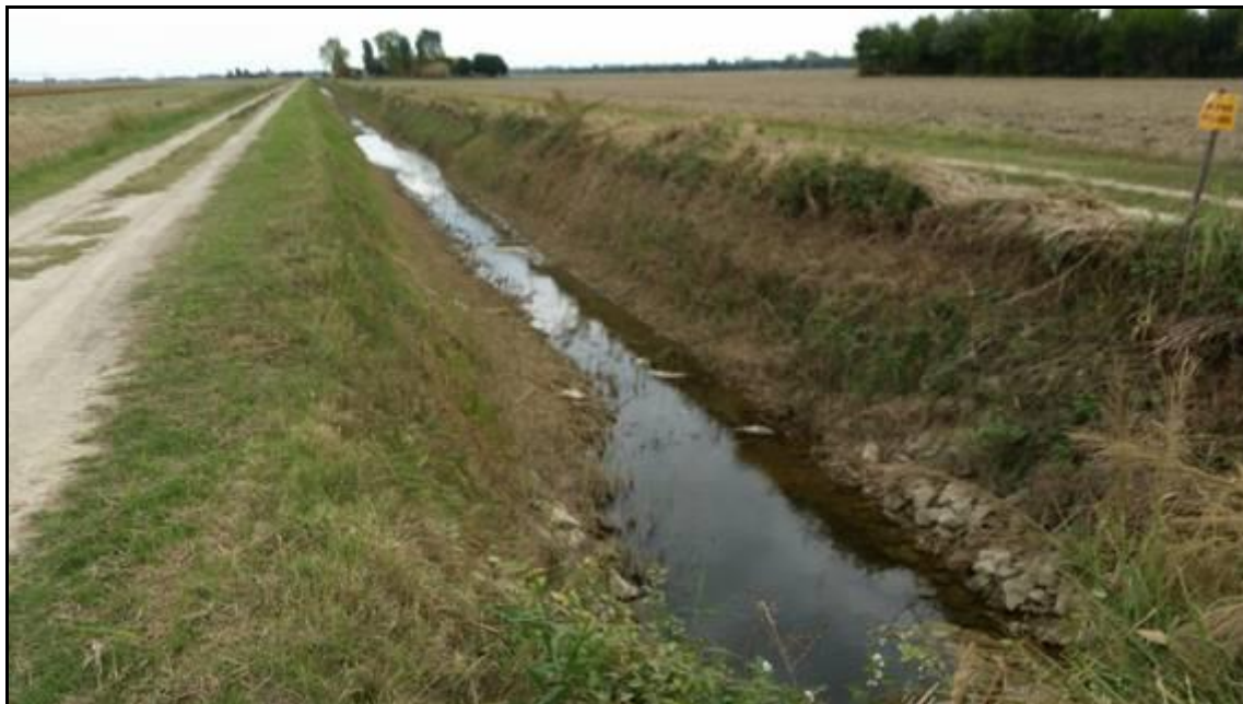
Foto n. 2.2.1/C – Canale secondario (Can. Acque Basse Rasponi)
