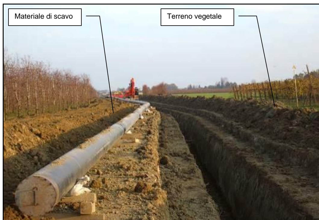
Fig. 5.1/F: Scavo della trincea
