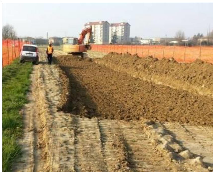
Fig. 5.1/B: Apertura della pista di lavoro
