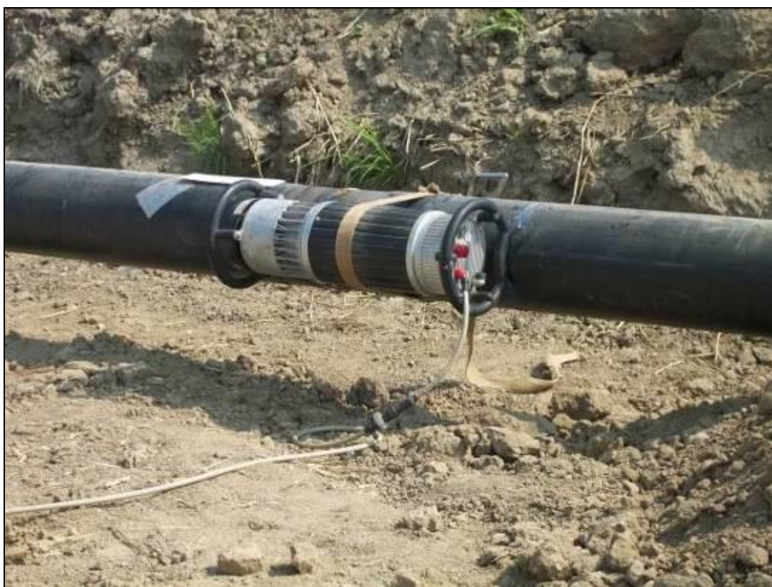
Fig. 5.1/E: Controlli non distruttivi delle saldature
