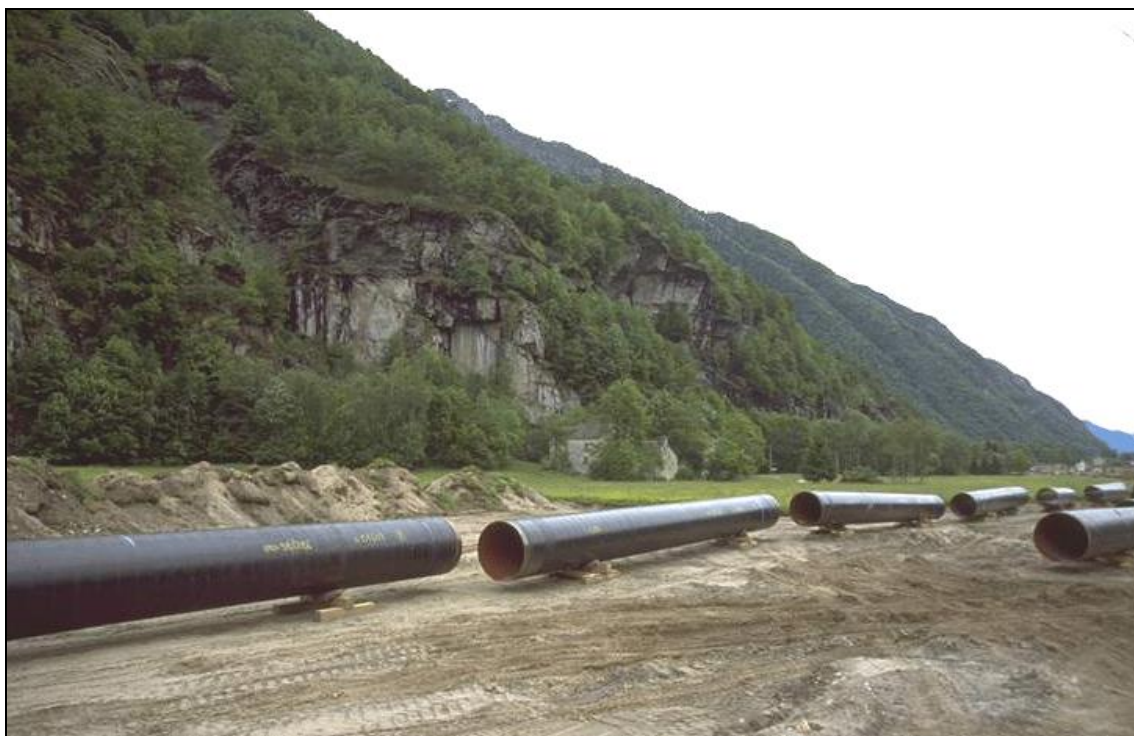
Fig. 5.1/C: Sfilamento tubi
