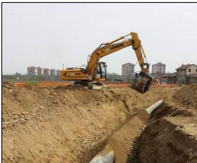
**Fig. 2.3/D: Rinterro della condotta**
