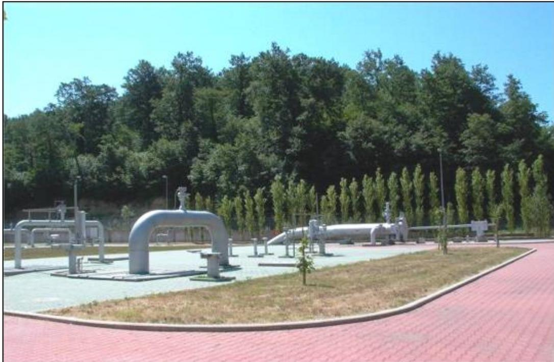
**Fig. 2.3/I: Installazione tipo stazione di lancio e ricevimento PIG**
