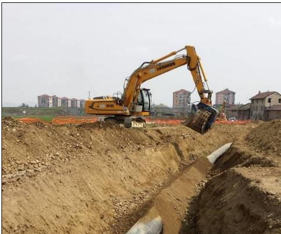
Fig. 2.5/H: Rinterro della condotta
