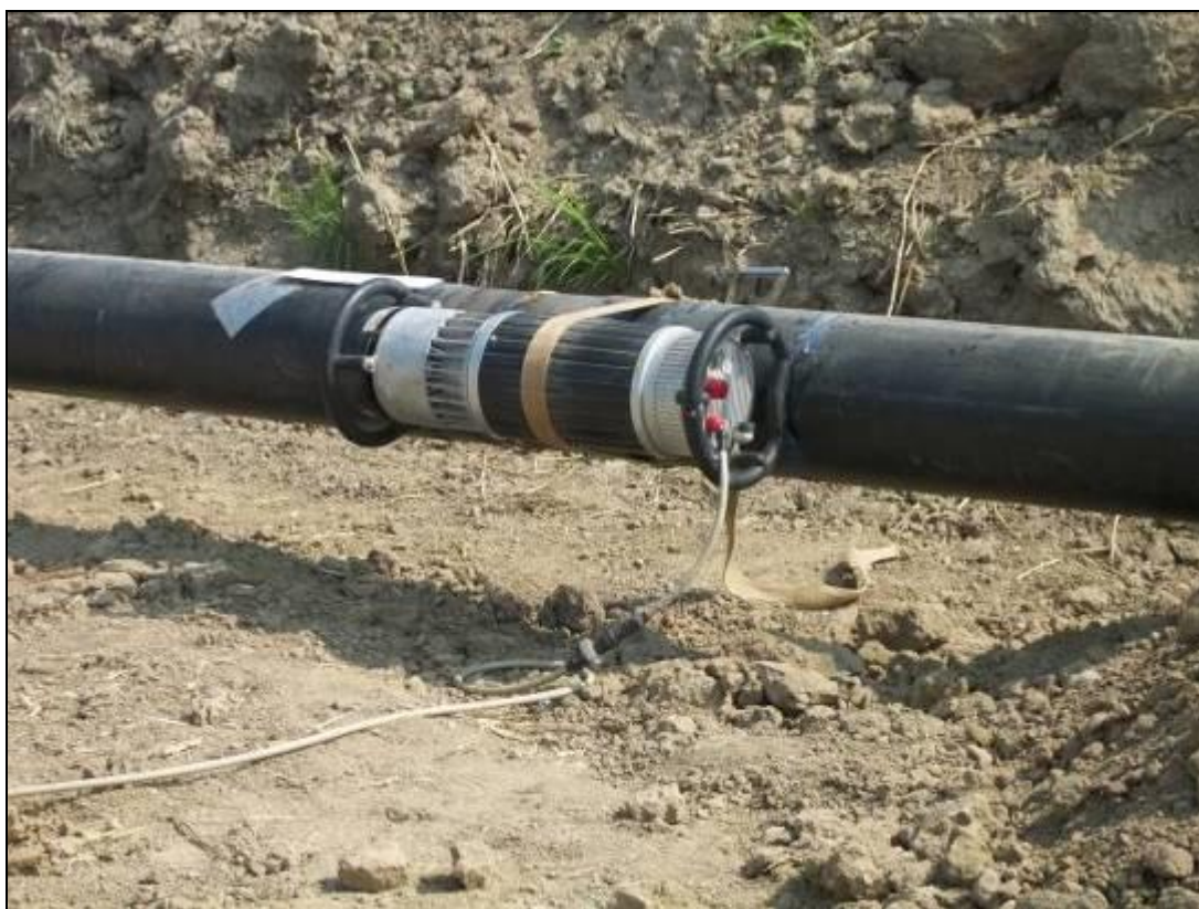
Fig. 2.5/E: Controlli non distruttivi delle saldature
