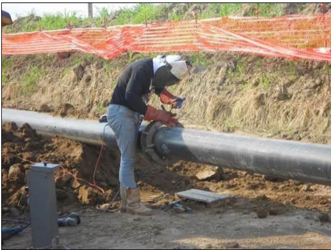
Fig. 2.5/D: Saldatura della tubazione
