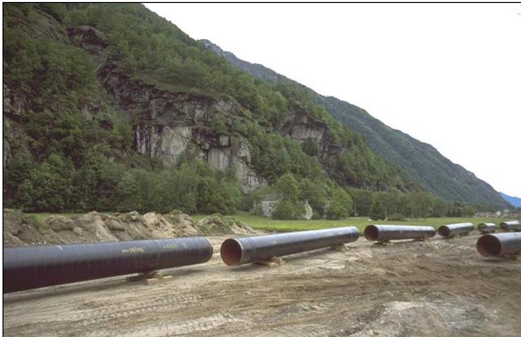
Fig. 2.5/C: Sfilamento tubi
