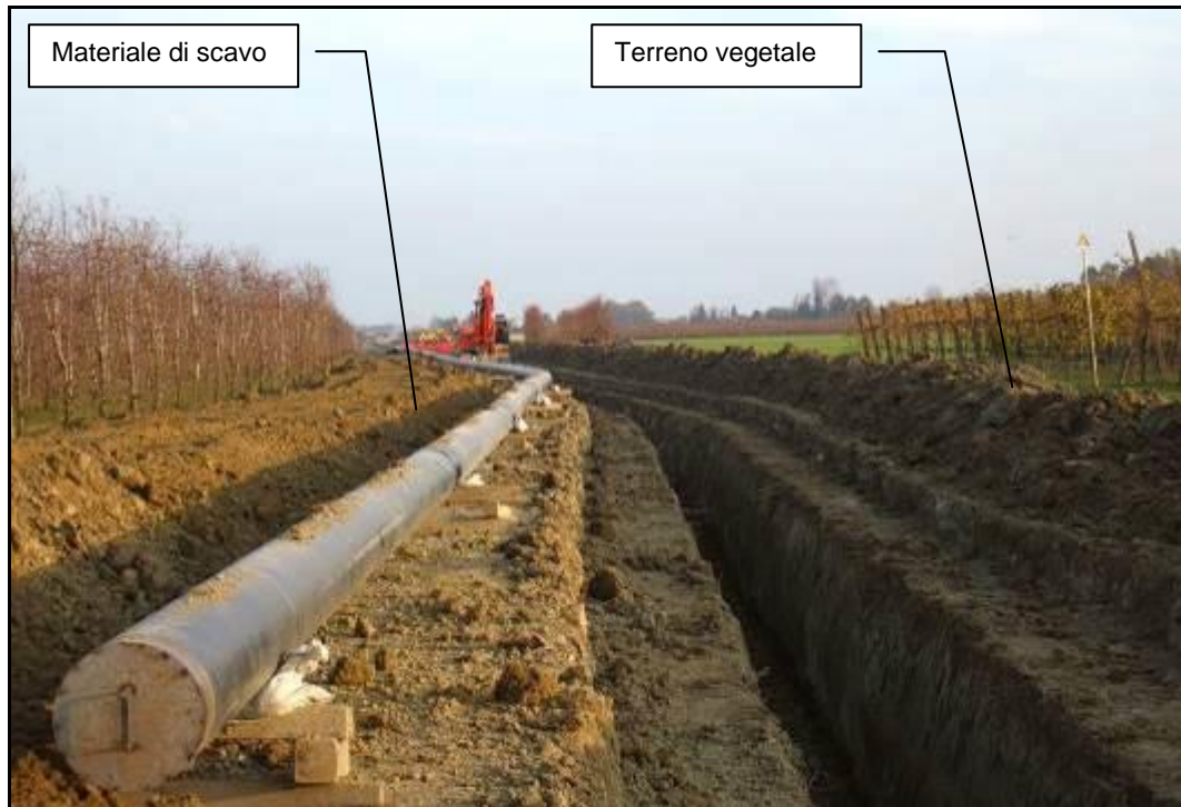
Fig. 2.5/F: Scavo della trincea
