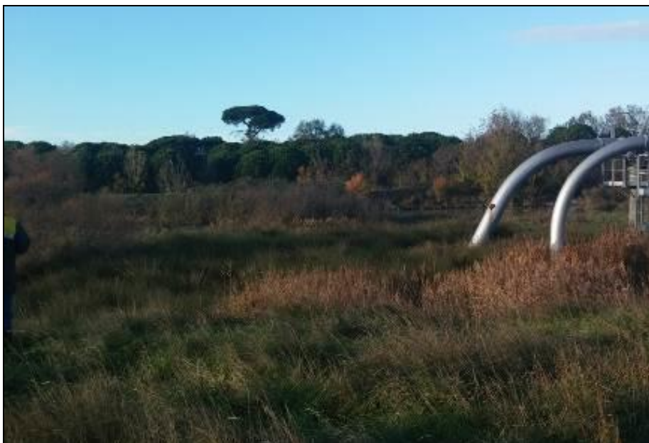
Foto 4.2/A - Area SIC-ZPS con condotte ed attraversamenti aerei di corsi d'acqua da dismettere
