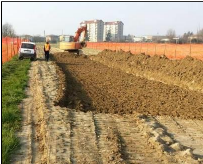
Fig. 2.5/B: Apertura della pista di lavoro
