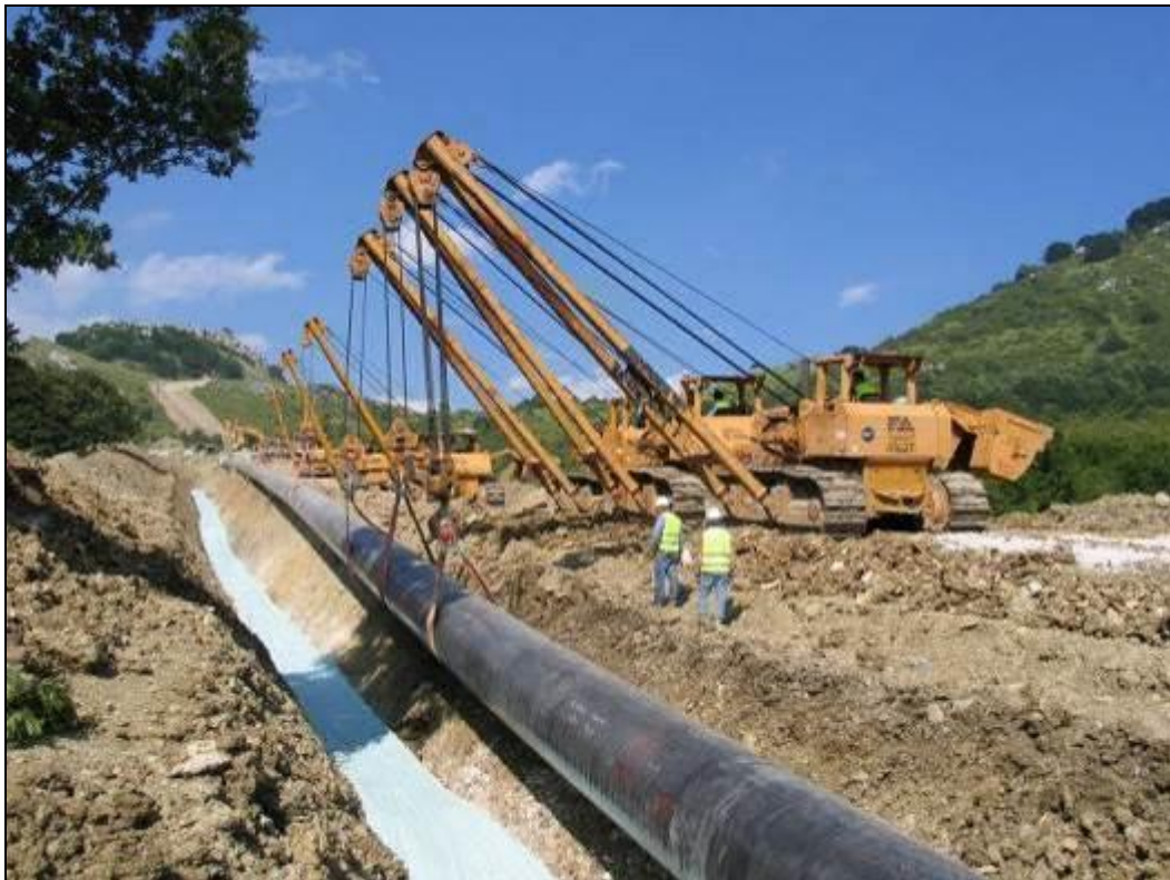
Fig. 2.5/G: Posa della condotta
