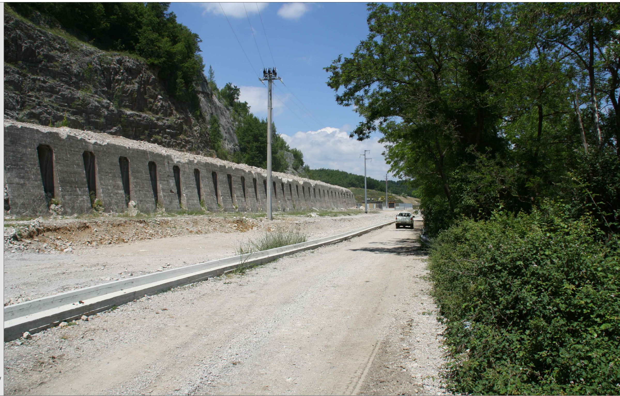
STATO DEI LUOGHI PRIVO DI OPERE DI MITIGAZIONE / RIPRISTINO AMBIENTALE
