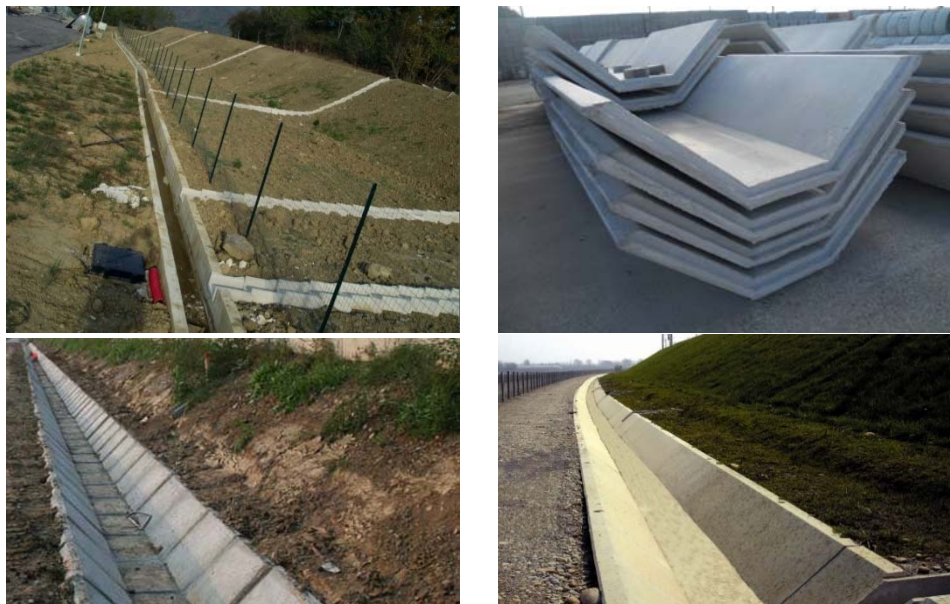
Figura 7-15 Tipologico fossi di guardia perimetrali al cantiere
