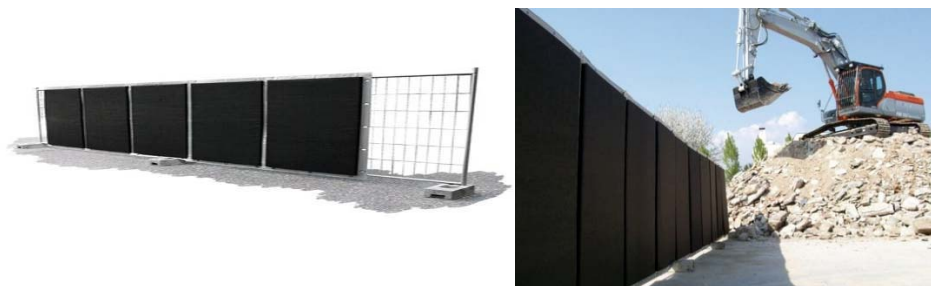
Figura 9-2 Esempio di barriere mobili di tipo fonoassorbente
