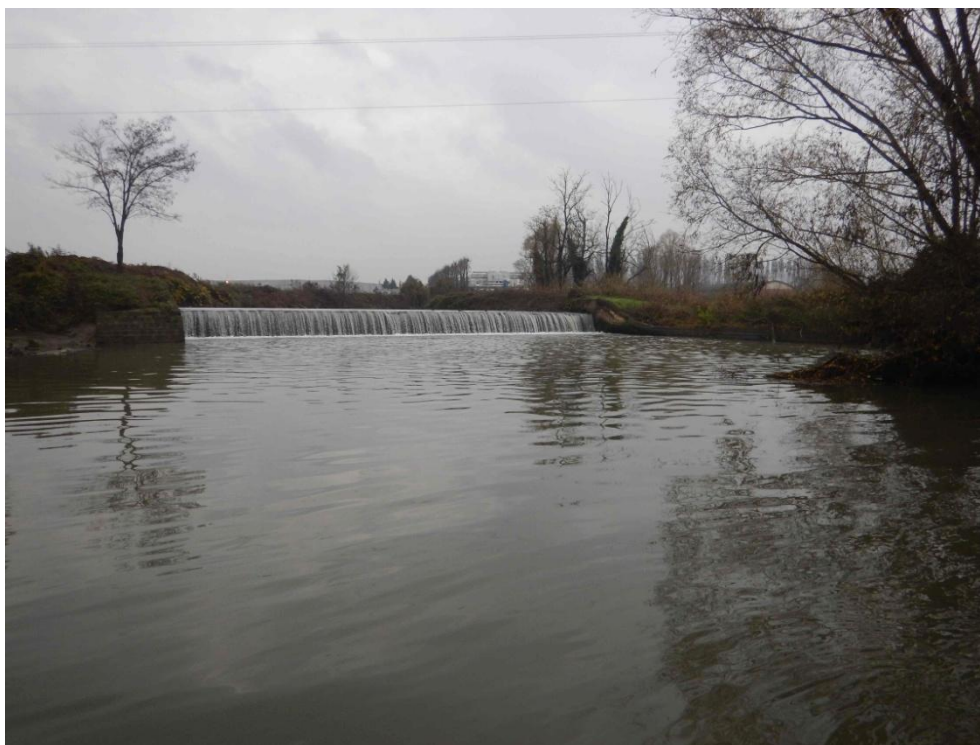
Figura 41. Stazione di campionamento ADT02 del Colatore Addetta.
