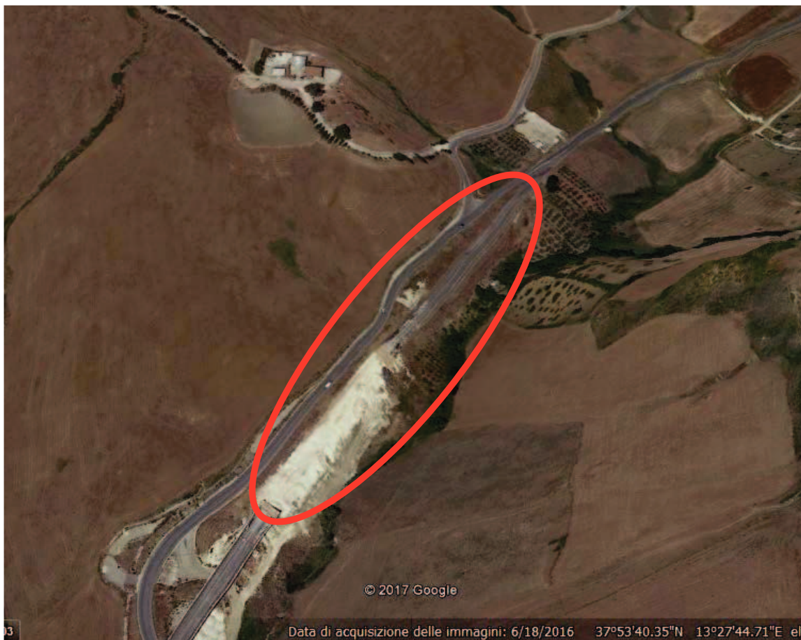
Fig. 2.3. Dettaglio del tratto di sede stradale della S.S. 121 oggetto dell'intervento di rifacimento. Nella ripresa è visibile il tratto terminale del Viadotto Scorciavacche 2 e il rilevato di approccio sul lato nord, in parte asportato nel corso delle indagini svolte per gli accertamenti giudiziari (Immagine tratta da Google Earth, 2017).
