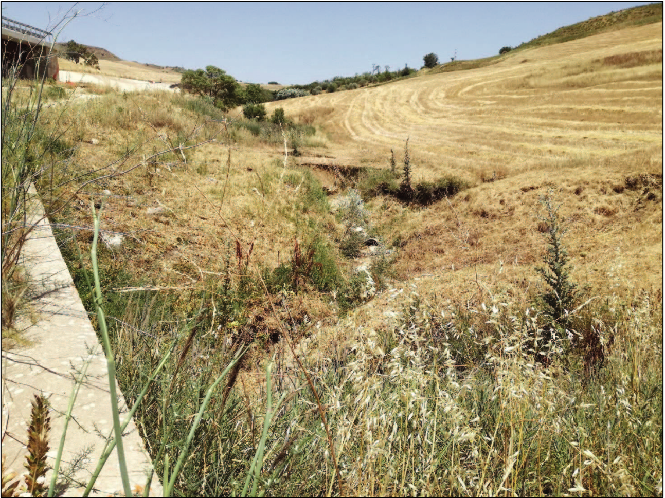
Figura 7. Particolare della tubazione diametro 80 cm esistente vista da attraversamento S.P. 55.
