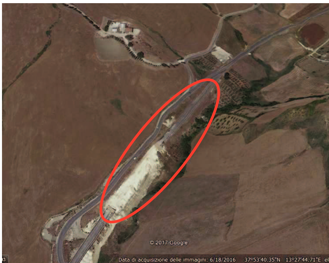
Figura 4 Dettaglio del tratto di sede stradale della S.S. 121 oggetto dell'intervento di rifacimento. Nella ripresa è visibile il tratto terminale del Viadotto Scorciavacche 2 e il rilevato di approccio sul lato nord, in parte asportato nel corso delle indagini svolte per gli accertamenti giudiziari (Immagine tratta da Google Earth, 2017).
