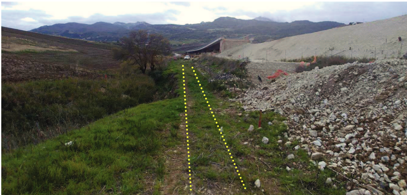
Figura 7 Immagine dell'area ove saranno eseguiti gli interventi; vista da NNE; le tracce gialle indicano, all'incirca, l'allineamento delle paratie di pali.
