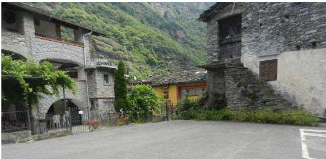
Figura 102: edifici realizzati con tecnologia tradizionale nel borgo di Praie
