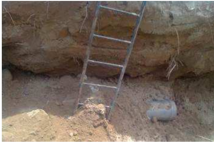
Figura 11: particolare scavo per opera di depurazione in località Praie (ripresa in data 18.05.2011)
