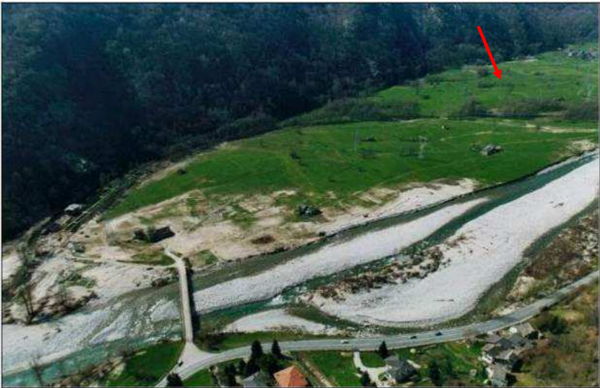
Figura 19: effetti di modellamento alluvionale del T.Orco, evento ottobre 2000; tratto compreso tra Nosè e Praie; la freccia rossa indica la zona di prevista realizzazione dell'impianto di trattamento e potabilizzazione. Fonte: Tesi di Laurea Politecnico di Torino, F.Pellissier, 2005
