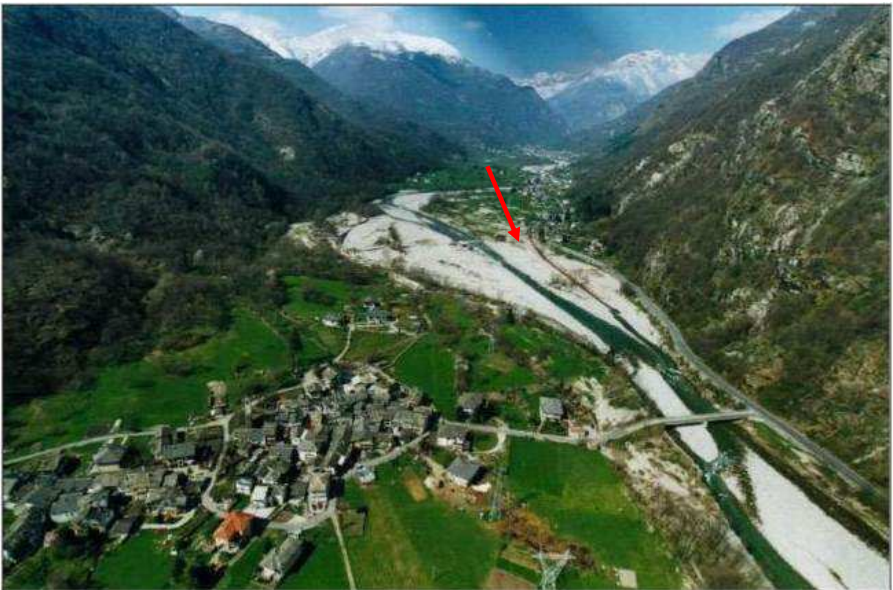
Figura 12: effetti di modellamento alluvionale del T.Orco, evento ottobre 2000; tratto compreso tra Praie (in primo piano) e Bardonetto (sullo sfondo); la freccia rossa indica la zona di prevista realizzazione dell'opera di derivazione. Fonte: Tesi di Laurea Politecnico di Torino, F.Pellissier, 2005
